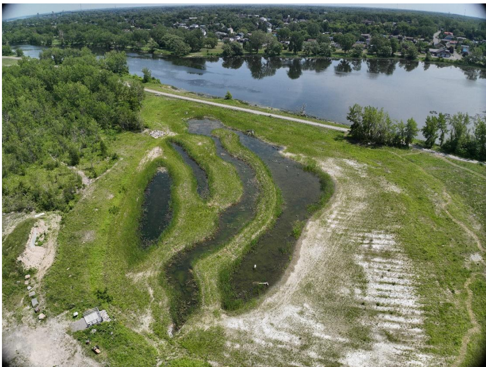
Figure 29: Marais et bassin linéaire – 17-06-2024
