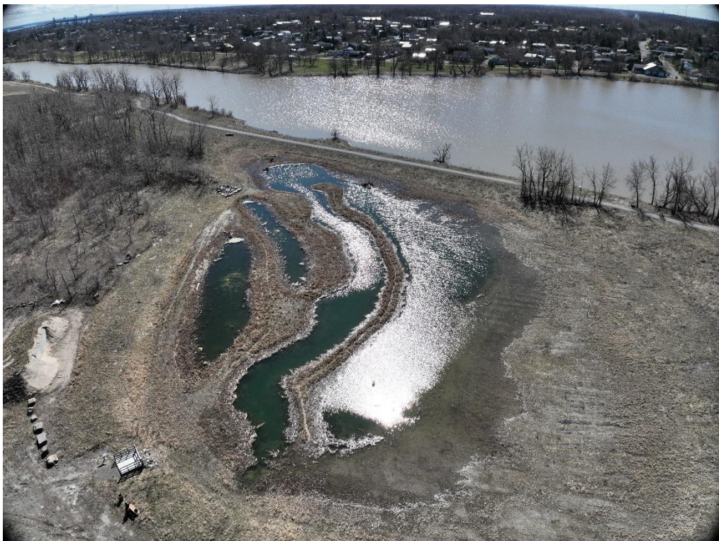
Figure 27: Marais et bassin linéaire – 16-04-2024
