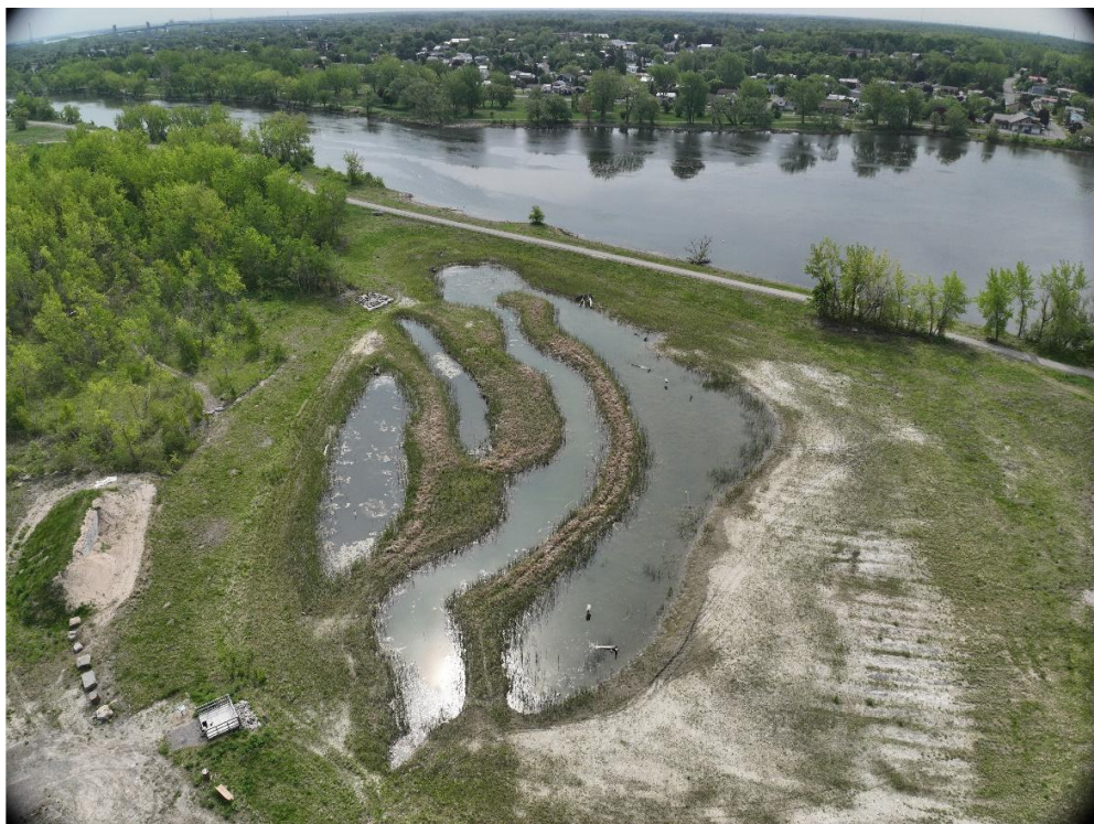
Figure 28: Marais et bassin linéaire – 21-05-2024
