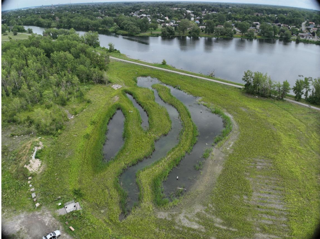
Figure 30: Marais et bassin linéaire – 12-07-2024
