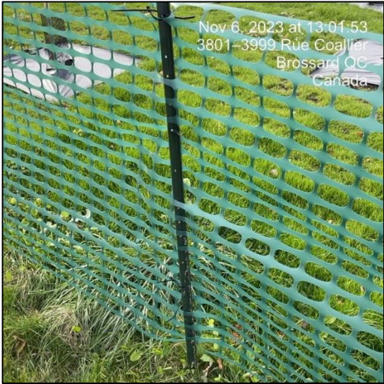
Exemple de renforcement de la clôture
