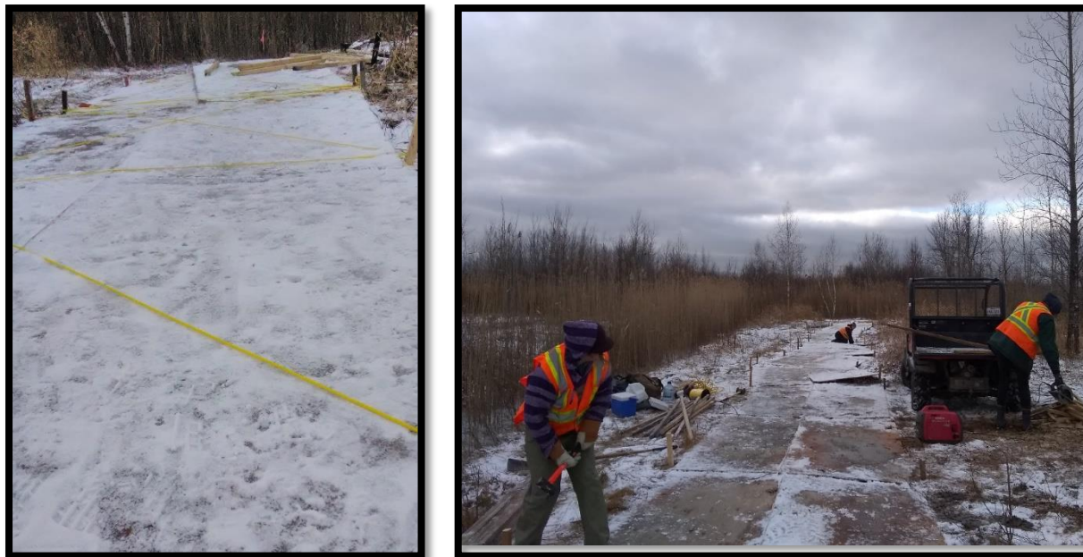
Figure 19 : Fixation des planches du chemin temporaire
