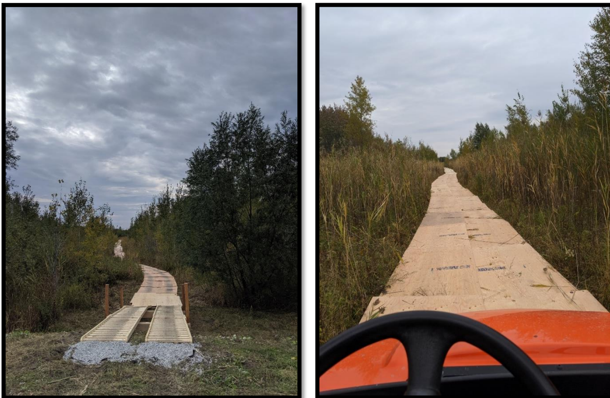
Figure 6 : Construction du pont et du chemin temporaires
