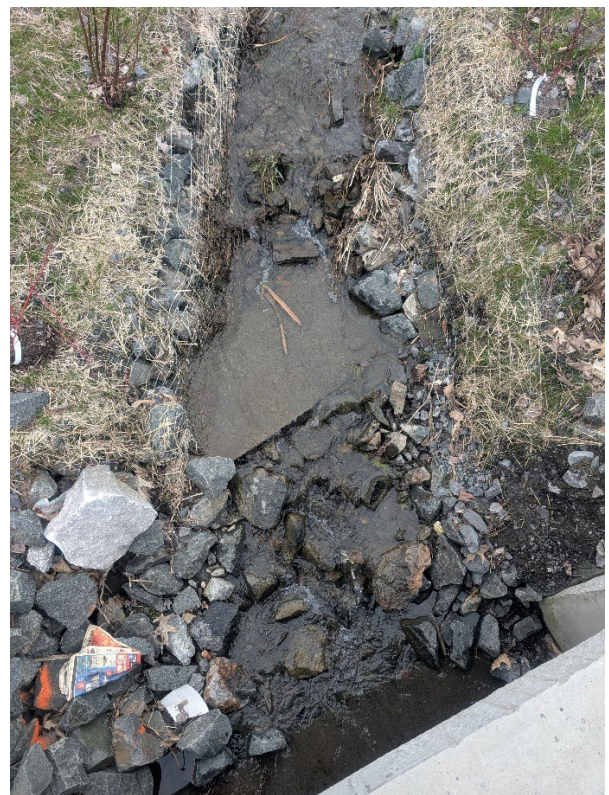
25 avril 2025. : Vue sur le massif de Bell et l'énrochement.
