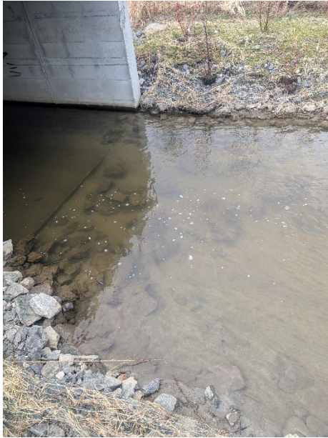
25 avril 2025 : Vue sur le fond du cours d'eau à l'amont du ponceau.
