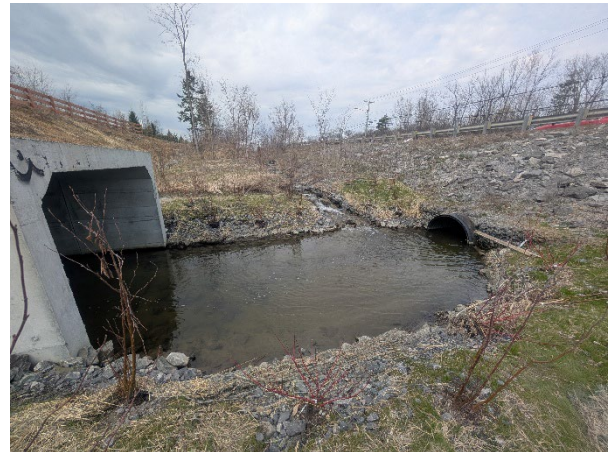
25 avril 2025 : Vue sur la section amont du ponceau, directement au sud du chemin Pink.
