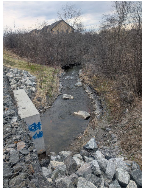
25 avril 2025 : Vue vers l'aval sur la section aval du ponceau
