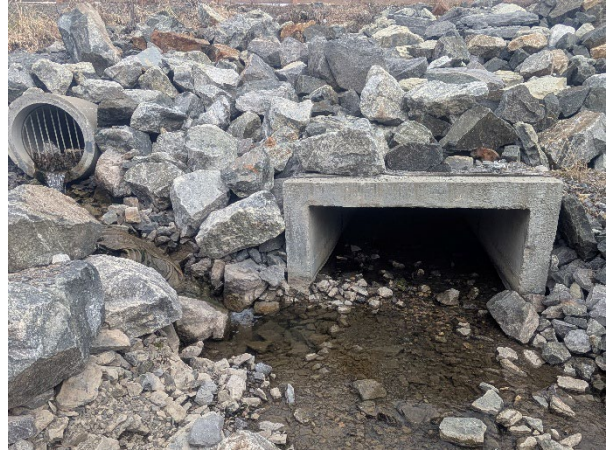
25 avril 2025 : Vue sur l'aval du ponceau et la sortie pluviale adjacente.
