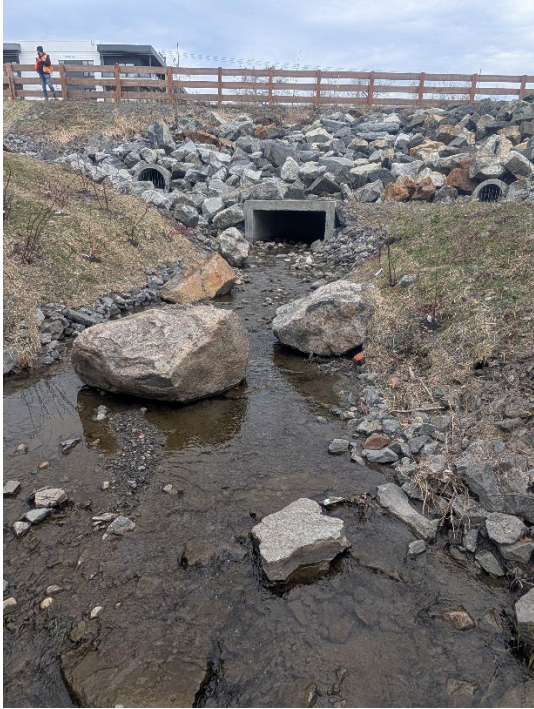
25 avril 2025 : Vue vers l'amont, depuis la fin de la zone des travaux, sur l'aval du ponceau est.
