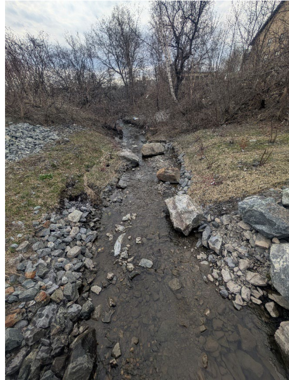
25 avril 2025 : Vue sur le lit du cours d'eau en aval du ponceau.
