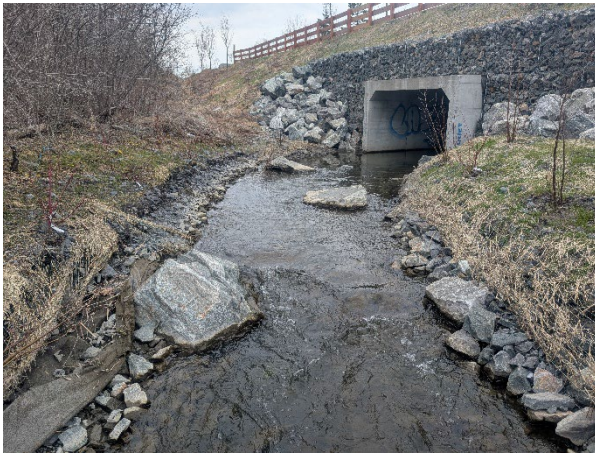
25 avril 2025 : Vue vers l'amont sur la section aval du ponceau.
