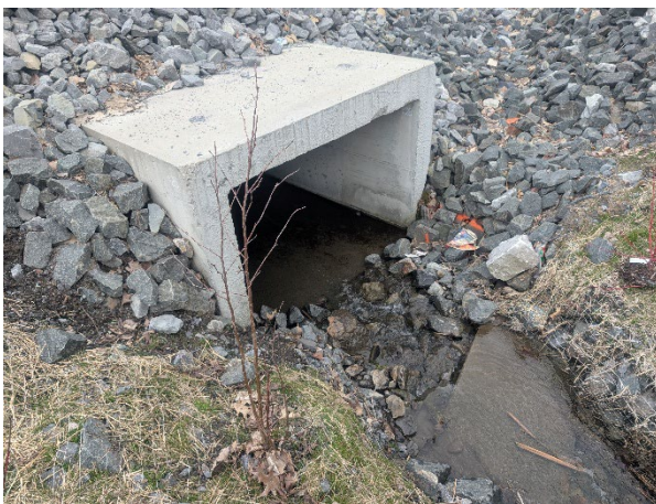
25 avril 2025. : Vue sur l'amont du ponceau.
