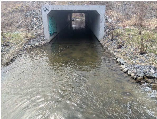
25 avril 2025 : Vue de l'amont sur le ponceau.
