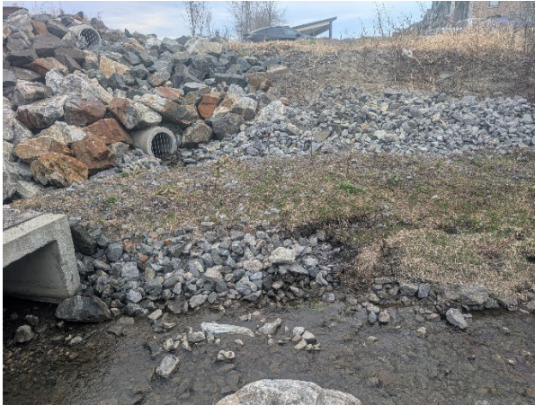
25 avril 2025 : Vue sur la rive est et la sortie pluviale du séparateur hydrodynamique.
