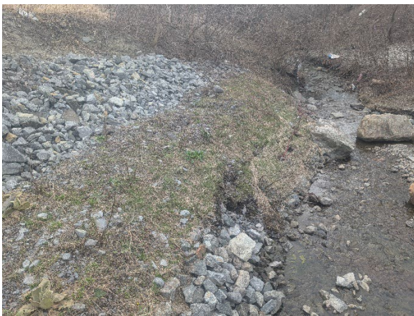
25 avril 2025 : Vue sur la rive est aménagée.
