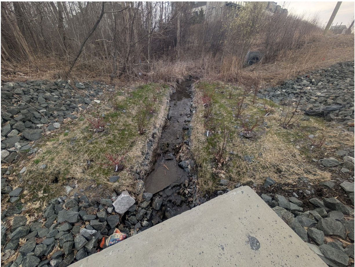
25 avril 2025. : Vue d'ensemble sur la section amont du ponceau 1200mm.
