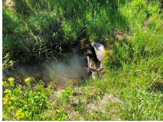
Photo 3.8 Ponceau en béton présent sur le 6-HP-NLP-Rivière Harton (juin 2021)
