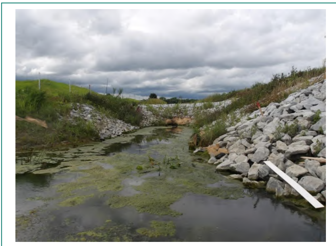
Photo 58 : Aperçu des limites de l'enrochement au transect P07-Aval 5 m (vue vers le nord) - Cours d'eau Edwin
