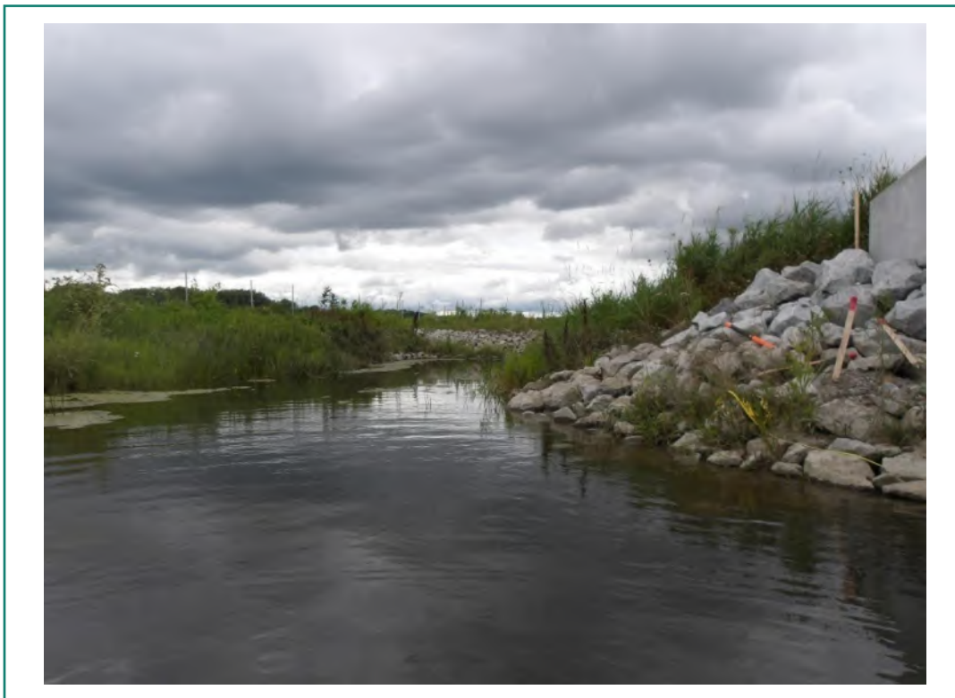
Photo 65 : Aperçu de l'enrochement en berge du côté droit du ruisseau Louis-Rochelleau en aval du ponceau P08
