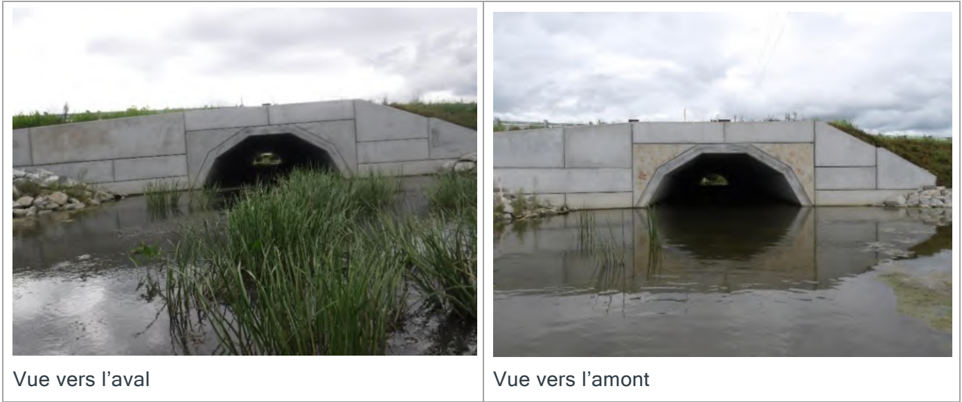
Figure 9 : Ponceau P08 du ruisseau Louis-Rocheleau
