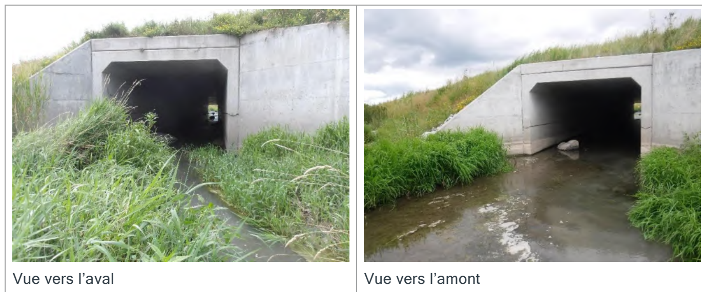
Figure 2 : Ponceau P02 du ruisseau Bélanger
