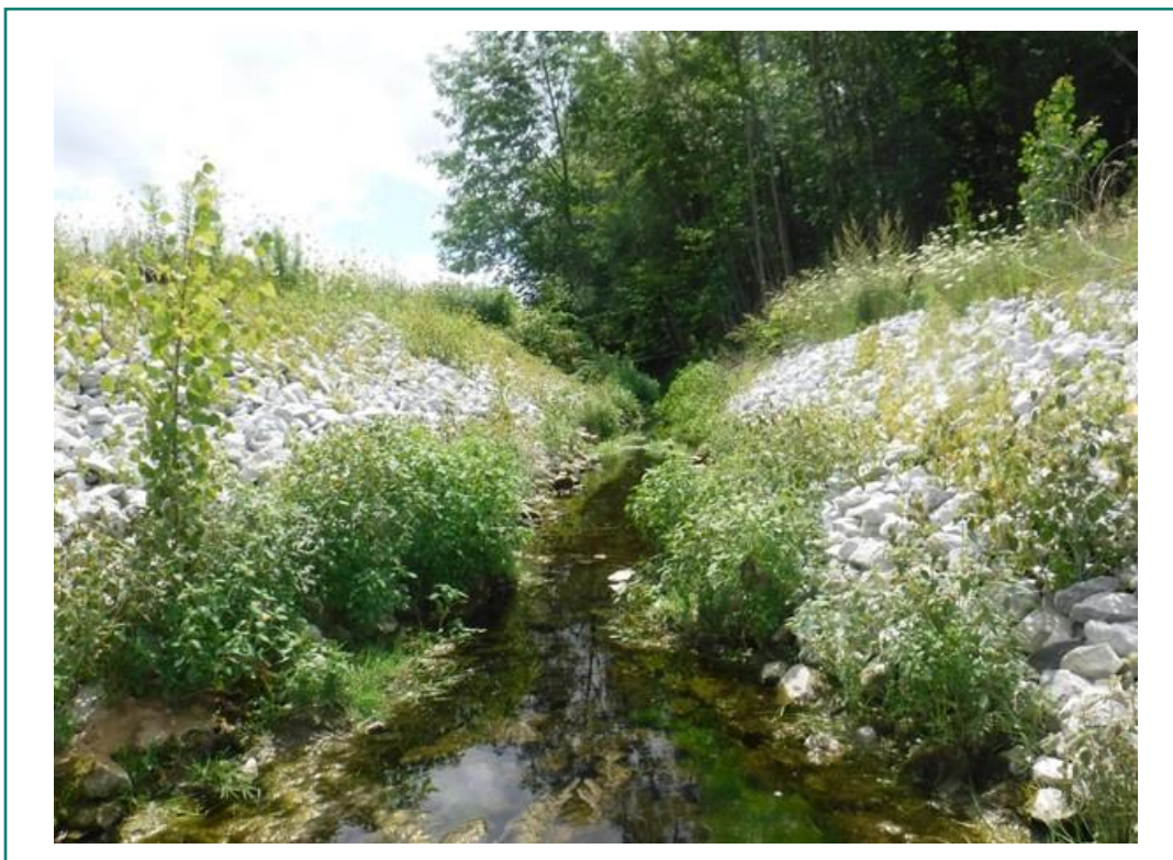
Photo 17 : Aperçu de l'enrochement en berge du ruisseau Desranleau (vue vers l'aval)
