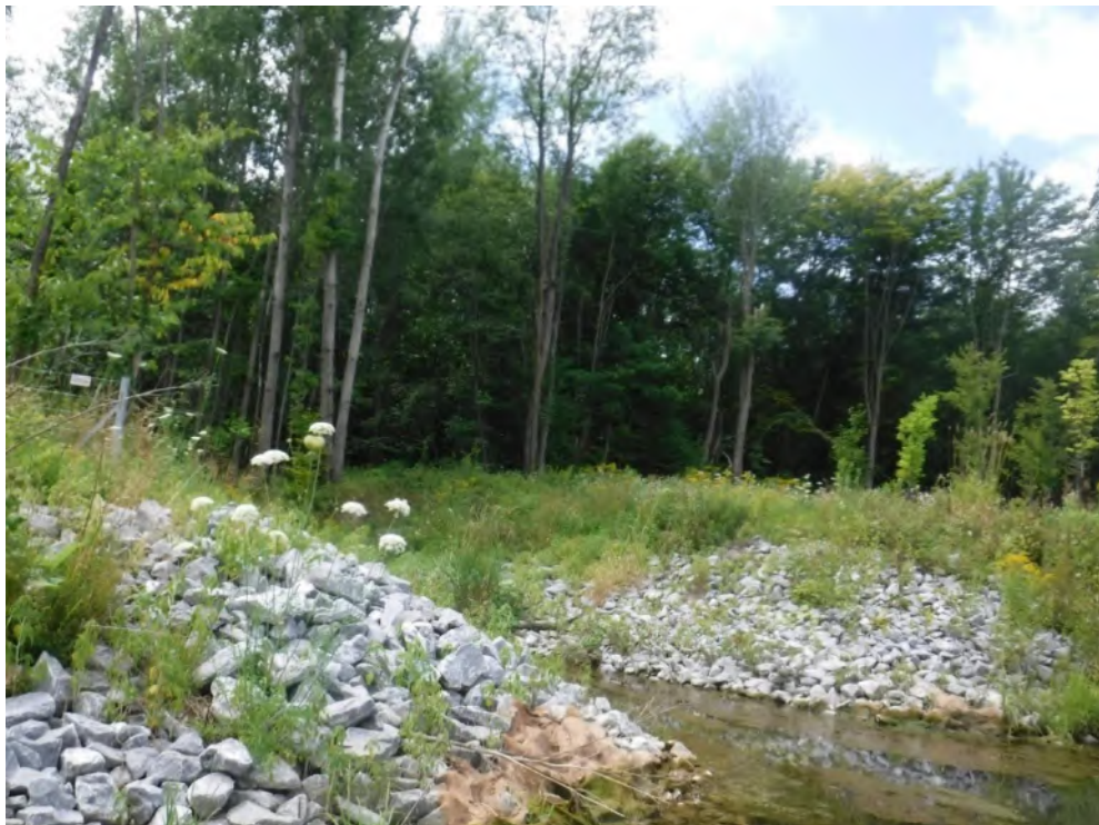
Photo 14 : Aperçu de la rive droite du ruisseau Tipping en aval du ponceau P03
