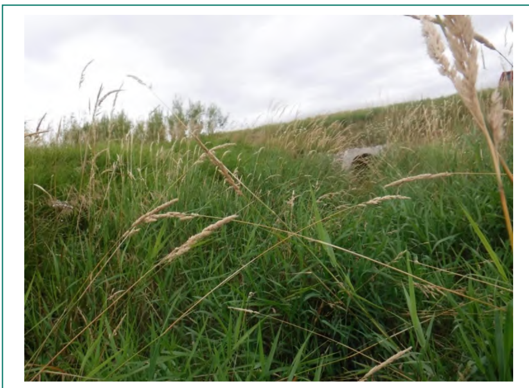
Photo 24 : Aperçu du marais littoral en aval du ponceau P06 (vue vers l'amont) - Ruisseau Bellefroid-Archambault
