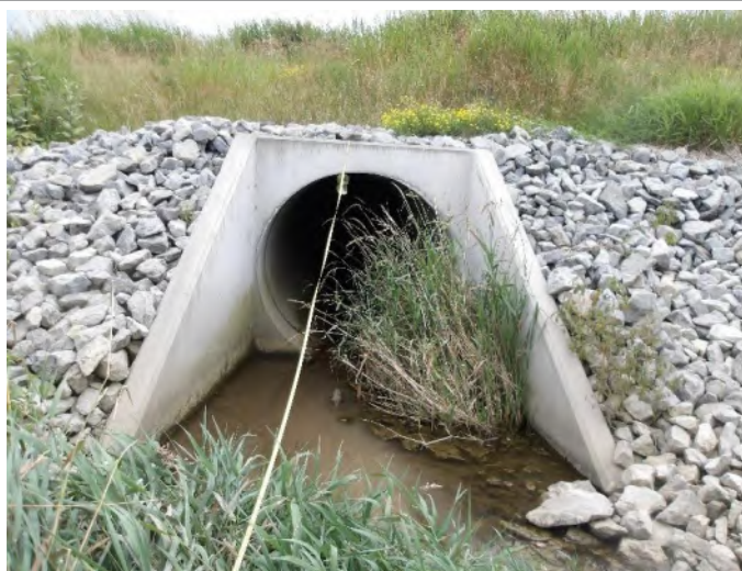
Vue vers l'aval
