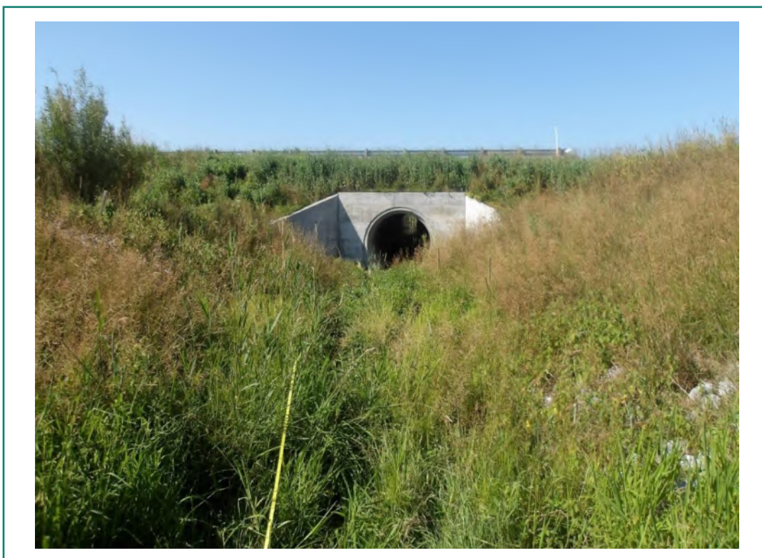
Photo 18 : Aperçu du marais littoral en amont du ponceau P05 - Ruisseau Bellefroid-Dandurand
