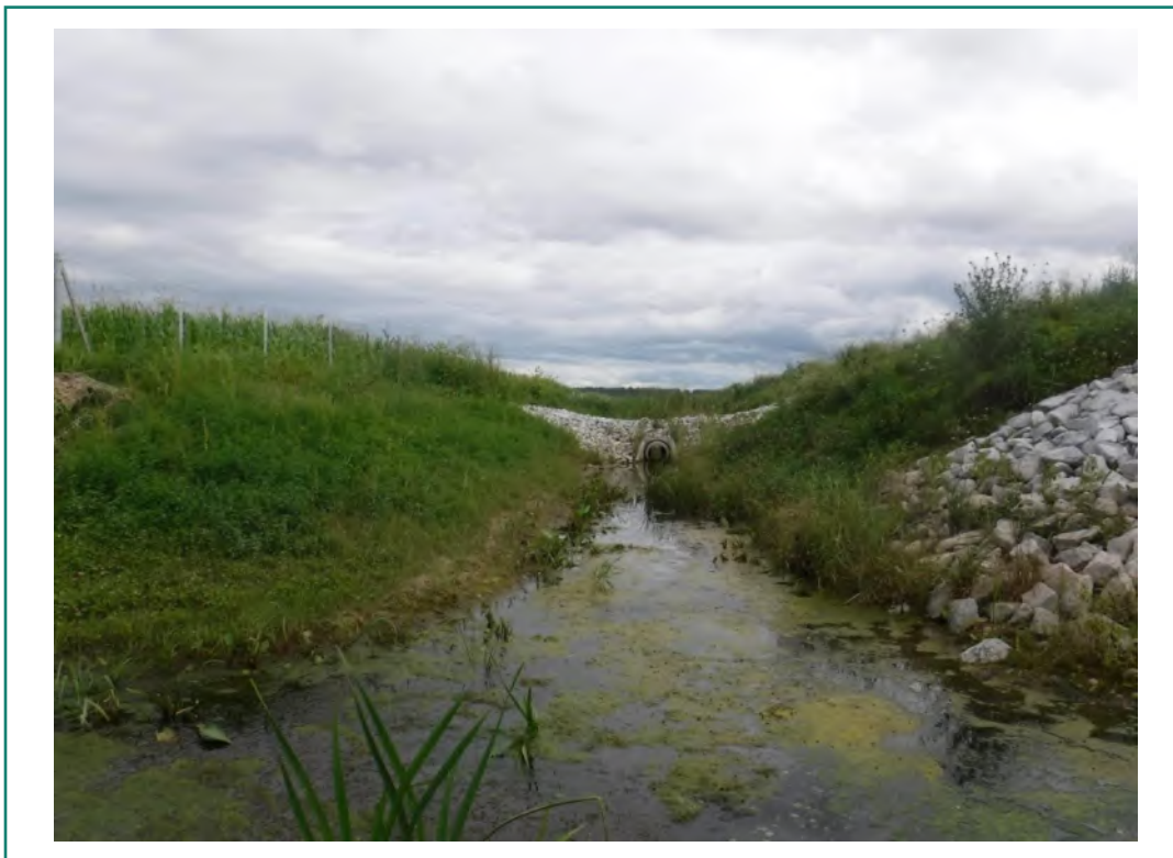
Photo 57 : Aperçu du fossé de route connecté au cours d'eau Edwin en amont du ponceau P07
