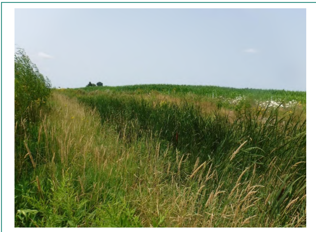
Photo 51 : Aperçu du segment réaménagé du ruisseau Bellefroid-Dandurand au point de relevé situé à 400 m du ponceau P05 - vue vers l'aval (photo 3222)
