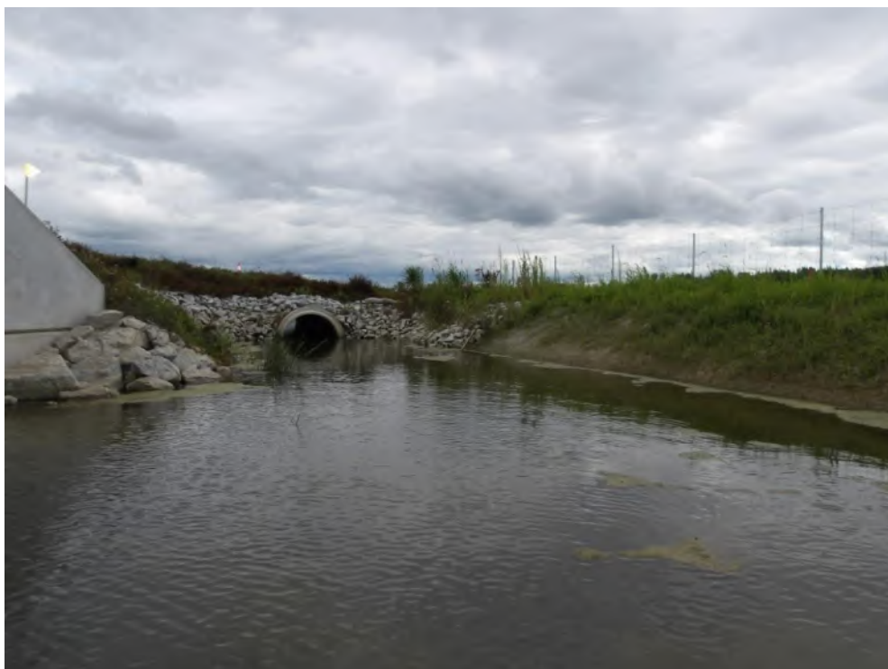
Photo 64 : Aperçu du fossé de route connecté au ruisseau Louis-Rochelleau en aval du ponceau P08
