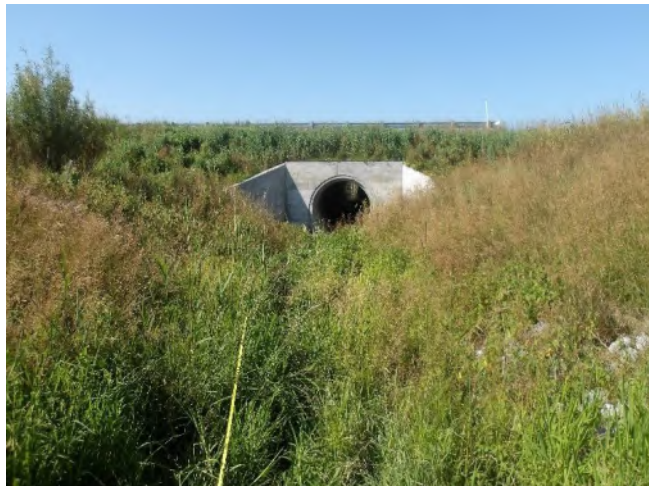
Enrochement encastré et lit végétalisé du ruisseau Bellefroid-Dandurand en amont du ponceau P05 (2024)
