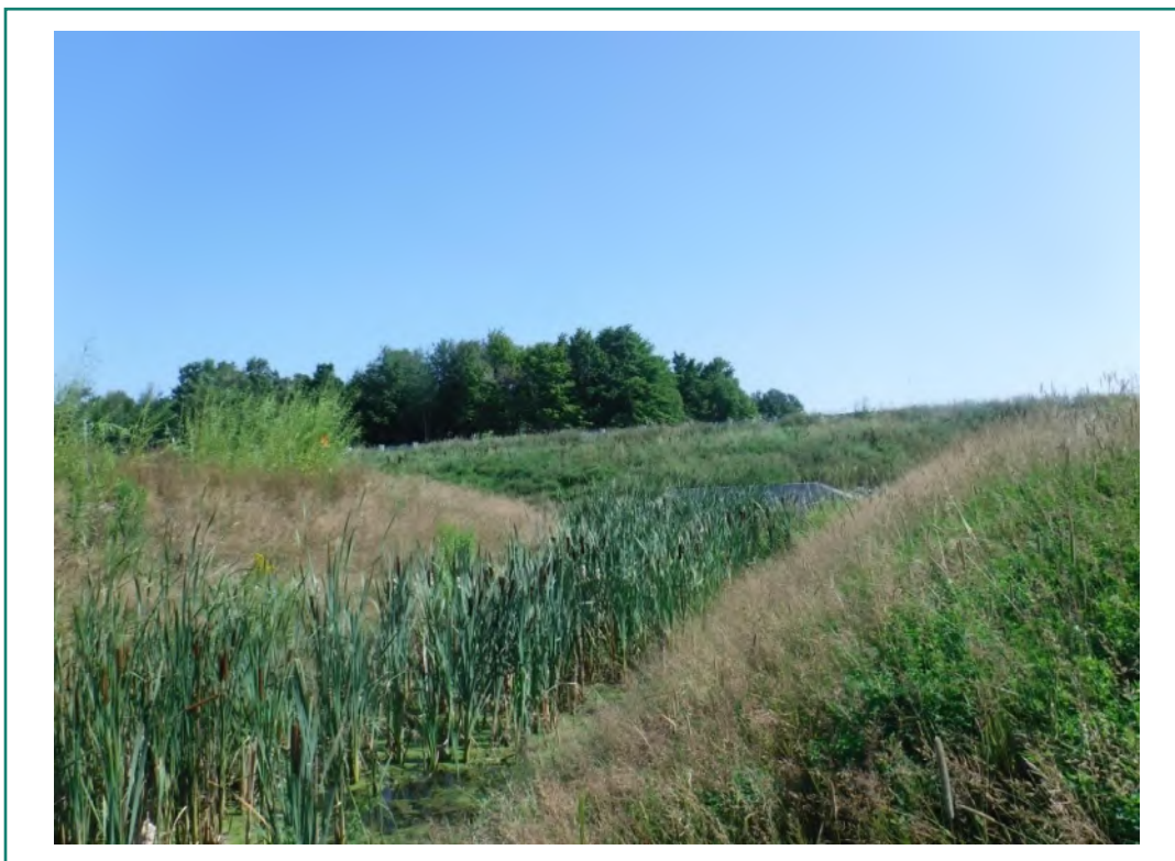
Photo 21 : Aperçu des berges et des rives végétalisées en aval du ponceau P05 - Ruisseau Bellefroid-Dandurand
