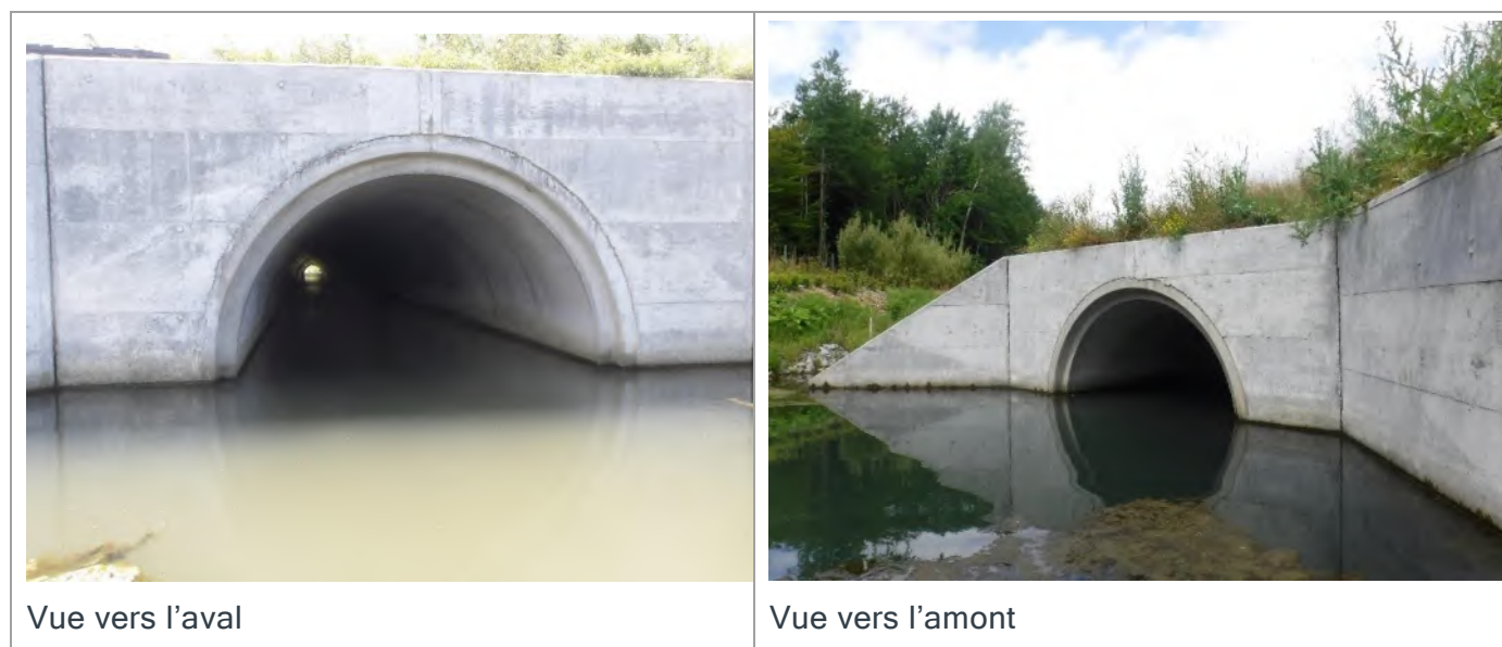
Figure 3 : Ponceau P03 du ruisseau Tipping
