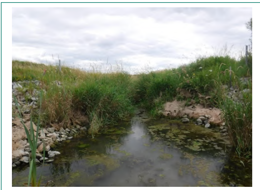
Photo 22 : Aperçu de l'enrochement et de la végétalisation présente en berge du ruisseau Bellefroid-Archambault (vue vers l'aval)
