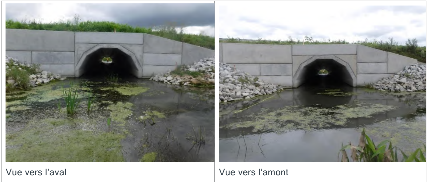
Figure 8 : Ponceau P07 du cours d'eau Edwin
