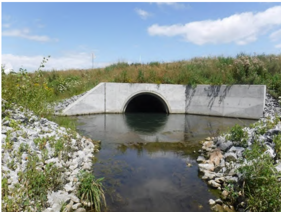
Photo 11 : Aperçu du ruisseau Tipping en aval du ponceau P03 (vue vers l'amont)
