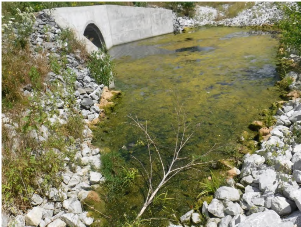
Photo 15 : Aperçu de l'enrochement en berge du ruisseau Desranleau au transect de 1 m en aval du ponceau P04
