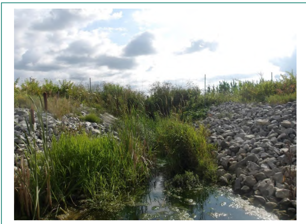
Photo 4 : Aperçu de la stabilité des berges du ruisseau Phoenix-Campbell (vue vers l'amont)
