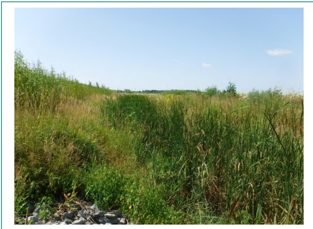
Photo 33 : Aperçu d'enrochement présent à 175 m sur le segment réaménagé du ruisseau Bellefroid-Dandurand
