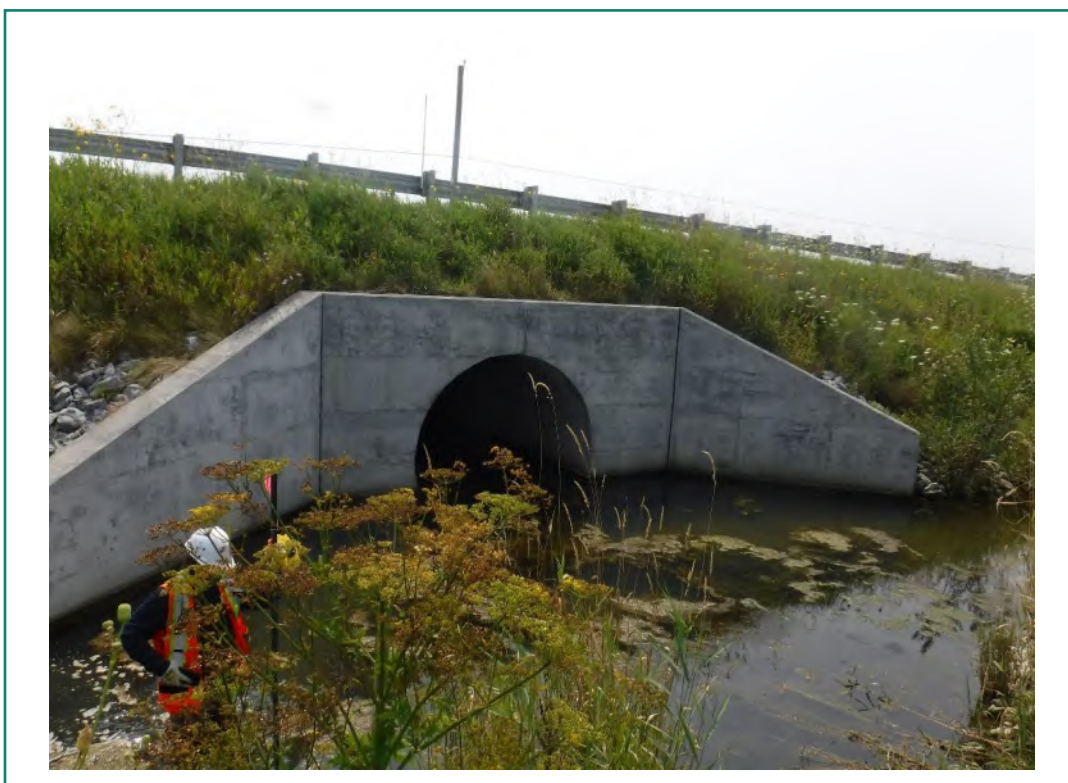
Photo 56 : Aperçu du segment réaménagé du ruisseau Bellefroid-Dandurand au dernier point de relevé situé à l'entrée du ponceau sous la route 122 - vue vers l'aval (photo 3243)
