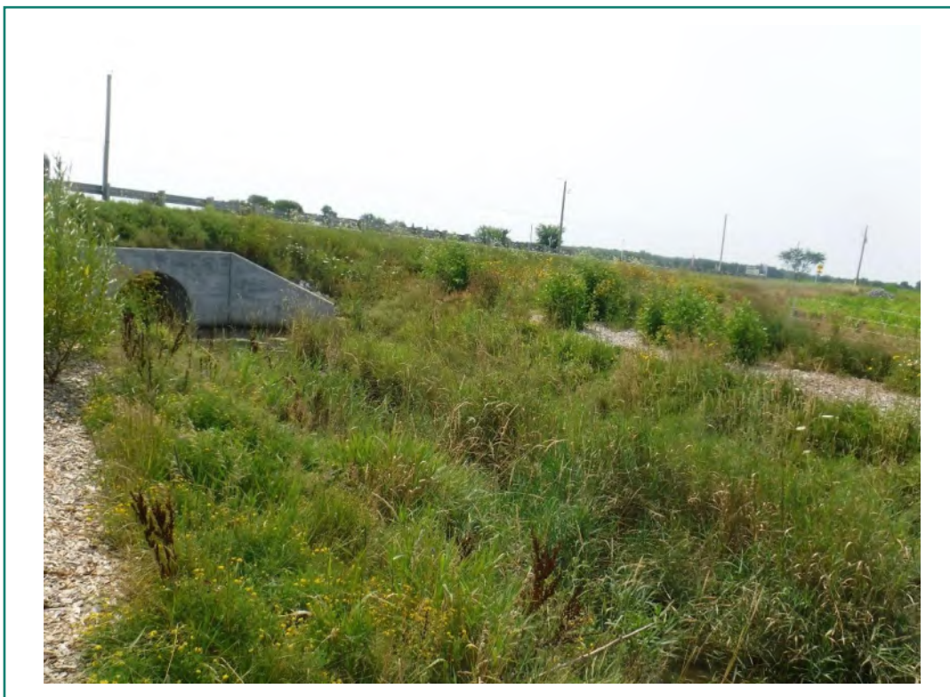
Photo 55 : Aperçu du segment réaménagé du ruisseau Bellefroid-Dandurand au point de relevé situé à 500 m du ponceau P05 - vue vers l'aval (photo 3239)
