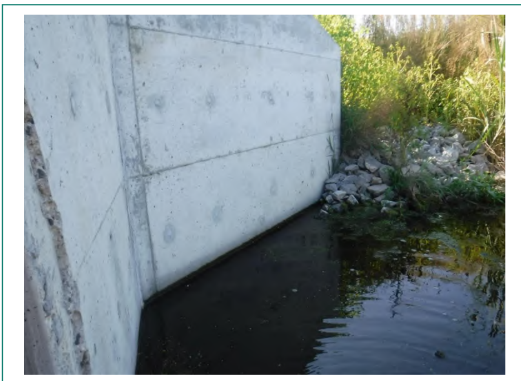
Photo 20 : Aperçu du mur de soutènement et de l'enrochement pour la stabilisation du ponceau P05 - Ruisseau Bellefroid-Dandurand
