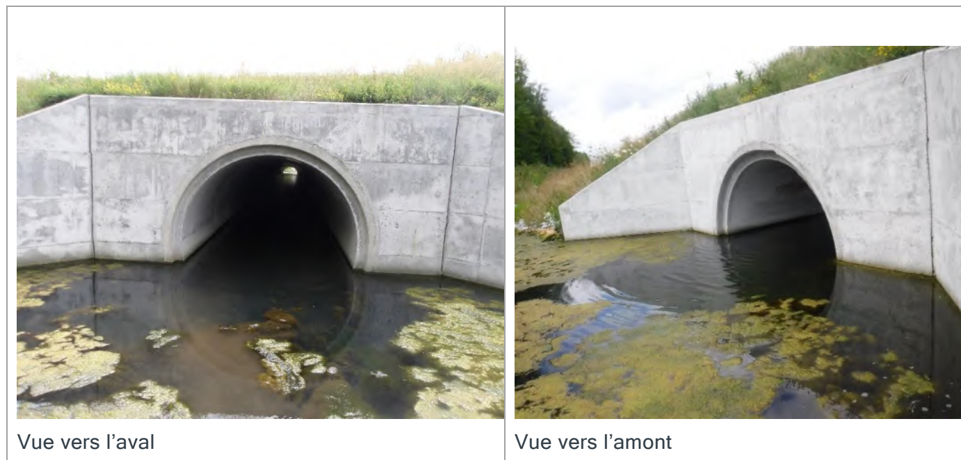
Figure 4 : Ponceau P04 du ruisseau Desranleau
