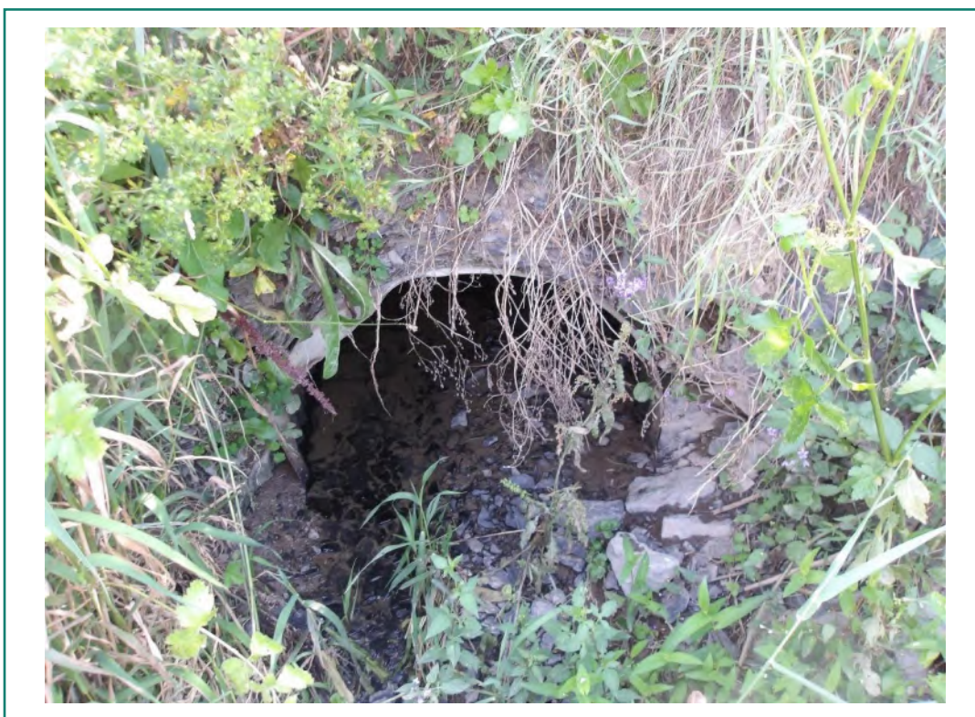
Photo 6 : Aperçu d'un ponceau privé à environ 15 m en amont du ponceau P01 dans le ruisseau Phoenix-Campbell
