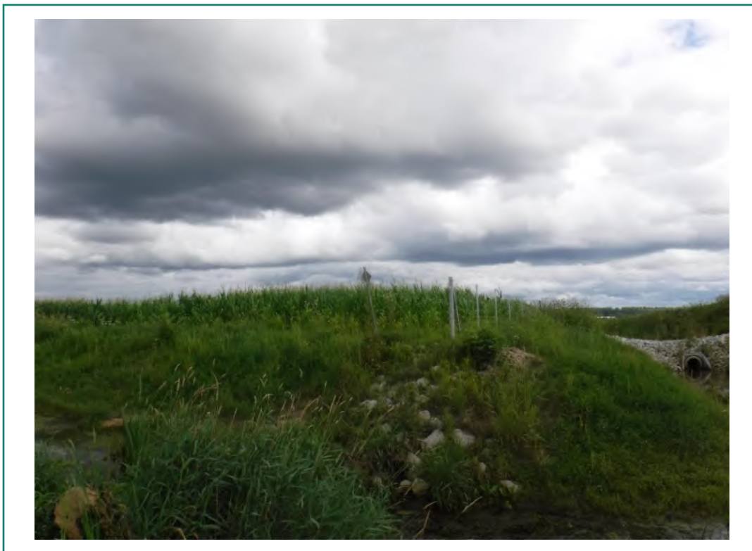
Photo 59 : Aperçu du talus stabilisé par l'enrochement et la végétation en berge du cours d'eau Edwin
