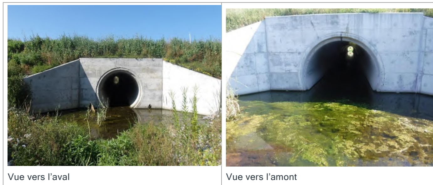
Figure 5 : Ponceau P05 du ruisseau Bellefroid-Dandurand sous l'A35
