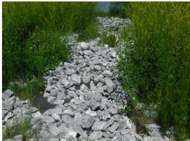
Figure 7.11 : Enrochement non encastré, avec présence de drain
