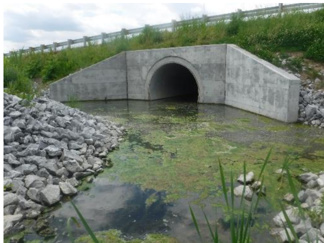
Figure 8.6 : Prise de vue de l'aval du ruisseau Dandurand- Bellefroid vers le ponceau, avec mauvais alignement du ponceau
