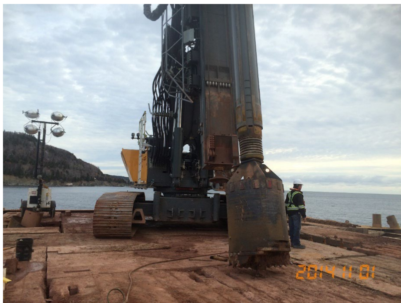
Figure 4.6.8 : Plateforme temporaire pour forage de pieux
