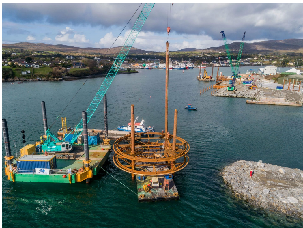
Figure 4.6.6 : Grue sur barge pour la construction d'un duc-d'Albe en cellule de palplanches
