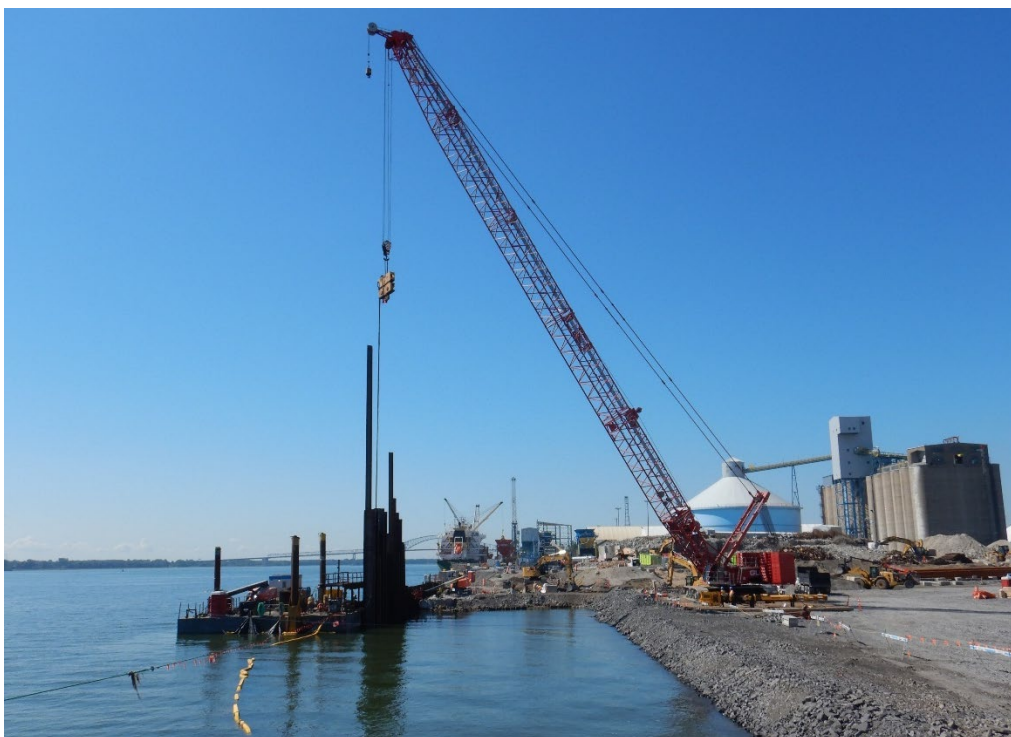
Figure 4.4.8 : Exemple de mise en place par vibrofonçage d'un mur combiné en pieux et palplanches d'acier au chantier du port de Trois-Rivières
