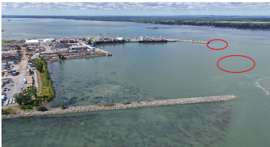
Photo 5.3.3 : Vue aérienne de la zone d'approche aux navires de la zone portuaire et du prolongement des postes à quai B1 et B2
