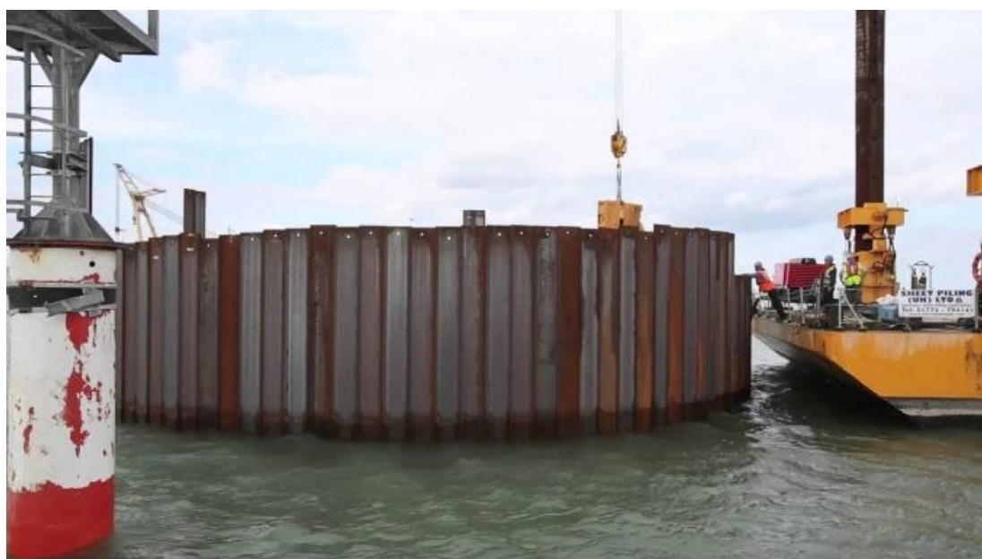
Figure 4.6.7 : Grue sur barge pour la construction d'un duc-d'Albe en cellule de palplanches
