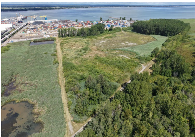
Photo 3.3 : Vue aérienne de la cellule A (MH5 et MH6) et des MH1, MH2 et MH3, en périphérie de l'aire d'entreposage existante
