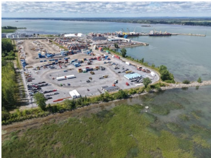
Photo 3.1 : Vue aérienne de l'aire d'entreposage existante et des quais actuels
