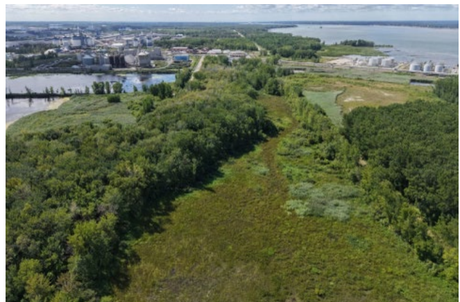
Photo 3.4 : Vue aérienne d'une partie de MH3, MH8 et MH10 (vers la cellule C)
