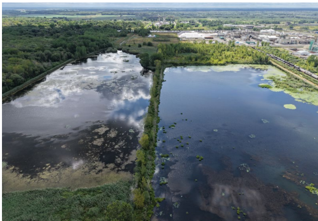
Photo 3.5 : Vue aérienne de la cellule C (bassins MH11 et MH12) et en périphérie (MH8, MH9 et MH15)
