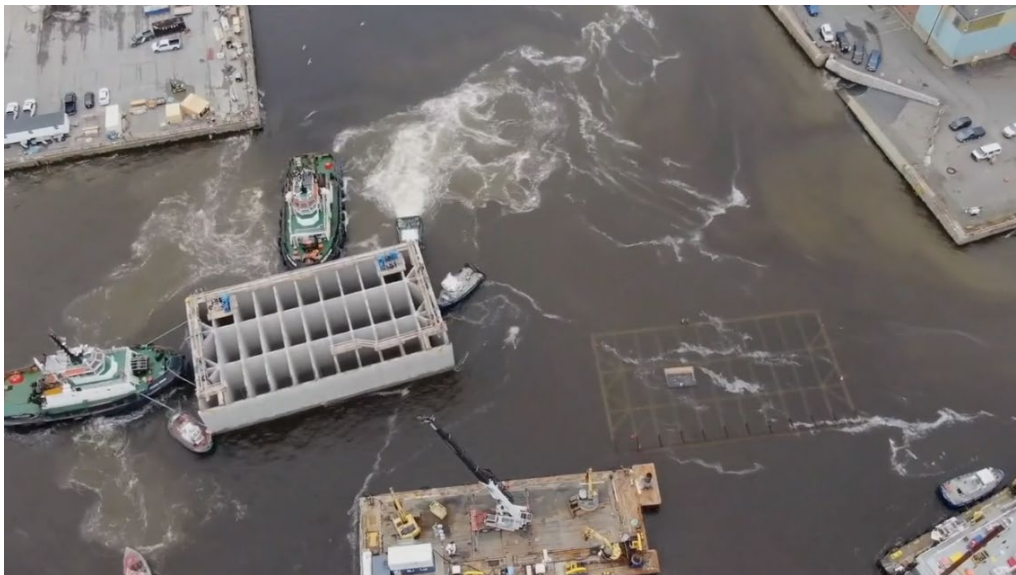
Figure 4.4.2 : Caissons de béton en installation, port Saint-John, modernisation du terminal ouest
