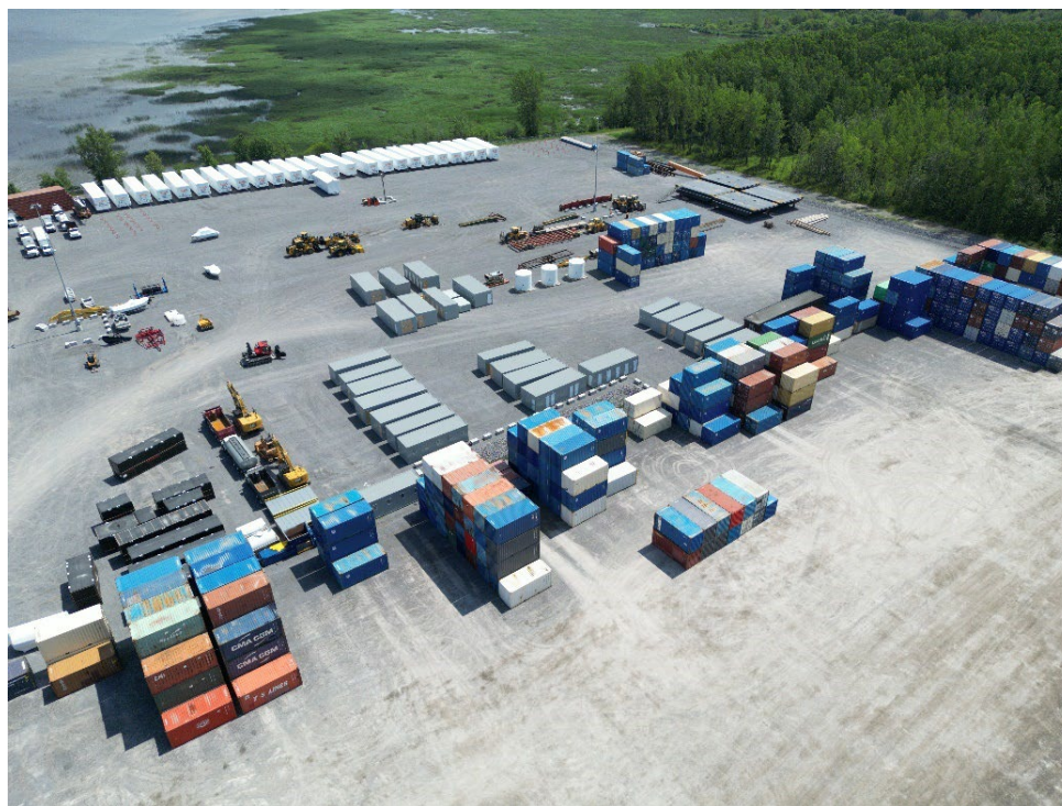
Figure 4.3.6 : Vue générale vers l'est des aires d'entreposage B5-S3 à B5-S8 (2024)
