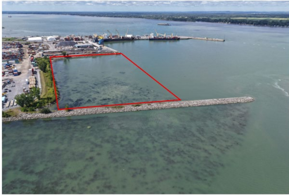
Photo 5.3.4 : Vue aérienne du secteur de l'herbier aquatique de la zone portuaire
