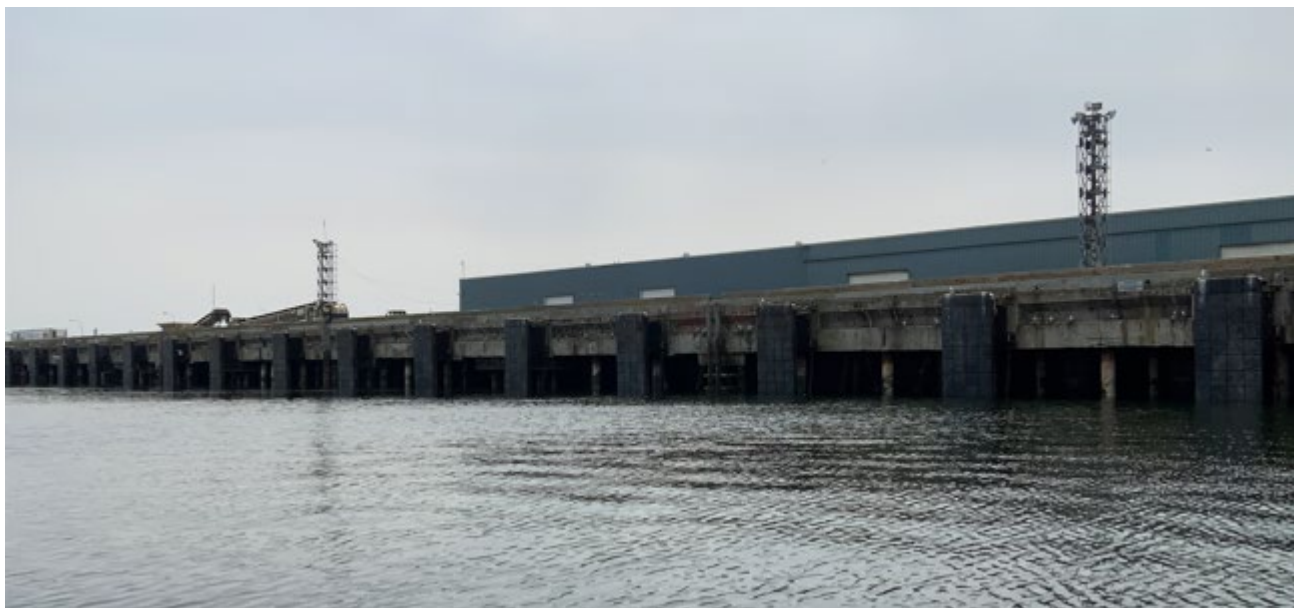
Figure 4.4.4 : Quai sur pieux - Quai commercial de Matane
