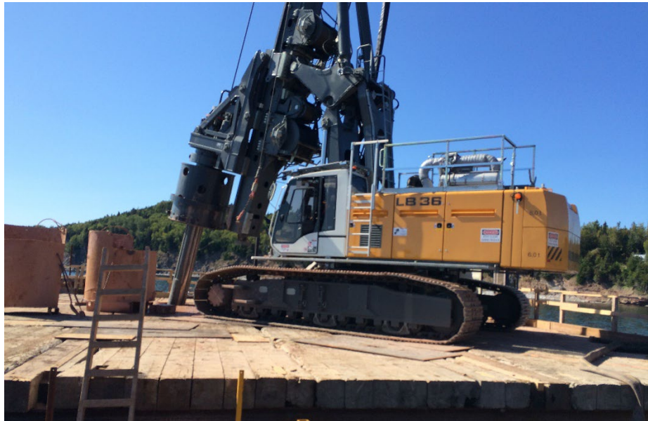
Figure 4.4.7 : Exemple de forage d'emboîture avec une foreuse Liebherr LB36
