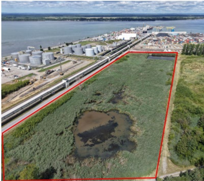
Photo 5.3.2 : Vue aérienne de la cellule A
