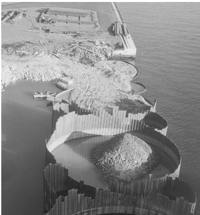
Figure 4.4.3 : Cellules de palplanches surmontées d'un mur de couronnement
