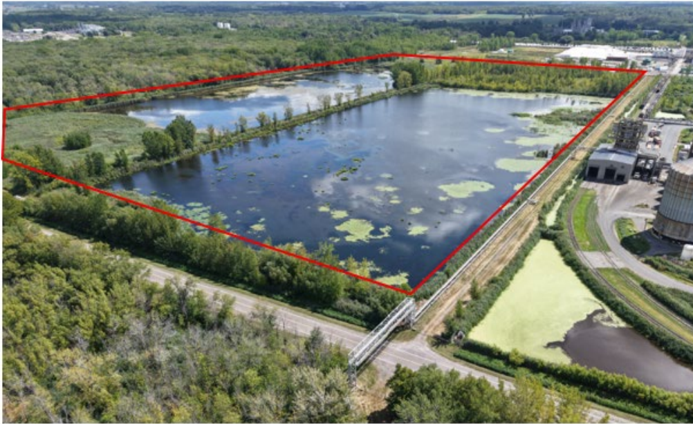
Photo 5.3.3 : Vue aérienne de la cellule C
