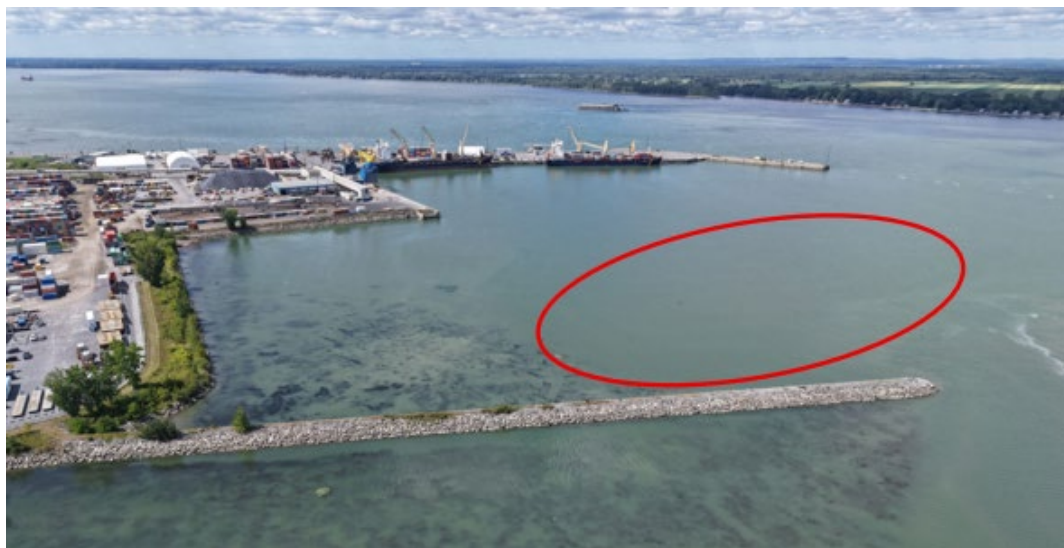
Photo 5.3.6 : Vue aérienne de la zone d'approche aux navires de la zone portuaire
