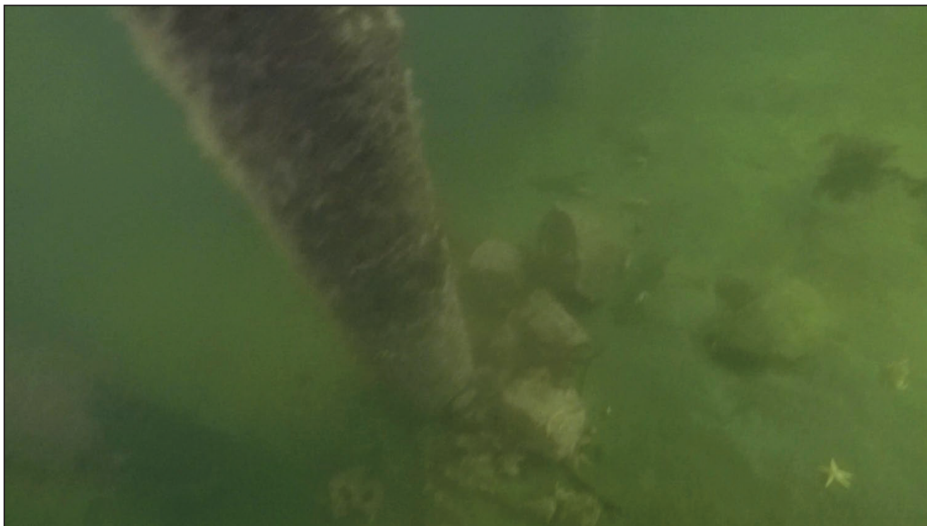
Photo 13. C1-S1 fin. Blocs au pied des piliers
