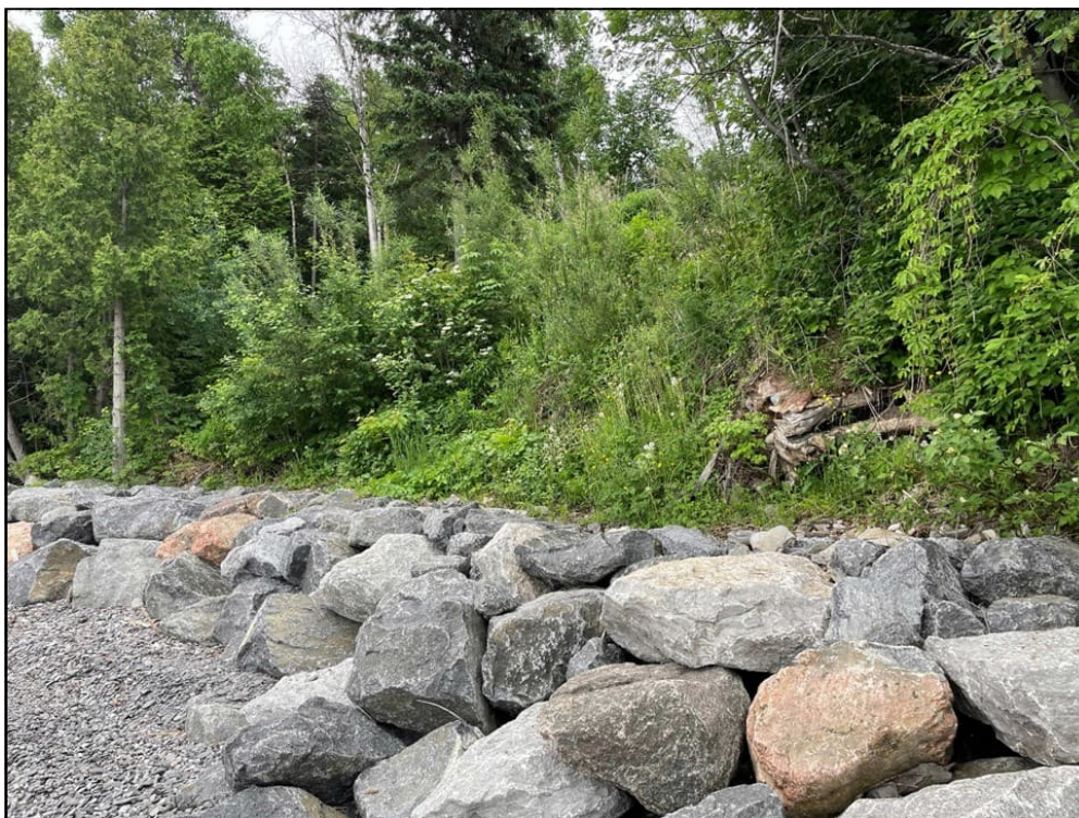
Technique mixte, enrochement avec technique végétale (vue 3 ans après travaux)
