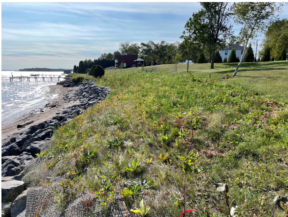
Technique mixte, enrochement avec technique végétale
