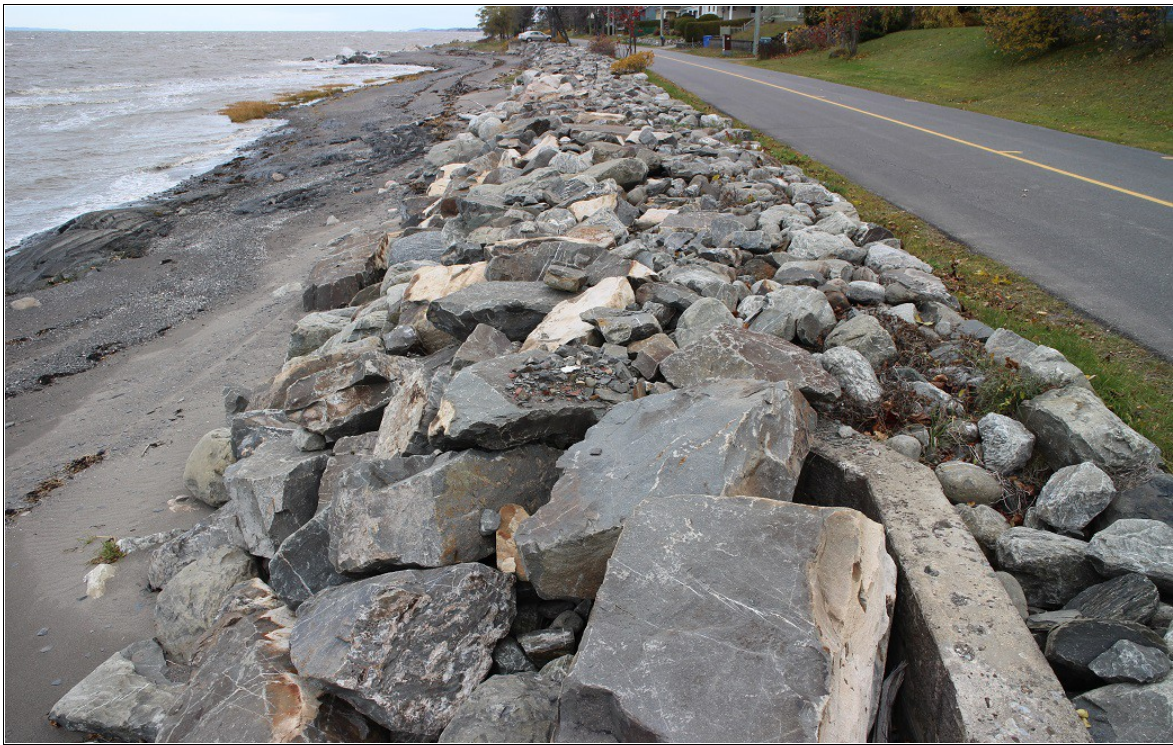
Figure 2.22 Crête de l'enrochement de protection (novembre 2014)
