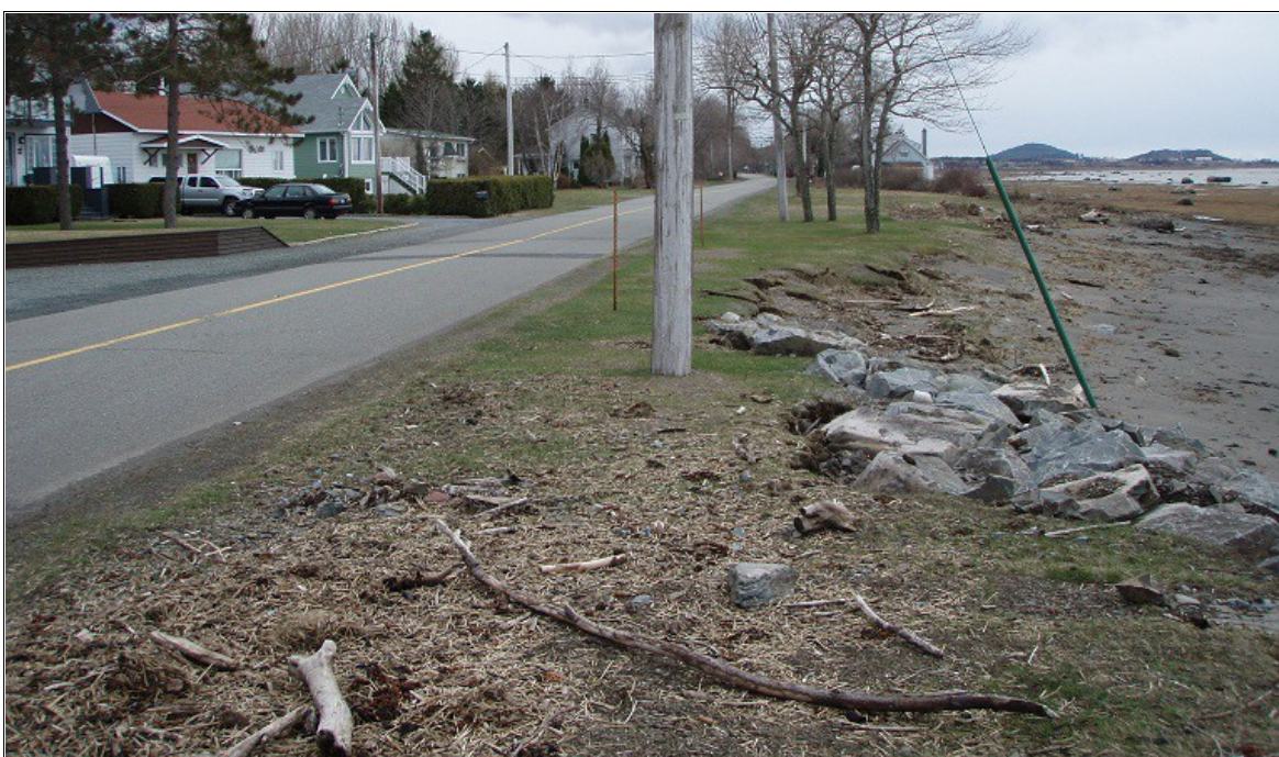
Figure 2.44 Enrochement placé au droit du poteau (MSP – 6 mai 2011)
