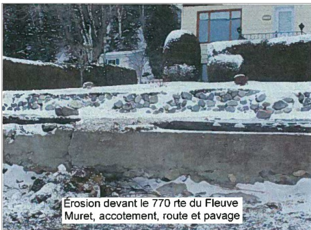
Figure 2.17 Muret de « protection » de berge au 770, route du Fleuve (Photo Municipalité)
