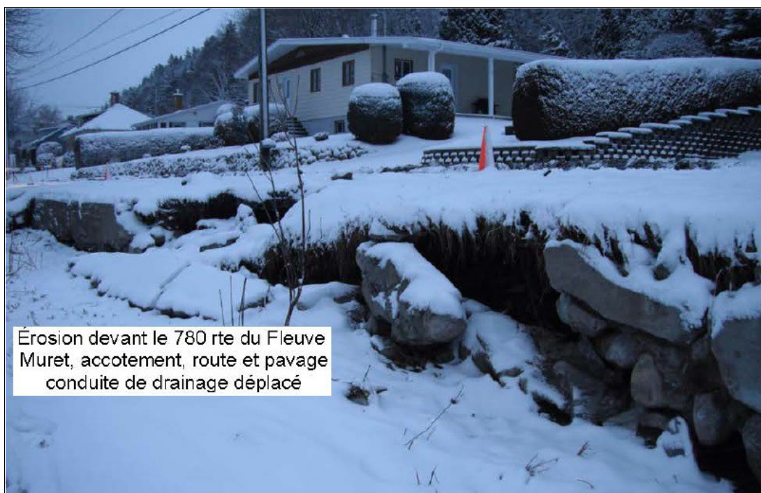
Figure 2.19 Muret de « protection » de berge au 780, route du Fleuve (Photo Municipalité)
