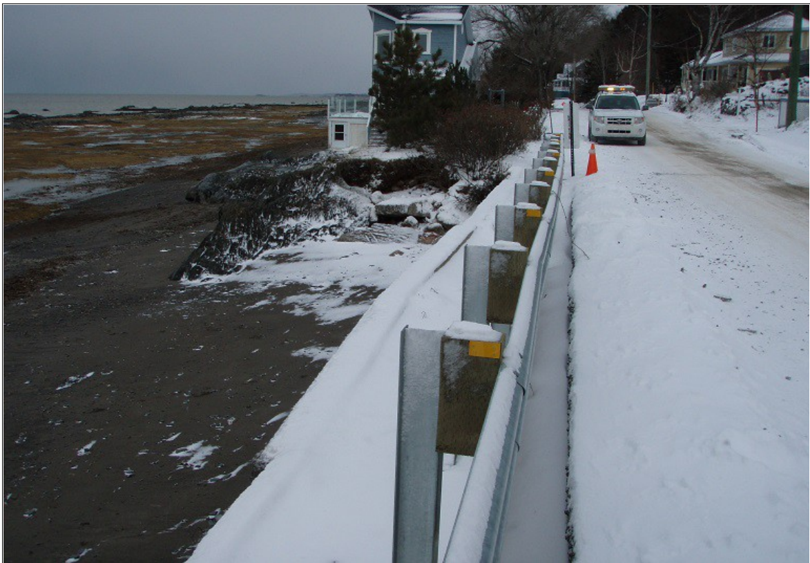
Figure 2.27 Déplacement latéral du muret de béton (MSP – 8 décembre 2010)
