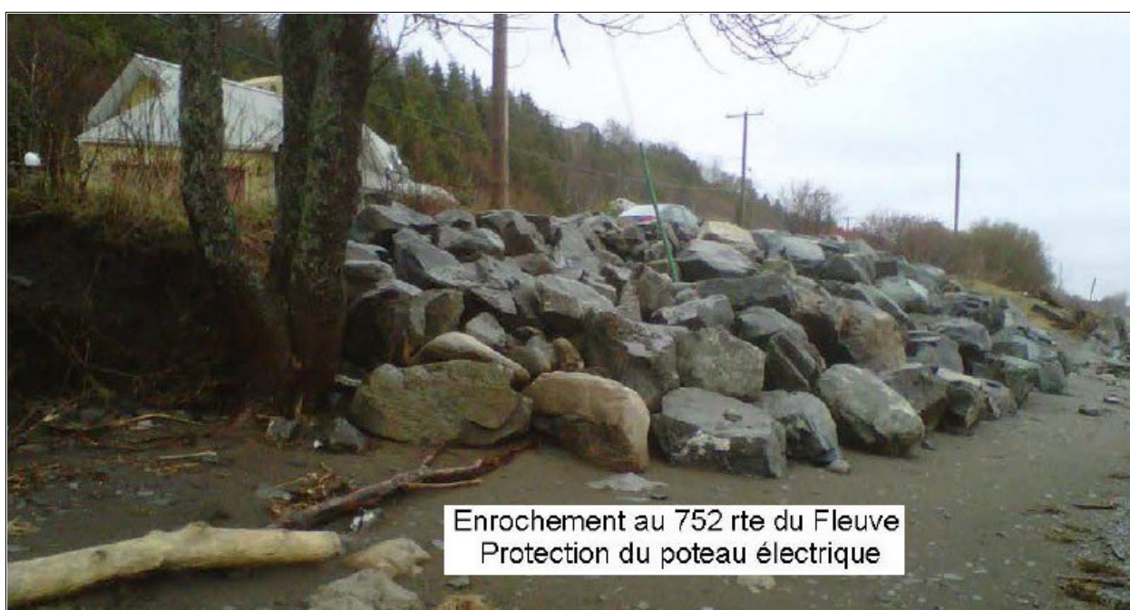
Figure 2.7 Enrochement de protection du poteau électrique (Municipalité)
