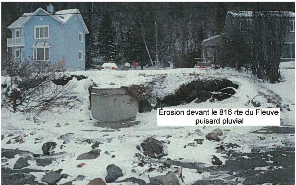
Figure 2.33 Érosion près d'un puisard pluvial devant le 816 (Municipalité)
