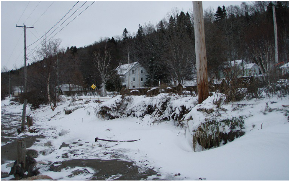
Figure 2.38 Érosion de la berge près du poteau électrique (MSP – 8 décembre 2010)
