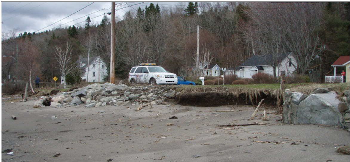
Figure 2.39 Protection du poteau et érosion de berge à proximité (MSP – 6 mai 2011)
