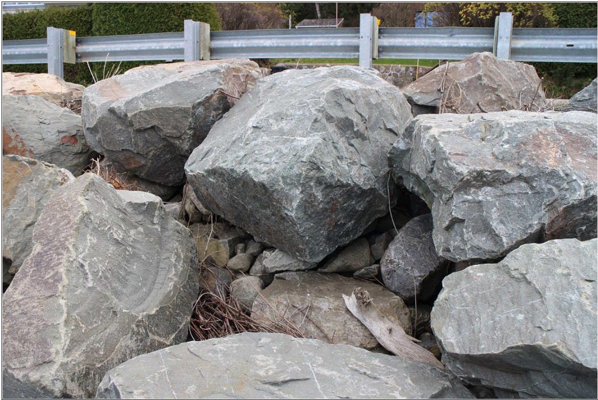
Figure 2.30 Instabilité de la protection en enrochement (2 novembre 2014)
