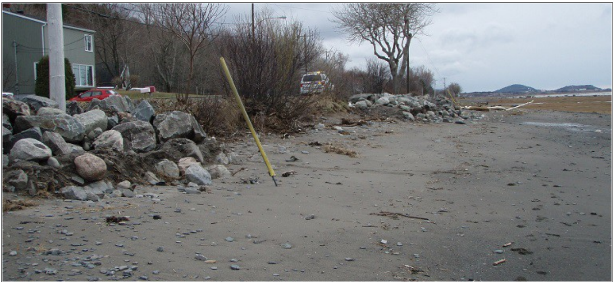
Figure 2.34 Protections en enrochement devant le 814 et devant le 816 (MSP – 6 mai 2011)
