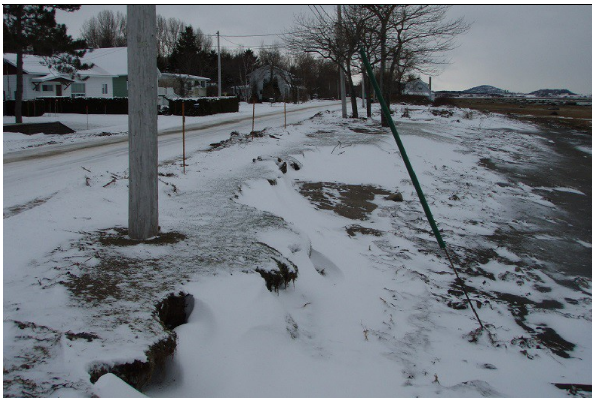
Figure 2.43 Érosion de la berge et hauban de poteau sur la plage au 868 (MSP – 8 décembre 2010)
