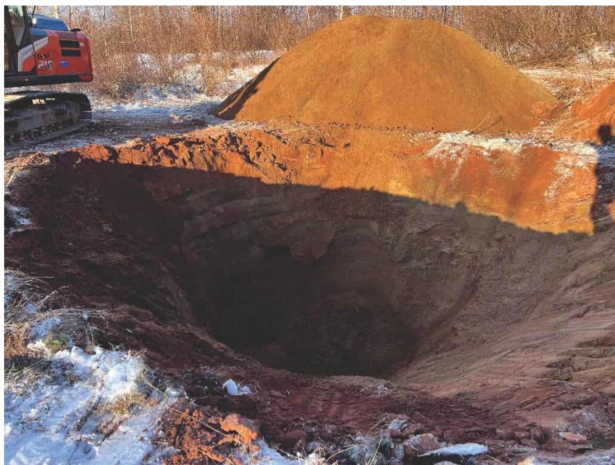
PHOTO 16 Tranchée 25TR-10 (15 janvier 2025)
