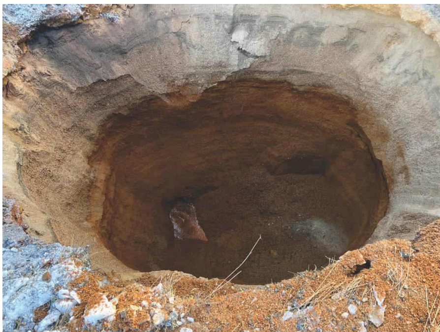
PHOTO 19 Tranchée 25TR-13 (15 janvier 2025)
