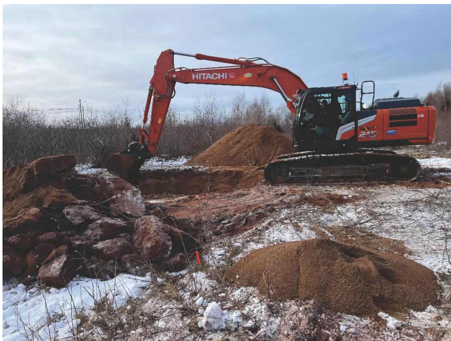
PHOTO 12 Tranchée 25TR-06 (14 janvier 2025)
