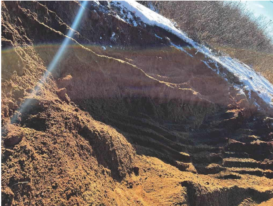
PHOTO 17 Tranchée 25TR-11 (15 janvier 2025)
