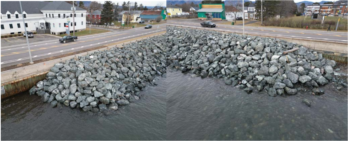
Figure 17 - Enrochement construit au printemps 2023 entre les chaînages 8+225 et 8+425 (source : MTMD, 20 décembre 2023)
