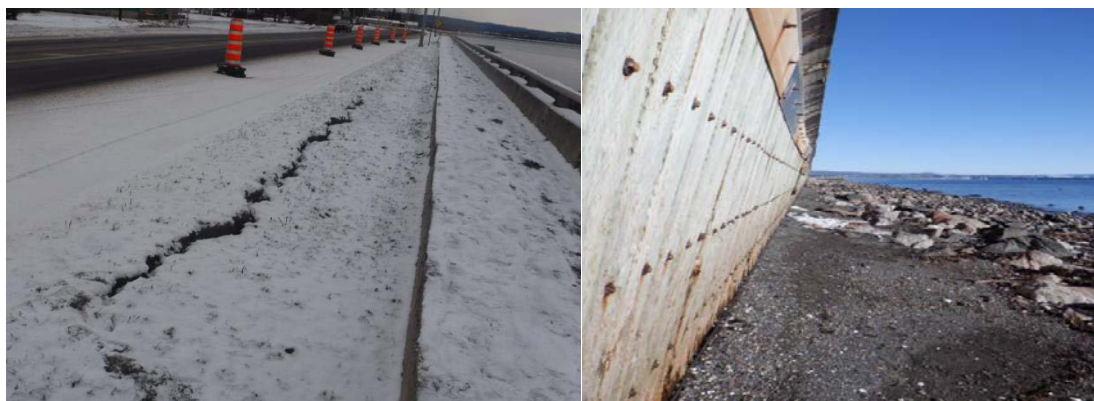
Figure 16 - Dommages observés suite à la tempête de décembre 2022 (source : MTMD)
