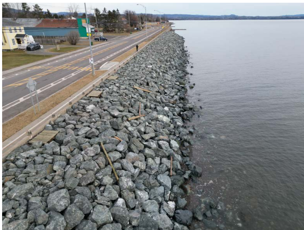
Figure 6 - Débris flottants sur la partie supérieure de l'enrochement (source : MTMD, 2023-12-20)
