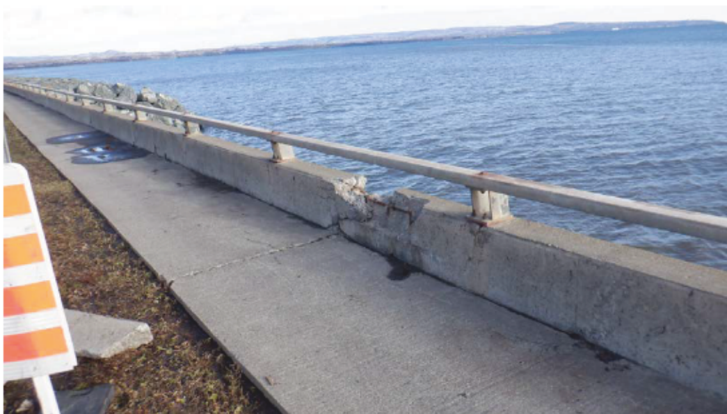
Figure 14 - Bris du béton constituant le déflecteur, dans le secteur du chaînage 8+250, 27 novembre 2023 (source : MTMD)
