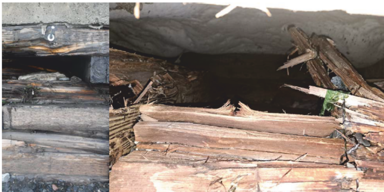
Figure 10 - Soutirage de matériaux du mur, créant des zones complètement vides (source : MTMD)
