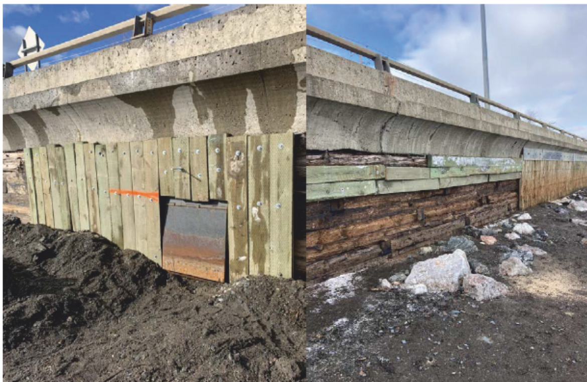
Figure 18 - Exemple d'interventions palliatives effectuées en urgence : Installation de madriers de bois pour renforcer et sceller le caisson de bois (source : MTMD, janvier 2024)
