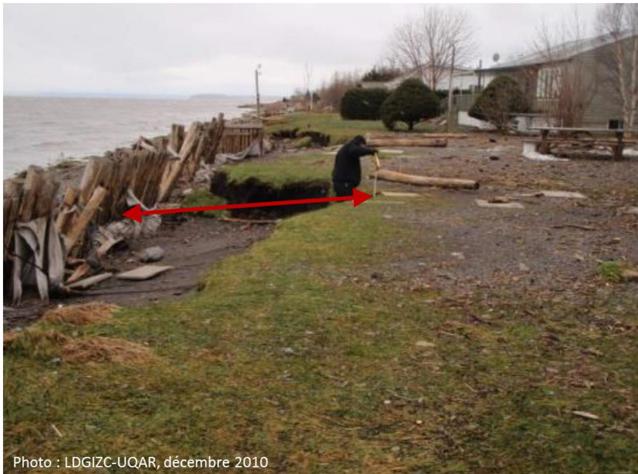
Figure 12. Recul de la côte derrière un ouvrage de protection, secteur de la pointe Verte
