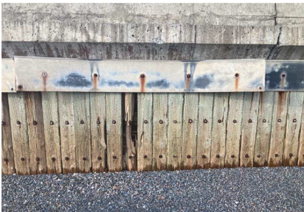
Figure 13 - Altération de la plaque d'acier et usure du madrier de bois laissant sortir le matériau de remplissage du caisson et favorisant l'affaissement derrière le mur (source : MTMD, 4 décembre 2023).
