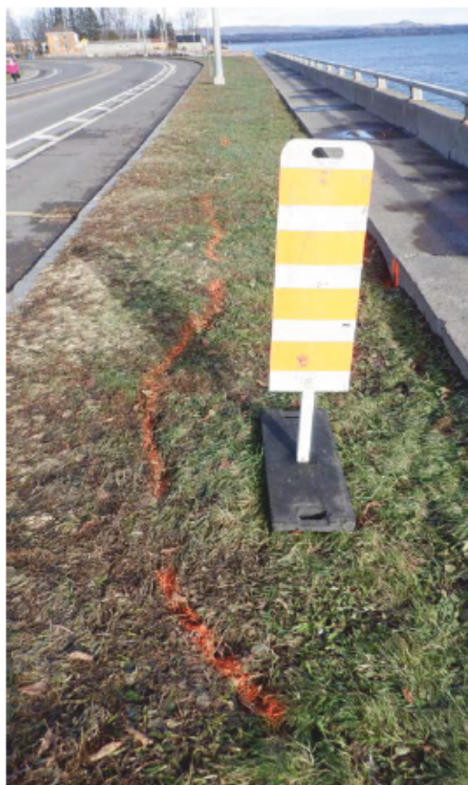
Figure 11 - Fissure observée en surface, dans le secteur du chaînage 8+200, 27 novembre 2023 (source : MTMD)
