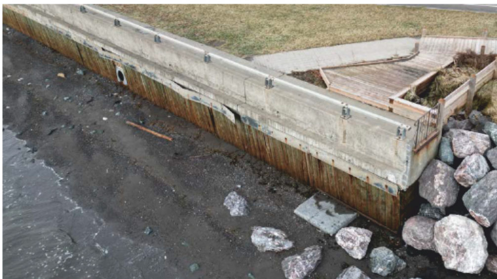
Figure 12 - État général du mur à l'extrémité est. On y remarque notamment l'altération de la plaque d'acier (source : MTMD)
