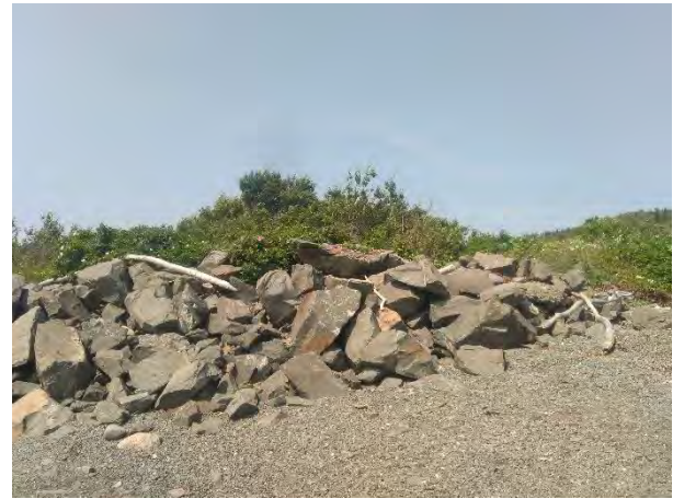
Photo 16. Sommet de l'enrochement qui constitue la limite du littoral, unité U15
