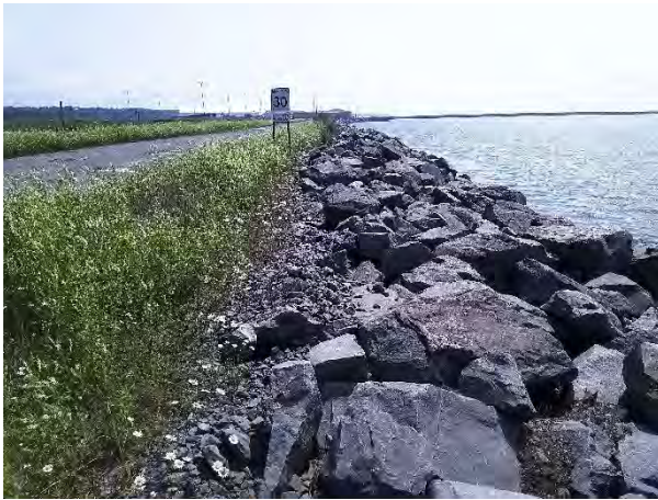
Photo 15. Sommet de l'enrochement qui constitue la limite du littoral, unité U15
