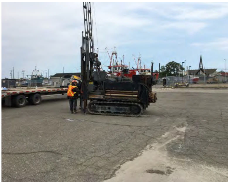
Photo 3 – Vue du forage F-7.
