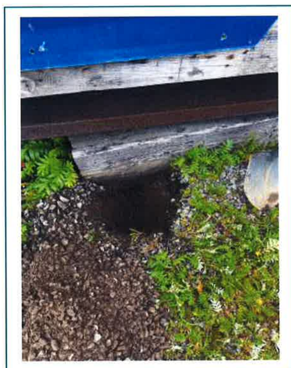
Photo 2 : Aperçu du sondage manuel SM-01-23 (31 juillet 2023).
