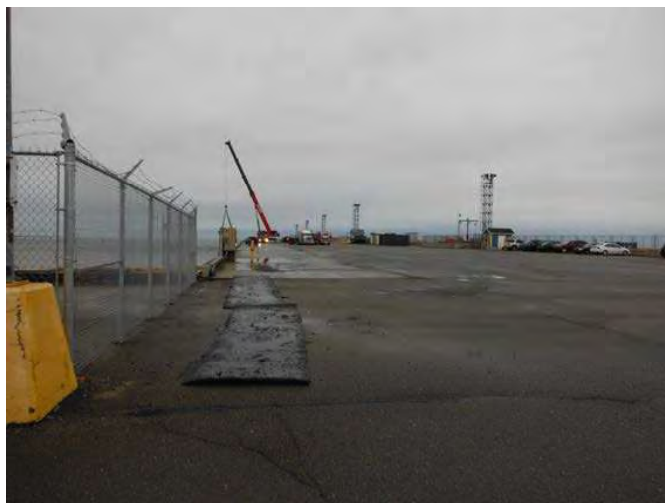
PHOTO 2 Installations portuaires de Rimouski – Jetée Est
