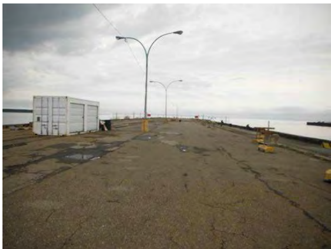
PHOTO 1 Installations portuaires de Rimouski – Jetée Ouest
