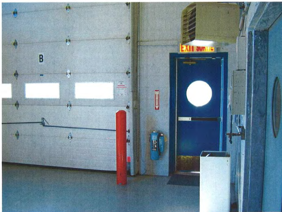
Photo n° 1. Bâtiment de service pour l'entretien des navires et équipements de la réserve navale NCSM d'Iberville
