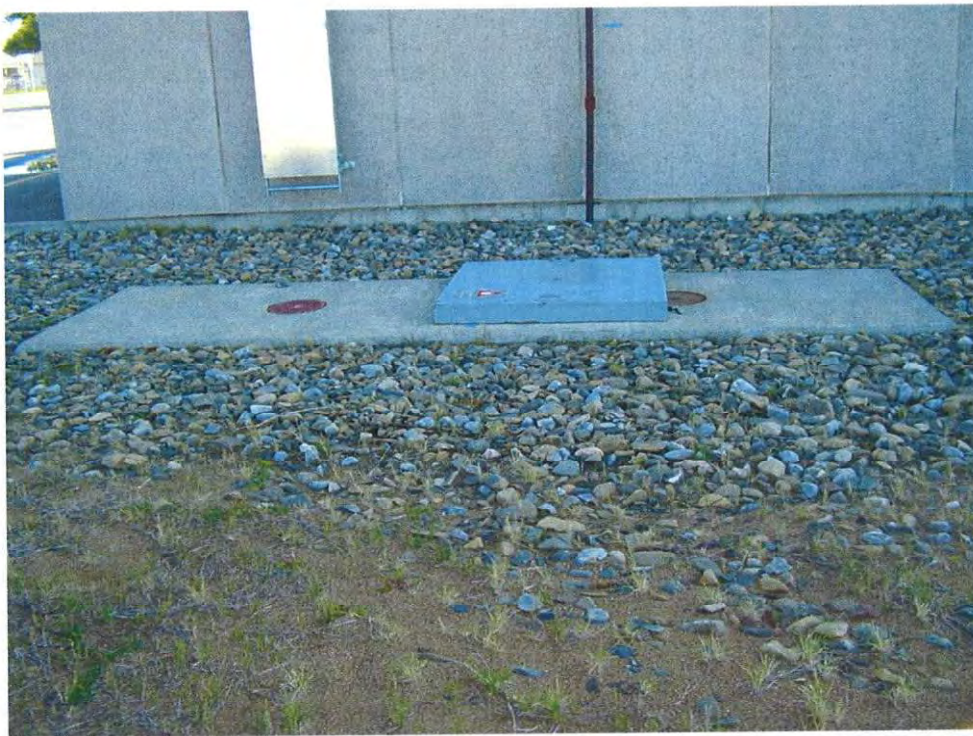
Photo n° 25. Réservoir d'huile usée réserve navale
