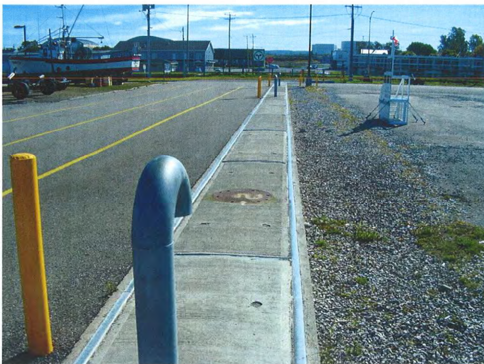
Photo n° 16. Caniveau en béton pour les deux pipelines Pétro Canada
