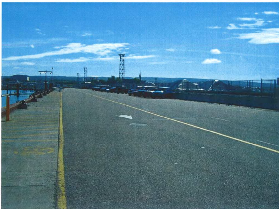
Photo n° 12. Entrepasage de sel côté ouest de la jetée est. Vue du nord vers le sud
