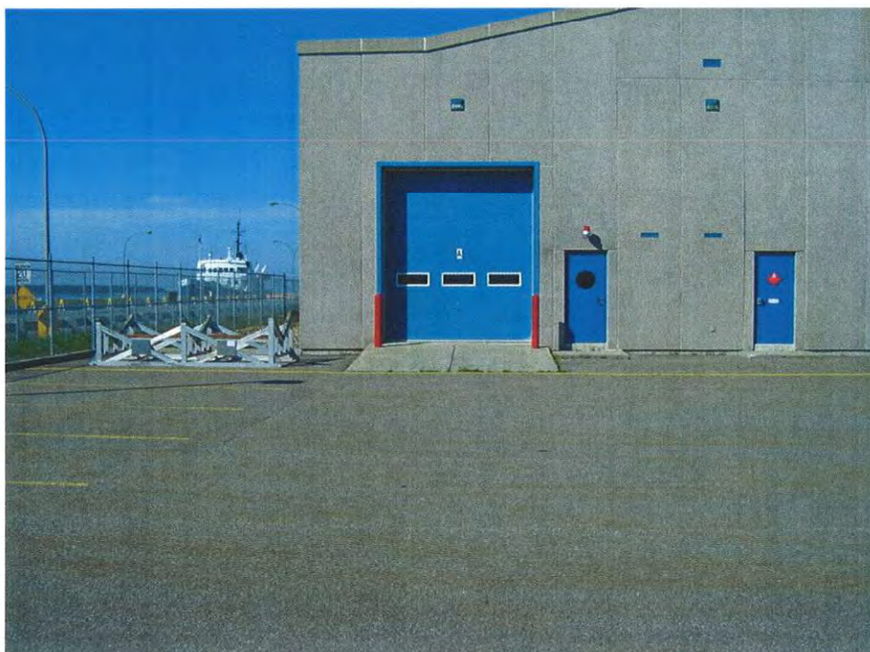
Photo n° 20. Édifice réserve navale, façade sud
