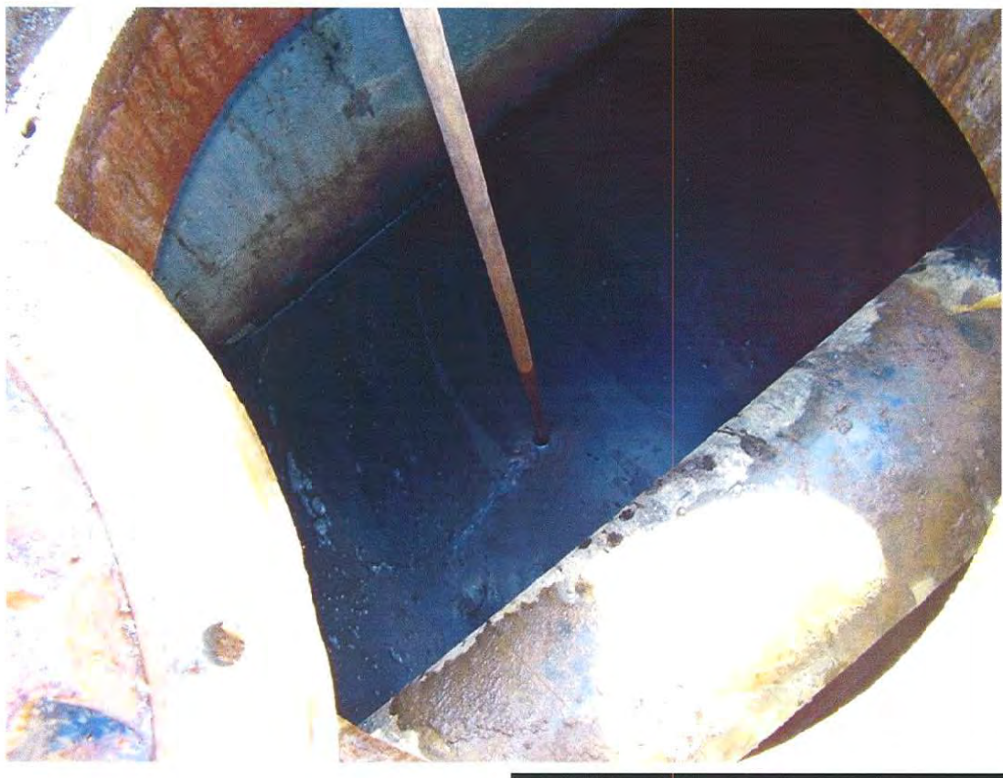
Photo n° 31. ↑ Puits d'accès au caniveau abritant les oléoducs de Pétro Canada
