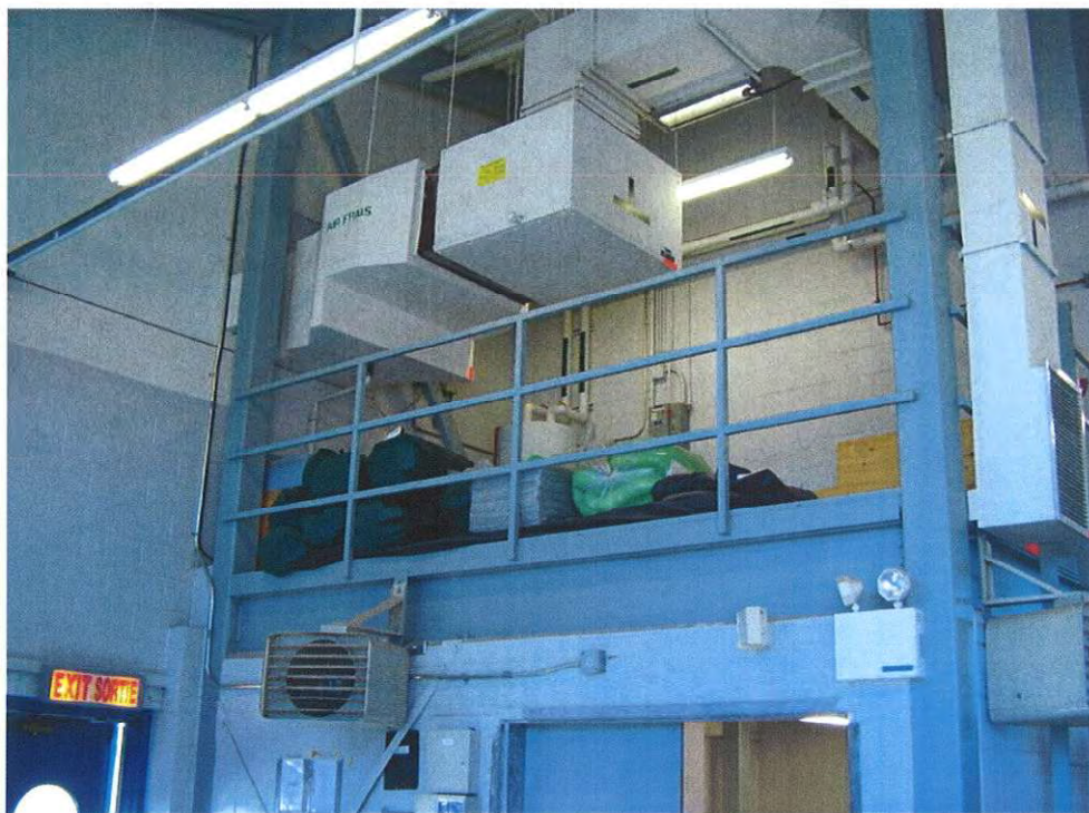
Photo n° 6. Boudins et linge absorbants présents au 2 e étage du bâtiment de la réserve navale
