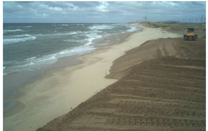
Figure 3-8 : Exemple de recharge sédimentaire en cours d'aménagement au site F0108, dans le secteur des Îles-de-la-Madeleine
