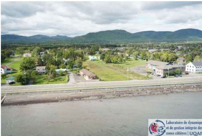
Figure 3-2 : Exemple de mur de protection aménagé au site A1301 à Maria, dans le secteur Gaspésie - Baie-des-Chaleurs
