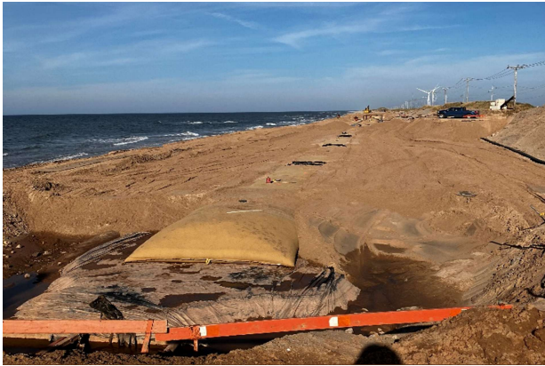
Figure 3-4 : Exemple de conteneurs en géotextile aménagés en combinaison d'une recharge sédimentaire au site F0110, dans le secteur des Îles-de-la-Madeleine
