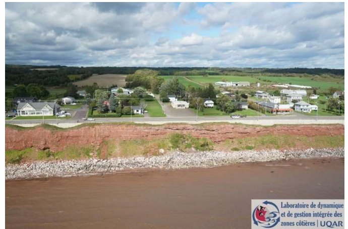
Figure 3-3 : Exemple d'enrochement aménagé au site A1001 à Capelan, dans le secteur Gaspésie - Baie-des-Chaleurs
