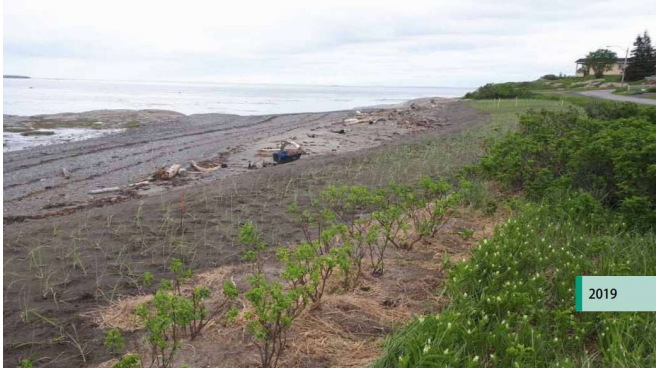
Figure 3-10 : Recharge sédimentaire impliquant le génie végétal à Notre-Dame-des-Neiges
