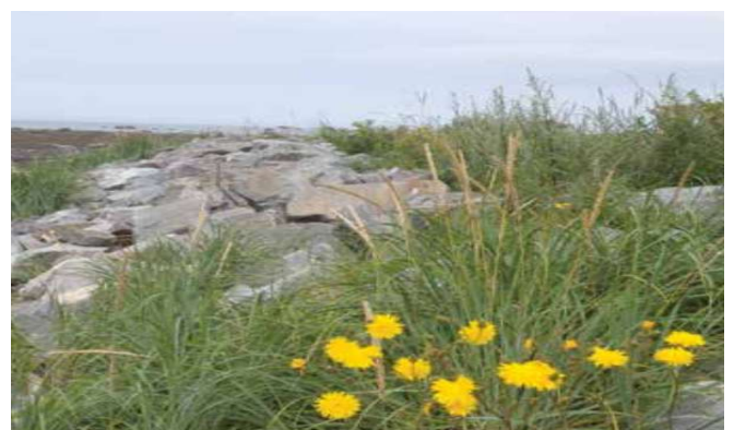
Figure 3-9 : Végétalisation d'enrochement
