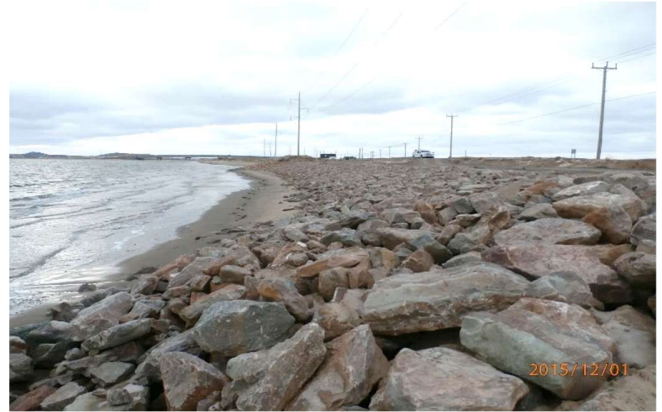
Figure 3-7 : Exemple de rip-rap aménagé au site F0104, dans le secteur des Îles-de-la-Madeleine
