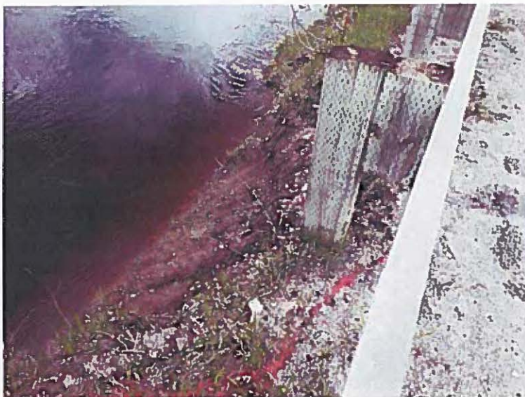
Photo 2: Décrochement superficiel atteignant la glissière de sécurité
