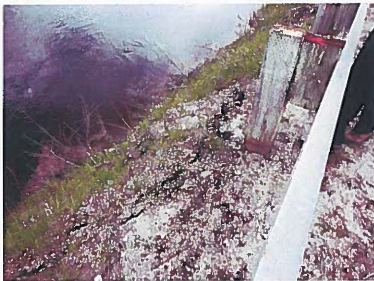
Photo 3: Amorce de décrochement superficiel
