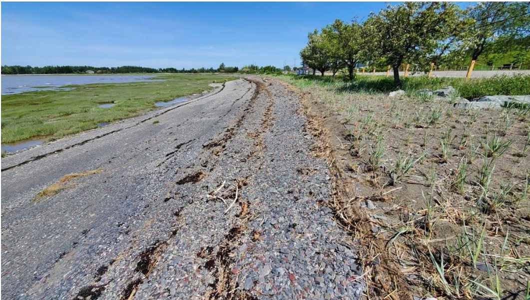
Figure 4 - DEUX ANS APRÈS LA CONSTRUCTION - Recharge de plage à Notre-Dame-du-Portage
