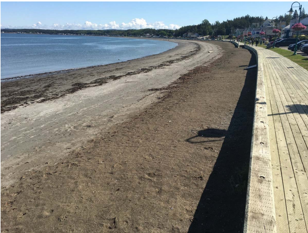
Figure 2 - CINQ ANS APRÈS LA CONSTRUCTION - Recharge de plage à Sainte-Luce en 2019
