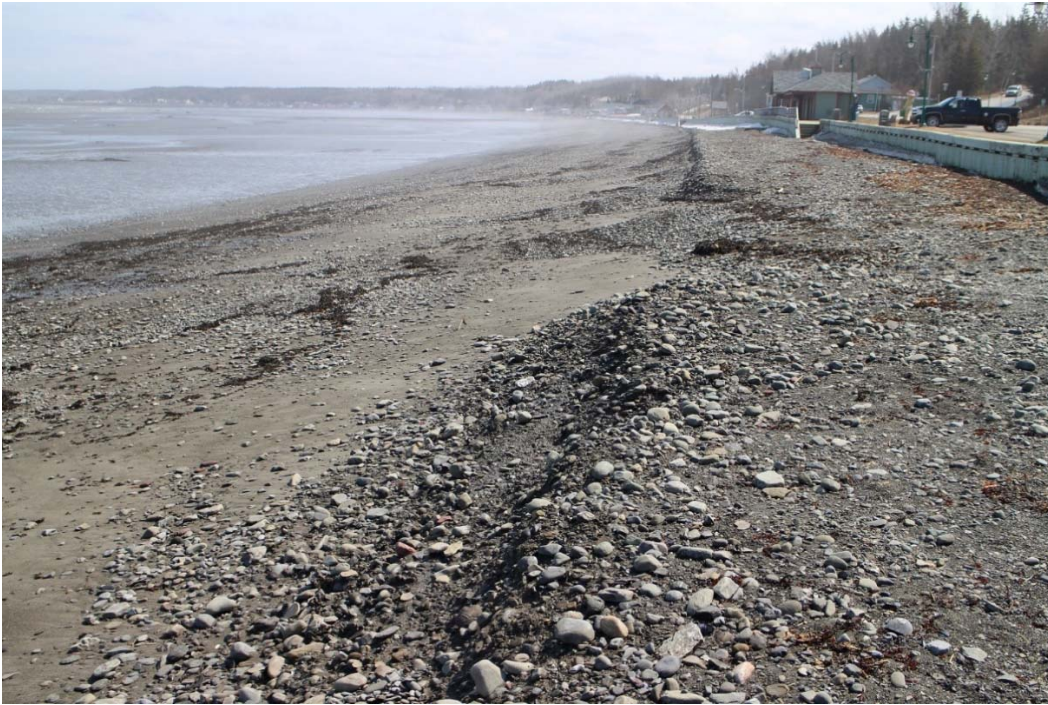
Figure 1 - UN AN APRÈS LA CONSTRUCTION - Recharge de plage à Sainte-Luce en 2015
