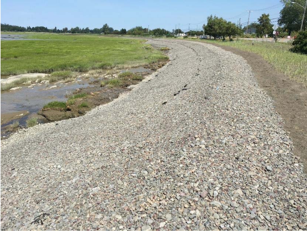
Figure 3 – IMMÉDIATEMENT APRÈS LA CONSTRUCTION - Recharge de plage à Notre-Dame-du-Portage.
