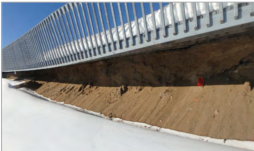
Photo 4 Détail des dommages causés par l'érosion du talus en décembre 2016 sur la promenade de bois de la rue des Rochelois (février 2017)
