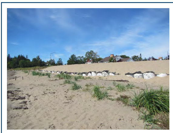
PHOTO 21 : Sacs et géotextiles – section ouest de la plage.
