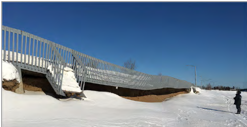
Photo 3 Vue rapprochée des dommages causés par l'érosion de la plage en décembre 2016 sur la promenade de bois de la rue des Rochelois – Partie ouest (février 2017)
