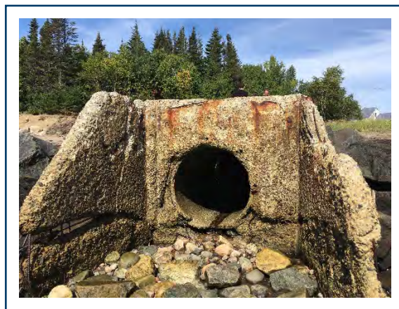
PHOTO 16 : Exutoire de l'émissaire pluvial
