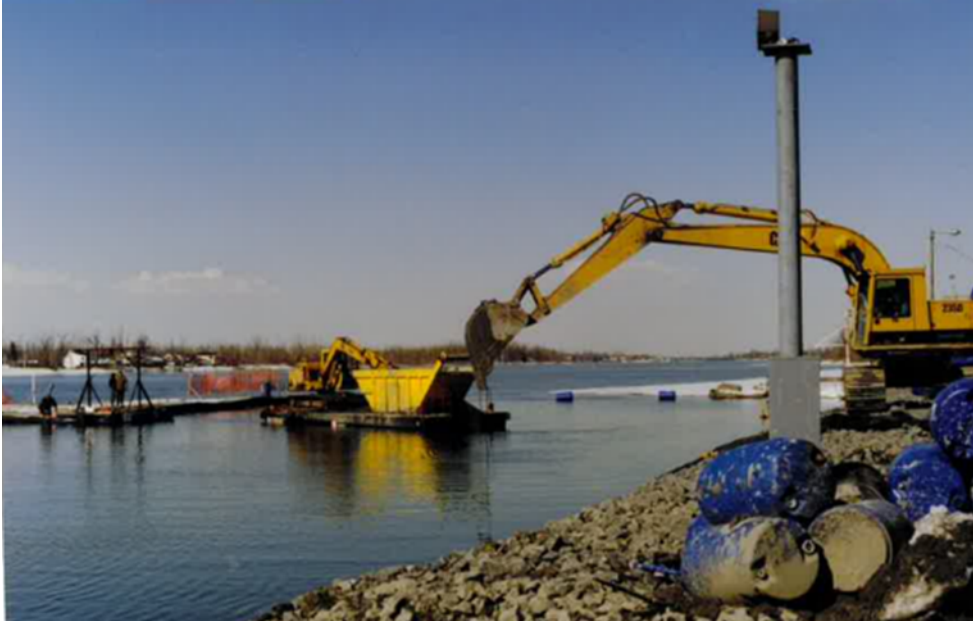
Figure 4-2 Dragues rétrocaveuses
