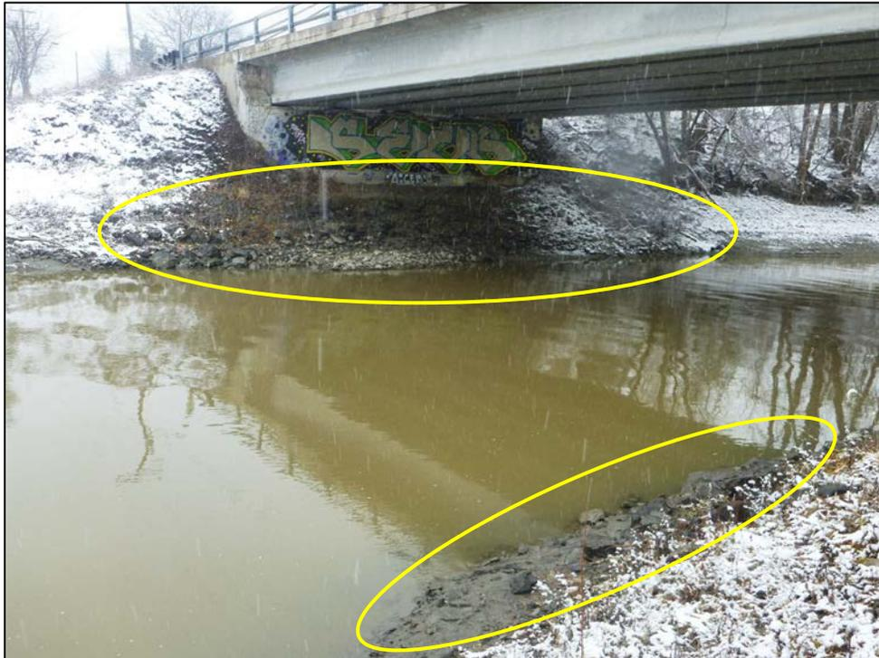
**Photo 3 Géotextile à découvert sous l'enrochement du pont du chemin Saint-Charles**
