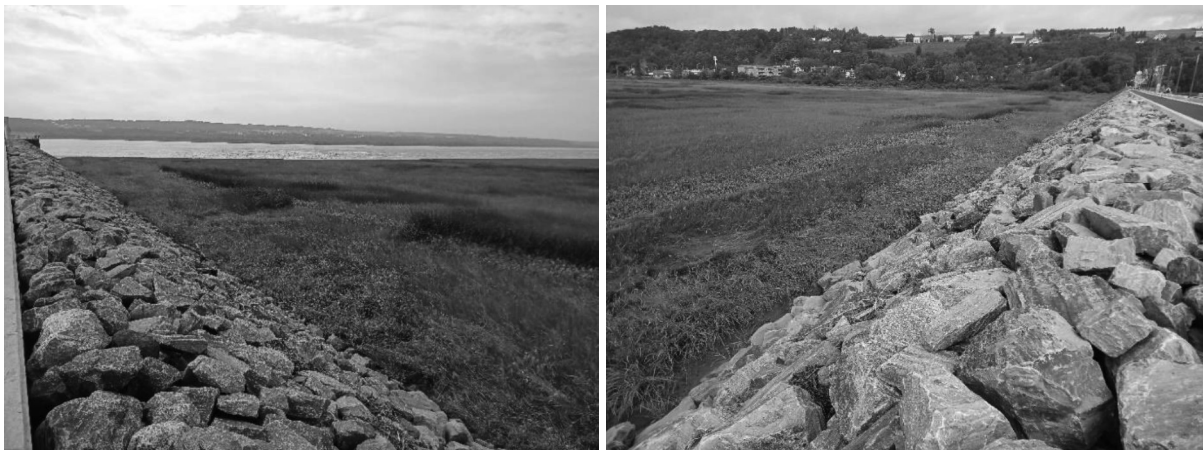
Photo 3.1 Reprise de la végétation au-dessus de la clé d'enrochement (vue du côté ouest du quai)
