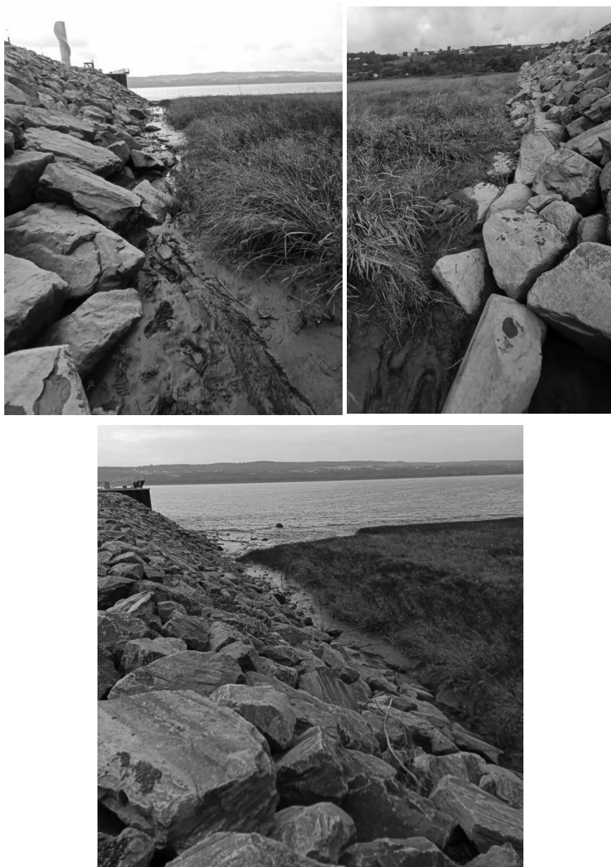
Photo 3.2 Bande d'une largeur de moins d'un mètre qui est moins végétalisée, à la base de l'enrochement de la tête du quai
