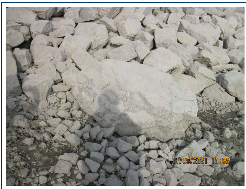
PHOTO 3 — Secteur amont, nid 2 (détruit par le perré du filtre inverse)
