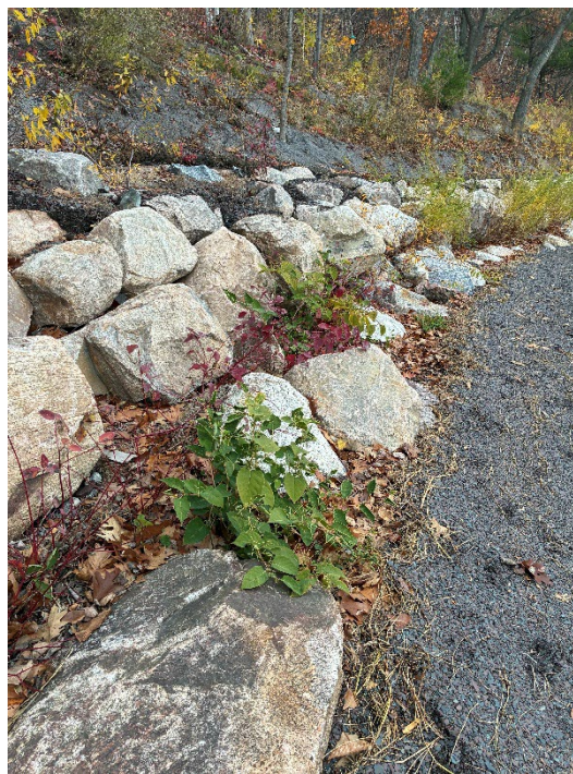
Photo 10 : Colonies de renouée du Japon en ligne (Ligne ; 0+240)
