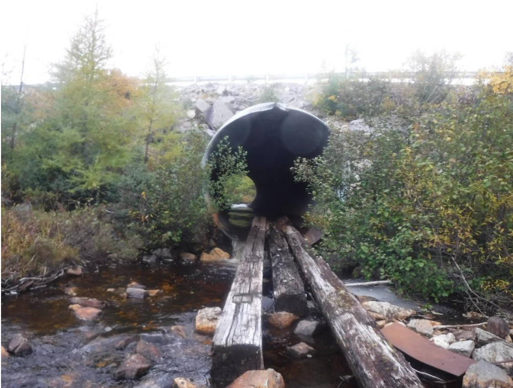
Vue de l'aval de la structure
