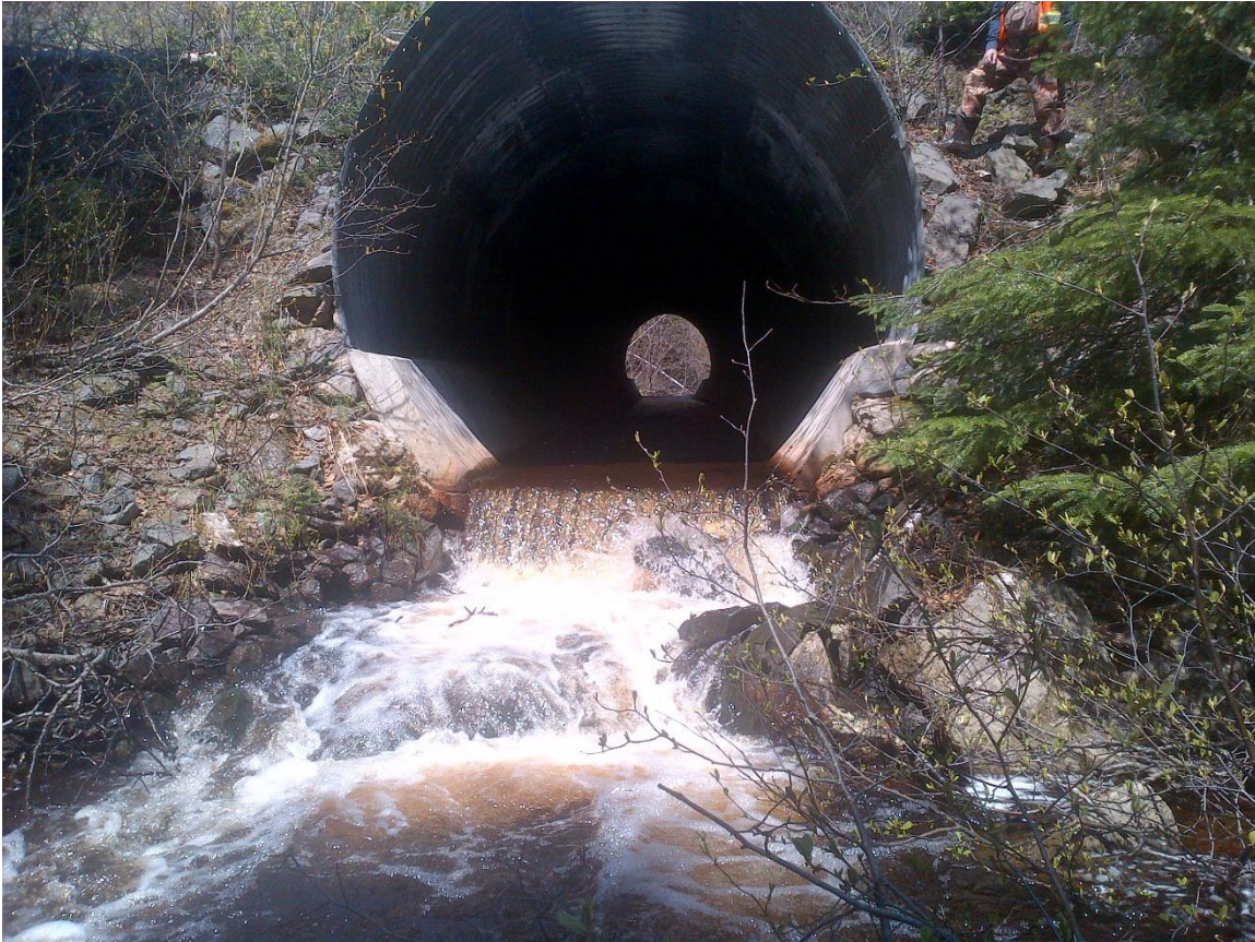
Aval du ponceau
