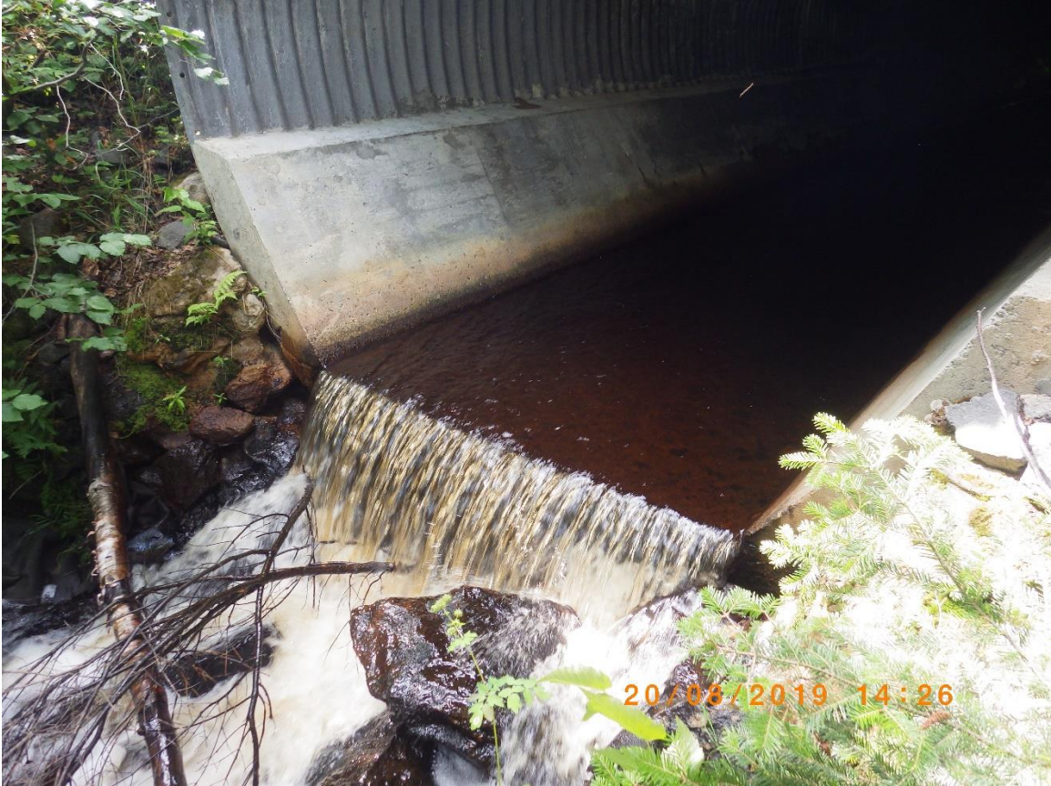
Vu de l'obstacle à la sortie du ponceau
