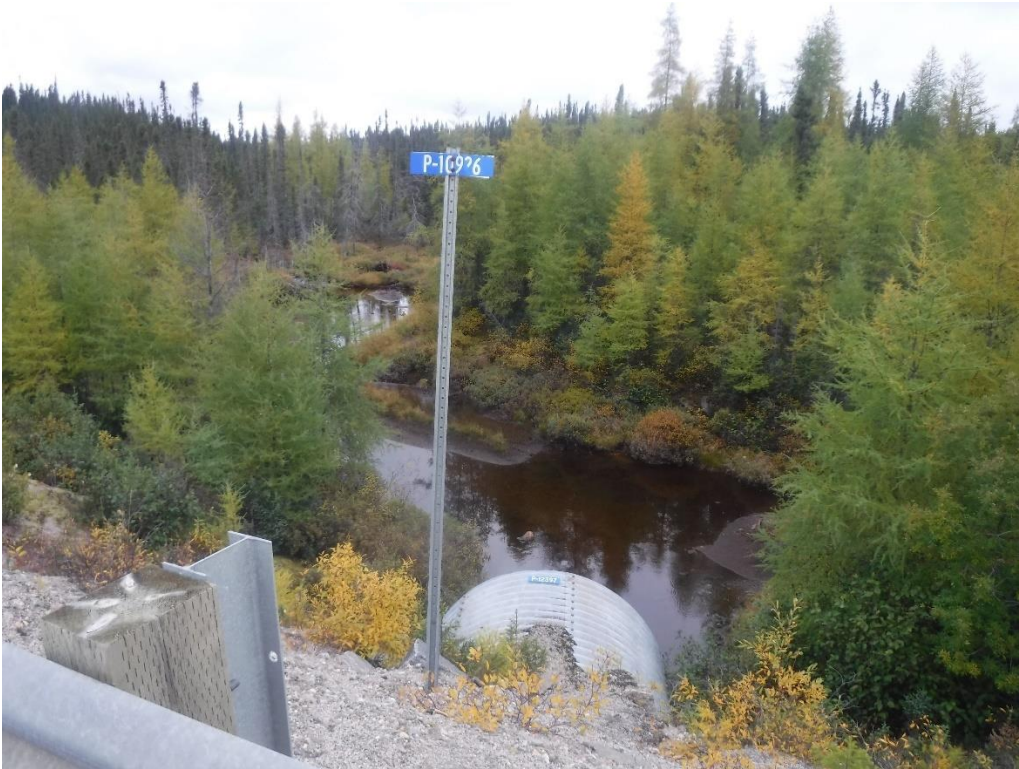
Amont du ponceau
