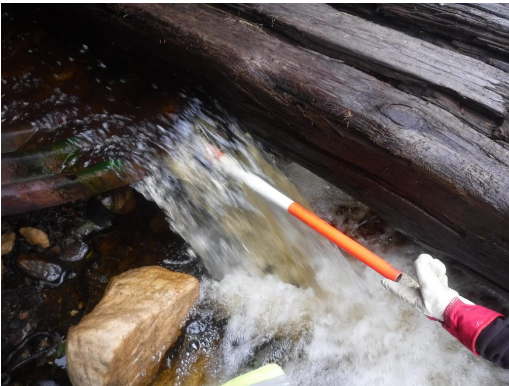
Vue de la chute à la sortie du ponceau
