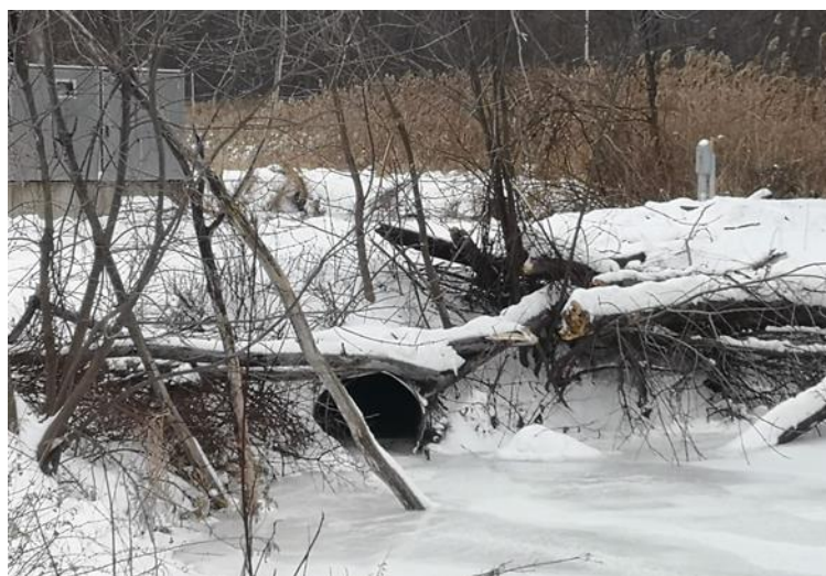
Photo 2 Vue sur l'entrée de la station de pompage
