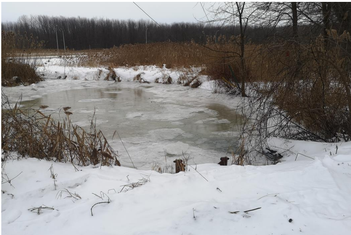
Photo 3 Vue sur le bassin en aval de la station de pompage
