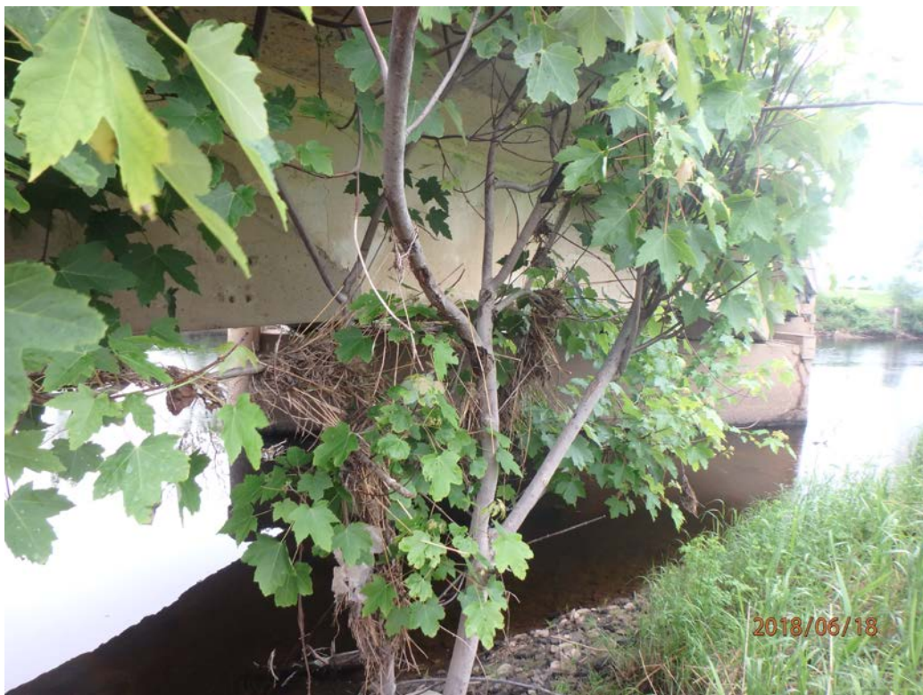
Figure 2.3 Laisse de crue en aval du pont P-04299
