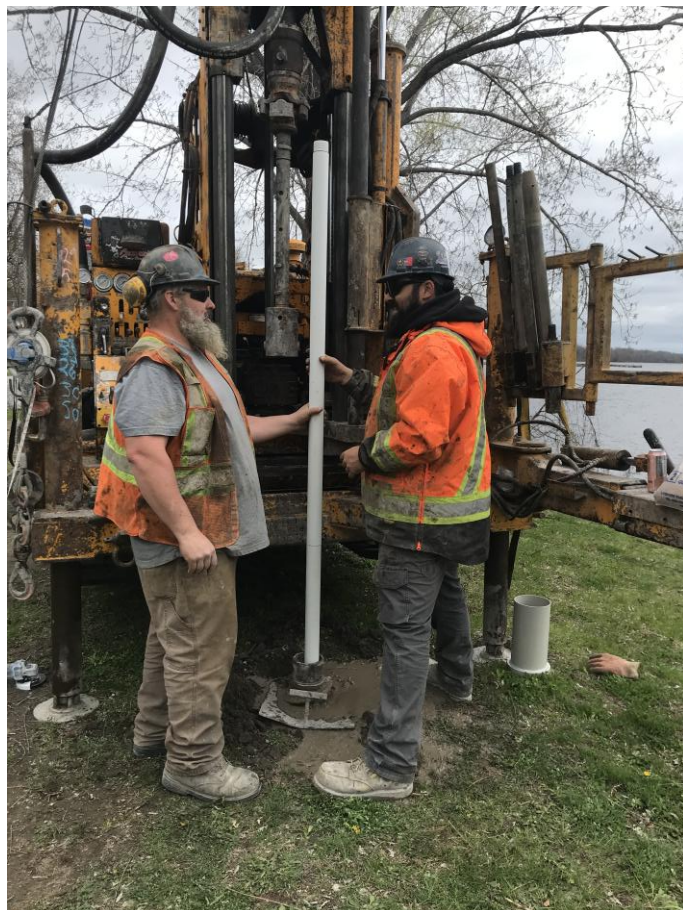
Forage et aménagement du puits P-4. Le 9 mai 2025.
