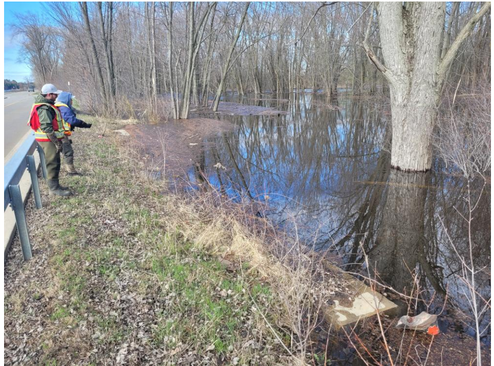
Aux abords du muret du ponceau. Le 30 avril 2025
