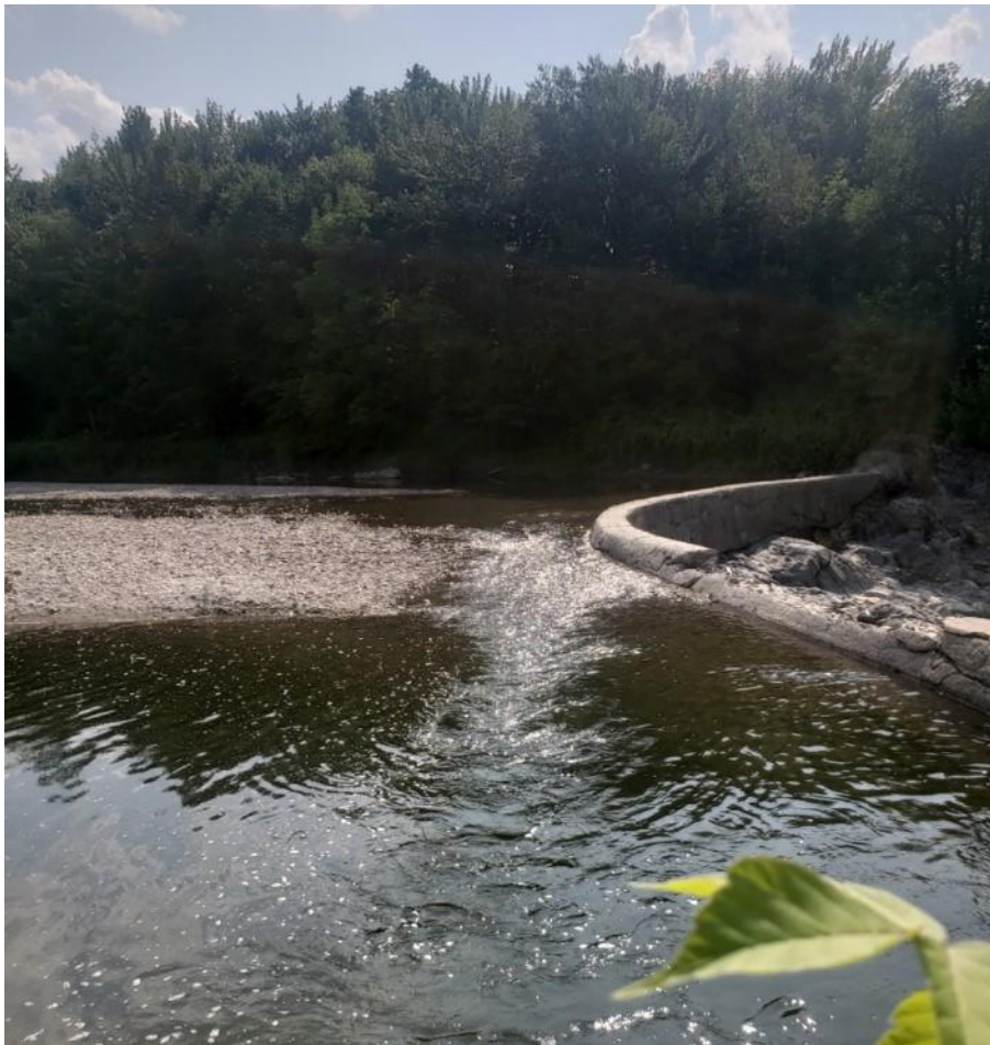
Figure 26 : Accumulation de sédiments en amont du barrage de Sainte-Sophie
