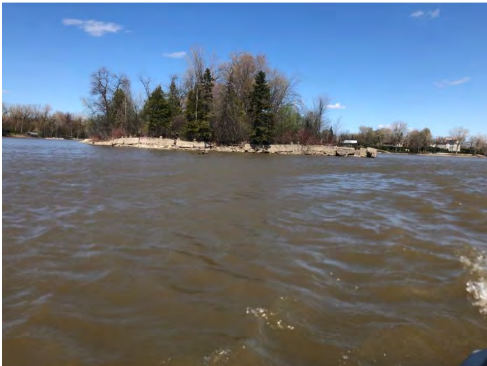
Photo 30 : Muret à la pointe de l'Île des Lys
