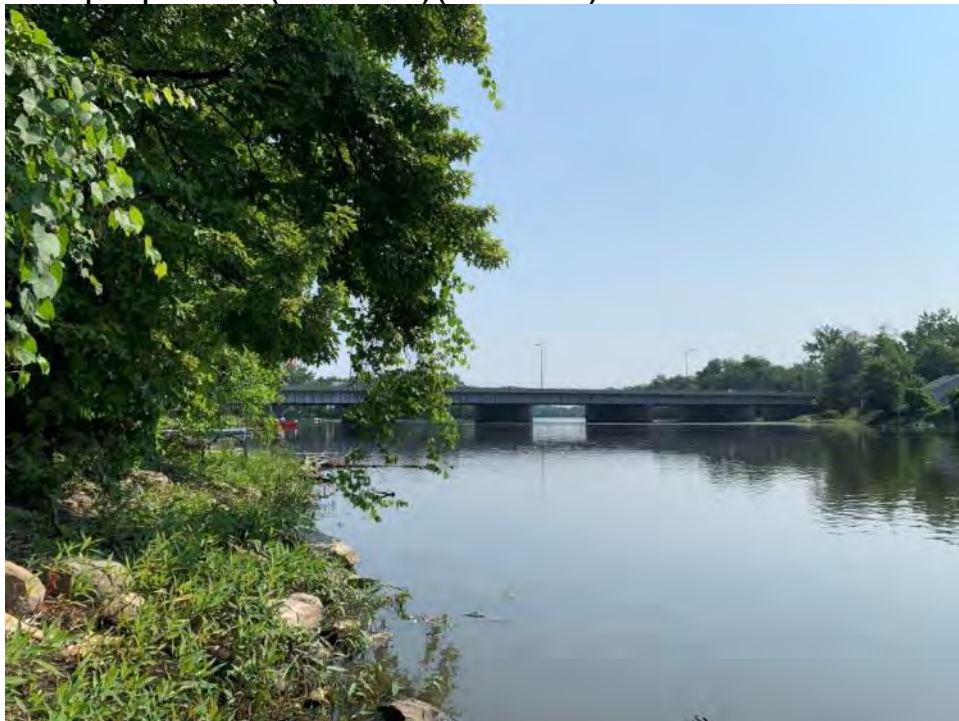
Photo 4 : Vue de l'approche nord du pont Gédéon-Ouimet à partir du chenal nord et de l'amont en rive gauche de la rivière des Mille-Îles, station aquatique SAM01 (Habitat no. 13) (10 août 2021)
