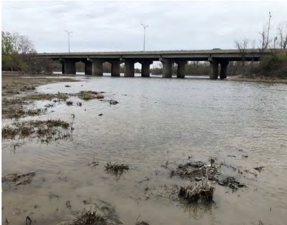
Photo 1 : Vue de l'approche sud du pont Gédéon-Ouimet à partir de l'amont en rive droite de la rivière des Mille-Îles, station aquatique SAS02 (Habitat no. 2) (4 mai 2021)
