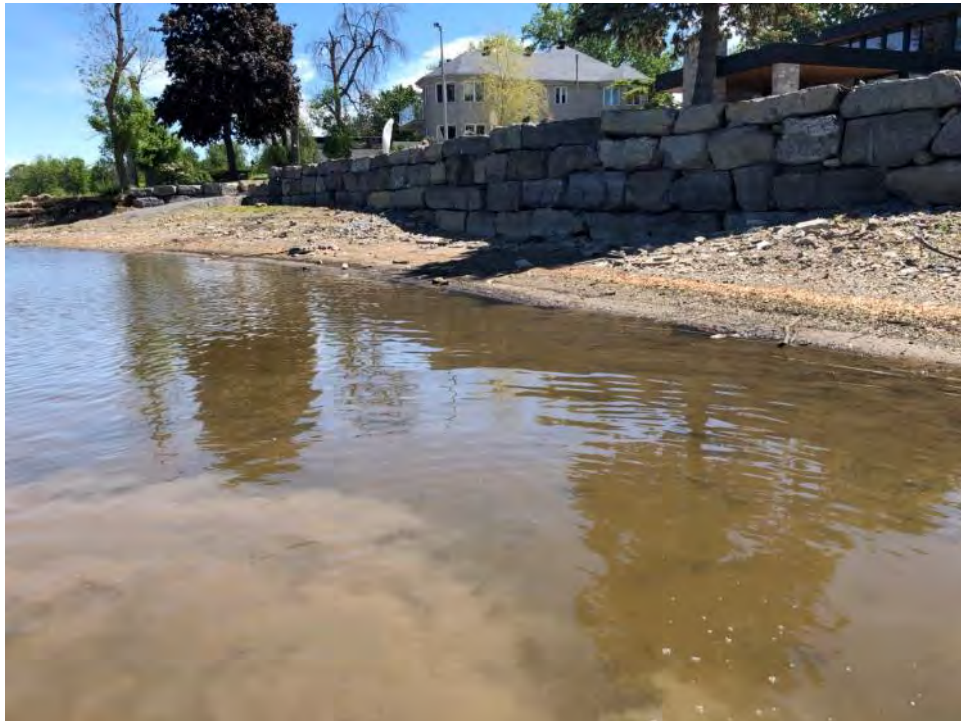
Photo 7 : Mur de soutènement, rive sud, section aval
