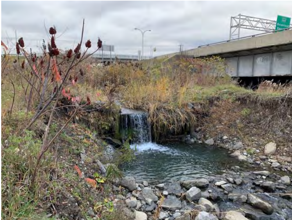
Photo 35 : Rive nord, émissaire en bordure de l'A-15, section amont
