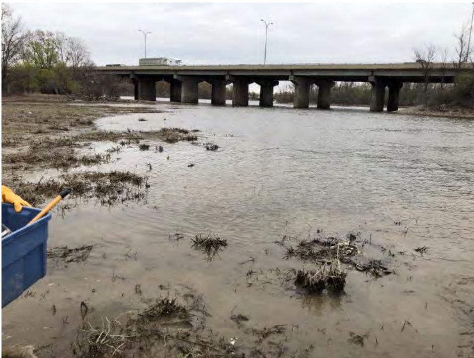
Photo 16 : Vue en aval de la station de pêche à la grande seine SAS01 (Habitat no. 2) (4 mai 2021)
