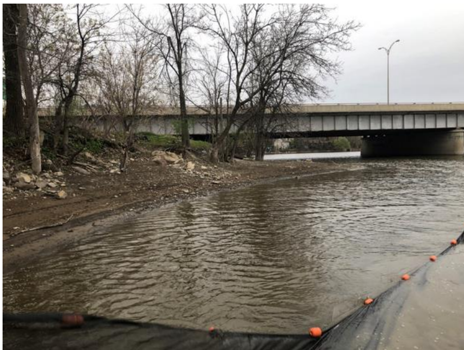
Figure 2.2 : Jetée nord, côté amont du pont P 09722 (source : Consortium Avenir A15)
