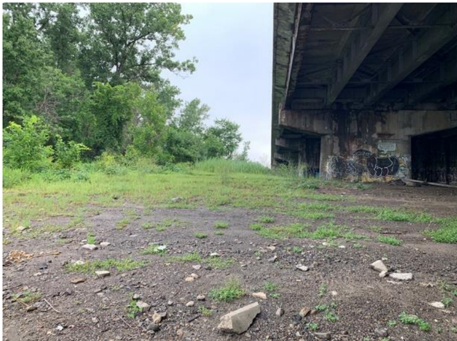
Figure 2.7 : île Morris sous l'A-15, rive gauche, chenal central, côté amont du pont P 09722 (source : Consortium Avenir A15)
