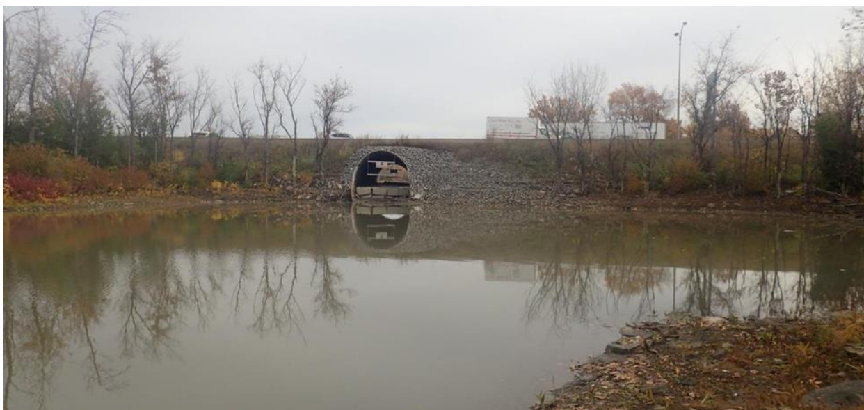
Figure 2.1 : Ponceau P-09774 vu depuis l'amont (source : MTQ, 2020)
