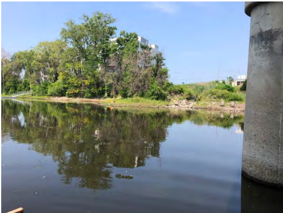
Photo 34 : Rive nord, section amont
