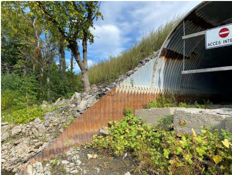
Photo 4 : Indicateur physique – Marque linéaire à l'intérieur d'un ponceau sous l'A-15
