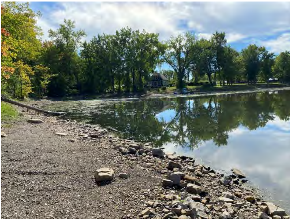
Photo 16 : Rive en bordure du boulevard de Lisbonne, côté Nord-Ouest
