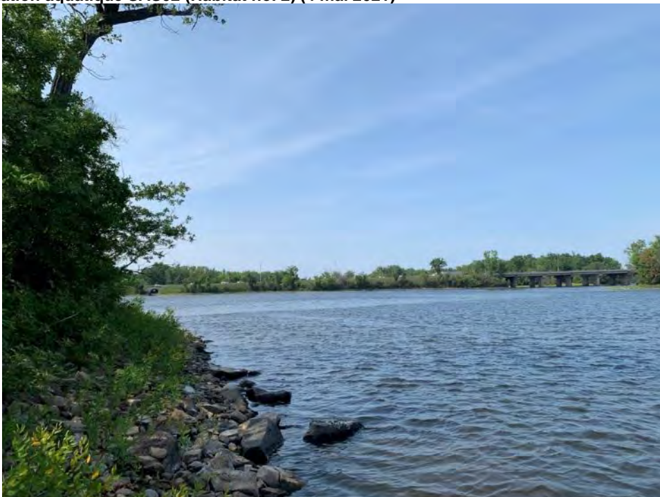
Photo 2 : Vue de l'approche sud du pont Gédéon-Ouimet à partir de l'aval de la rivière des Mille-Îles sur l'île à l'ouest de l'île Langlois, station aquatique SAM06 (12 août 2021)
