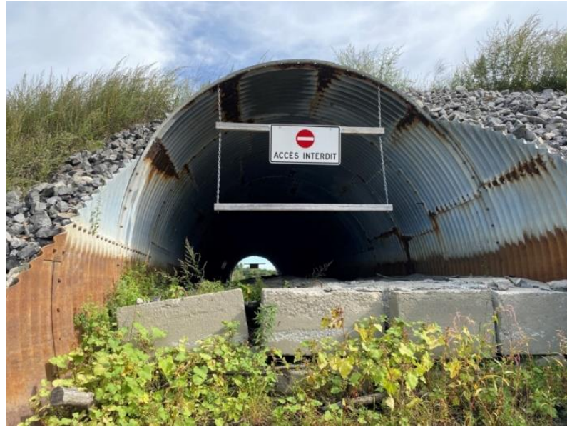
Figure 2-15 Radier comblé et présence de blocs de béton à l'entrée du ponceau, sous la jetée de l'approche sud
