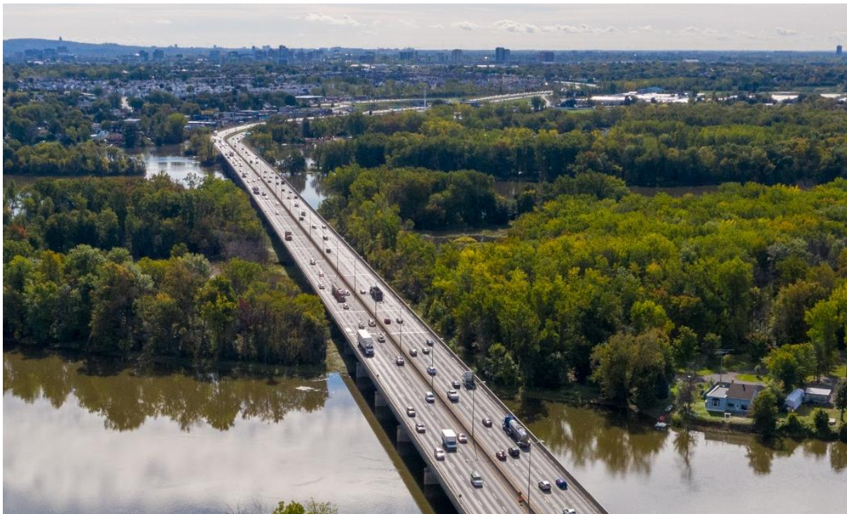
Pont Gédéon-Ouimet – Vue en direction sud
