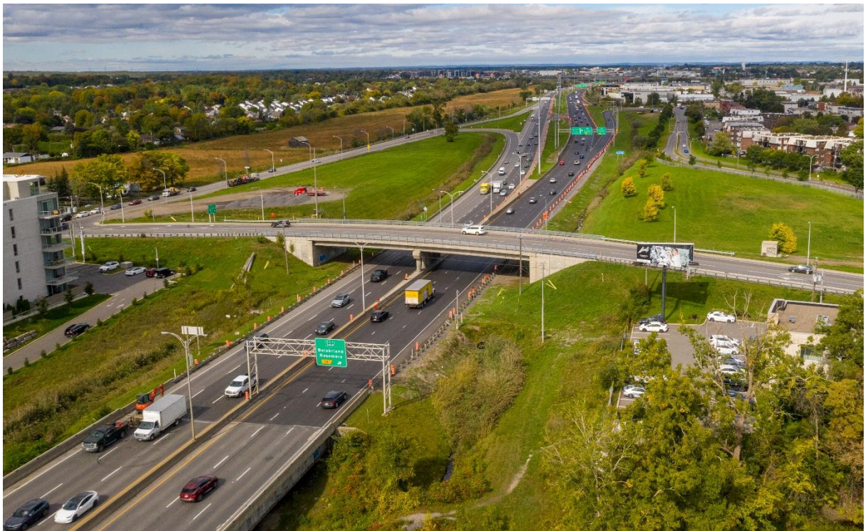
Approche nord et viaduc de la R-344 – Vue en direction nord
