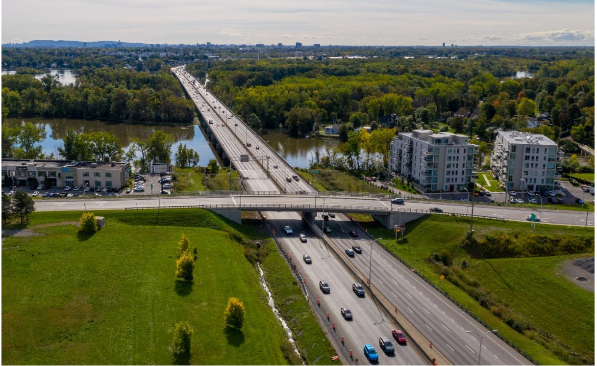
Approche nord et viaduc de la R-344 – Vue en direction sud
