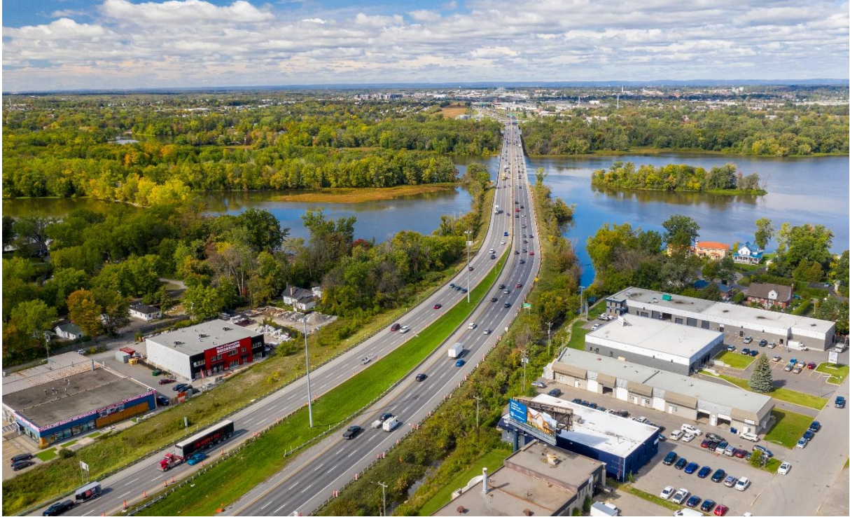
Approche sud – Vue en direction nord
