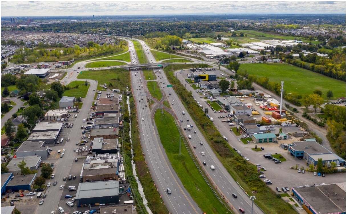
Approche sud – Vue en direction sud
