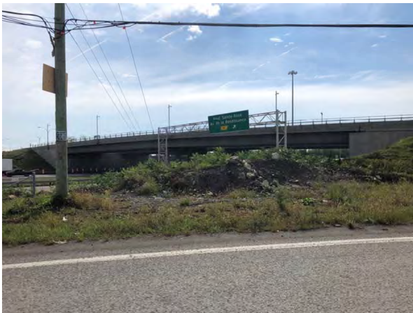
Photo 42 – Vue de la pile de remblais observée à l'ouest de l'A15 au nord du pont du boulevard Sainte-Rose depuis la rue de Jaffa (Source : photographie prise le 9 septembre 2021)
