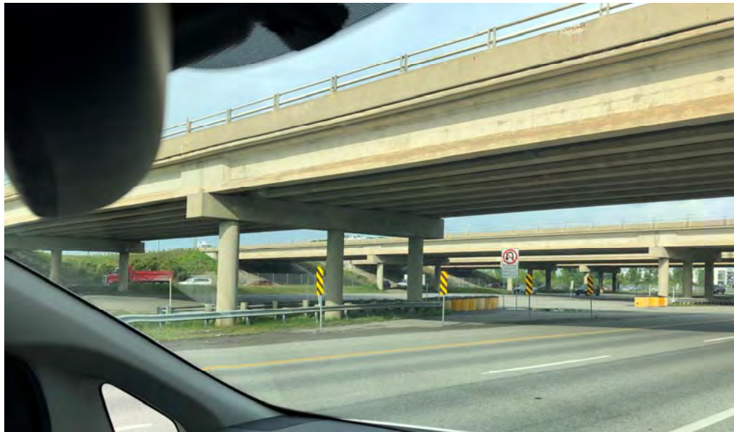
Photos 17 et 18 – Vues des ponts de l'autoroute 440 et de ses dessertes de chaque côté de l'A15 construits sur du remblai (Source : photographies prises le 9 septembre 2021)
