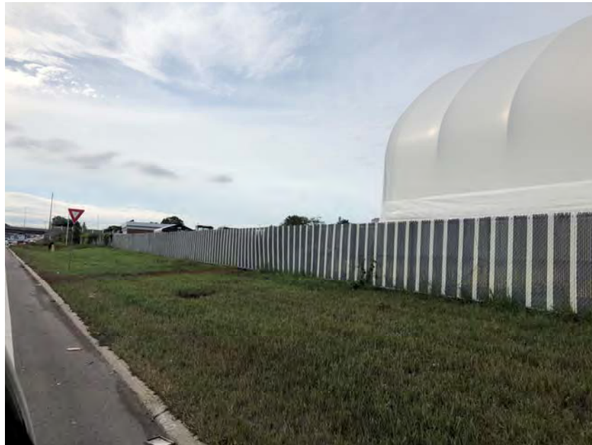
Photo 8 – Vue du centre de service depuis la bretelle d'accès à l'A15S (km 0+850) (source : photographie prise le 9 septembre 2021)
