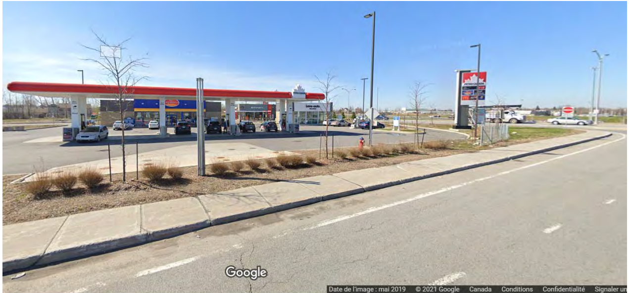
Photo 41– Vue de la station-service Pétro Canada située avenue de la renaissance (Source : Google Street View)
