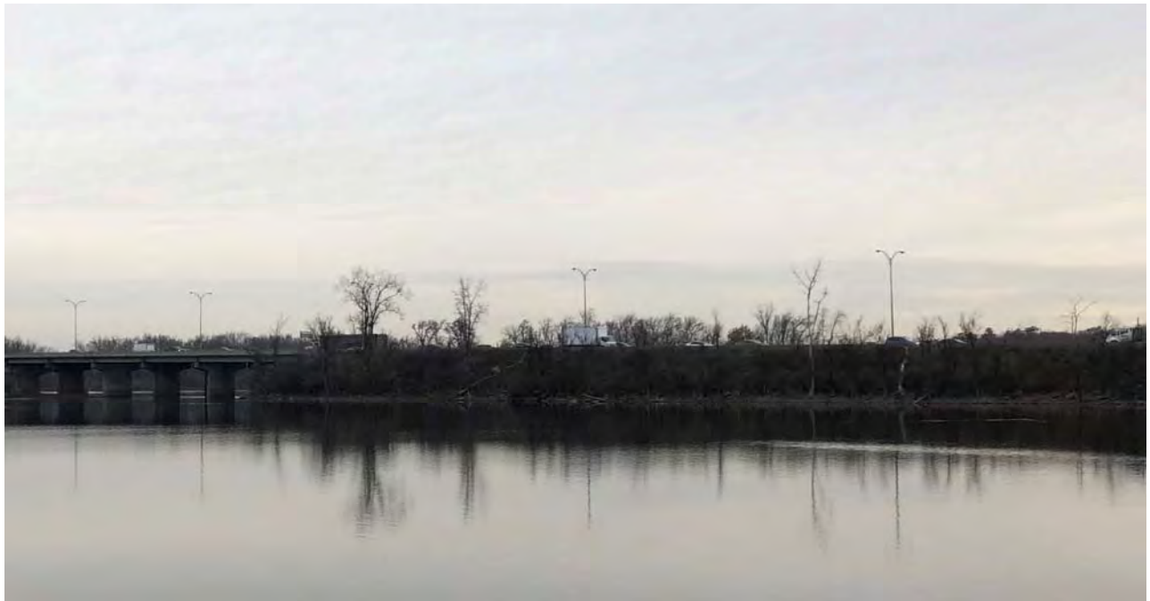
Photo 54 – Vue de la portion de l'autoroute construite sur du remblai entre les km10+900 et 11+250
