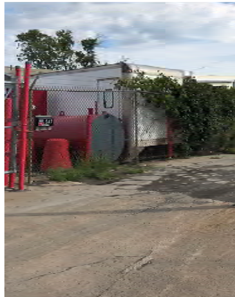
Photo 36 – Réservoir observé sur le site de la compagnie de déneigement au 545 Rue Lindbergh (Source : photographie prise le 9 septembre 2021)
