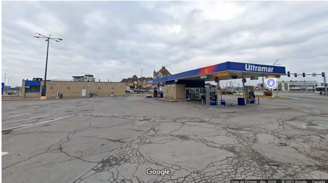
Photo 9 – Vue du de la station-service Ultramar située à l'angle des boulevards Saint-Martin et le Corbusier (Source : Google Street View)
