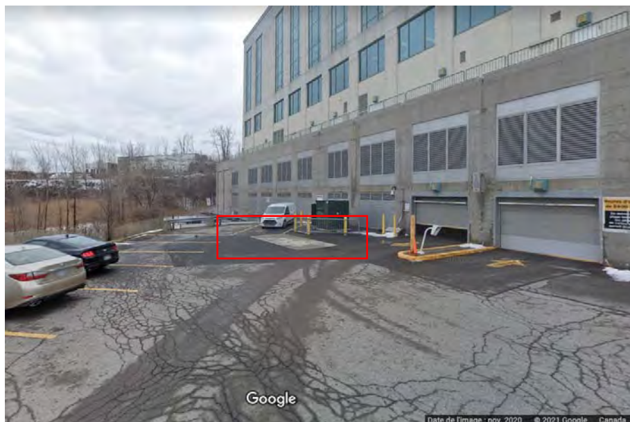
Photo 10 - Vue de l'emplacement des réservoirs souterrains du Palais de justice de Laval (Source : Google Street View)
