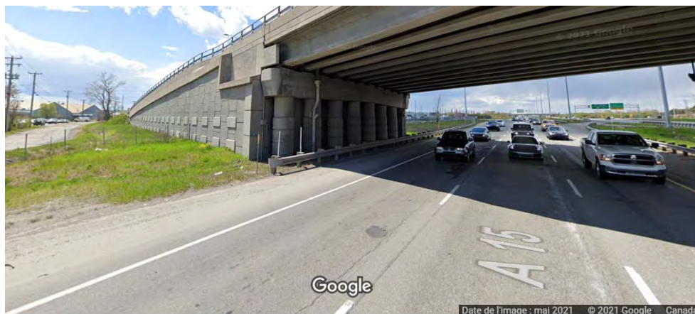
Photos 29, 30 et 31 – Vues du pont du boulevard Dagenais de chaque côté de l'A15 construit sur du remblai (Source : Google Street View)
