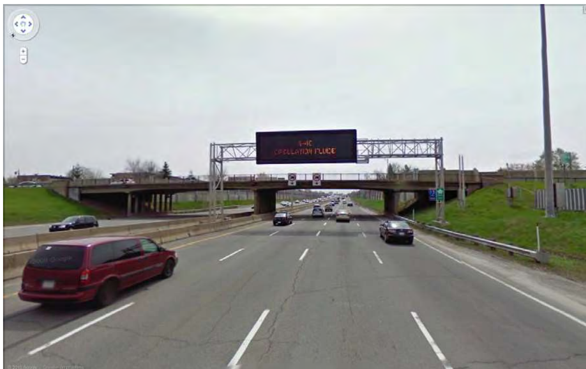
Figure 2 : Vue générale du pont d'étagement en direction sud (source google maps)
