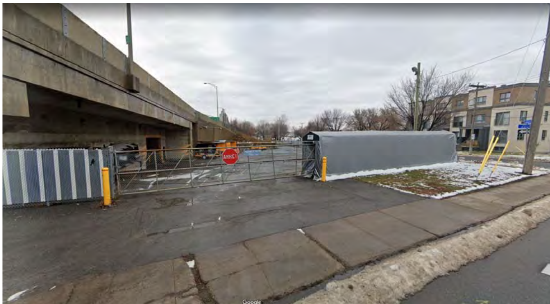
Photo 2 – Vue de l'aire d'entreposage d'équipements du MTQ à l'est de l'A15N (km 0+00) (Source : Google Street View)
