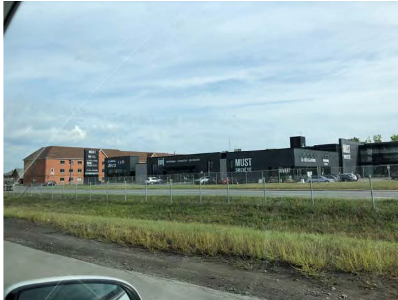
Photo 11 – Vue du bâtiment commercial construit sur le terrain contaminé 1965 ADL S.E.C. (Source : photographie prise le 9 septembre 2021)
