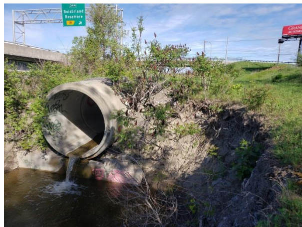
Figure 18: Zone 3B, sortie de ponceau, vers l'ouest
