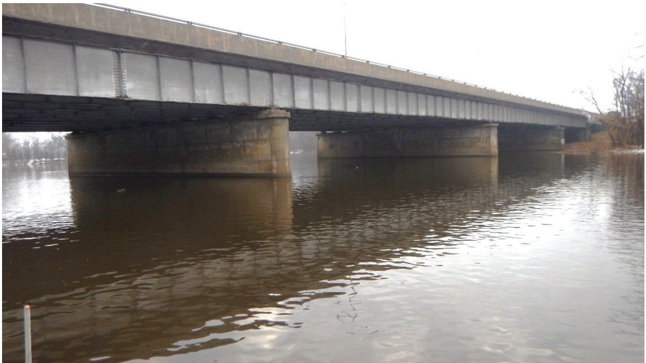
Figure 3.3 Piles existantes dans le chenal nord
