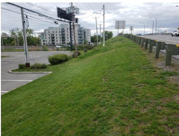
Figure 14: Zone A2, remblai de rehaussement et poteaux de services publics, vers le sud
