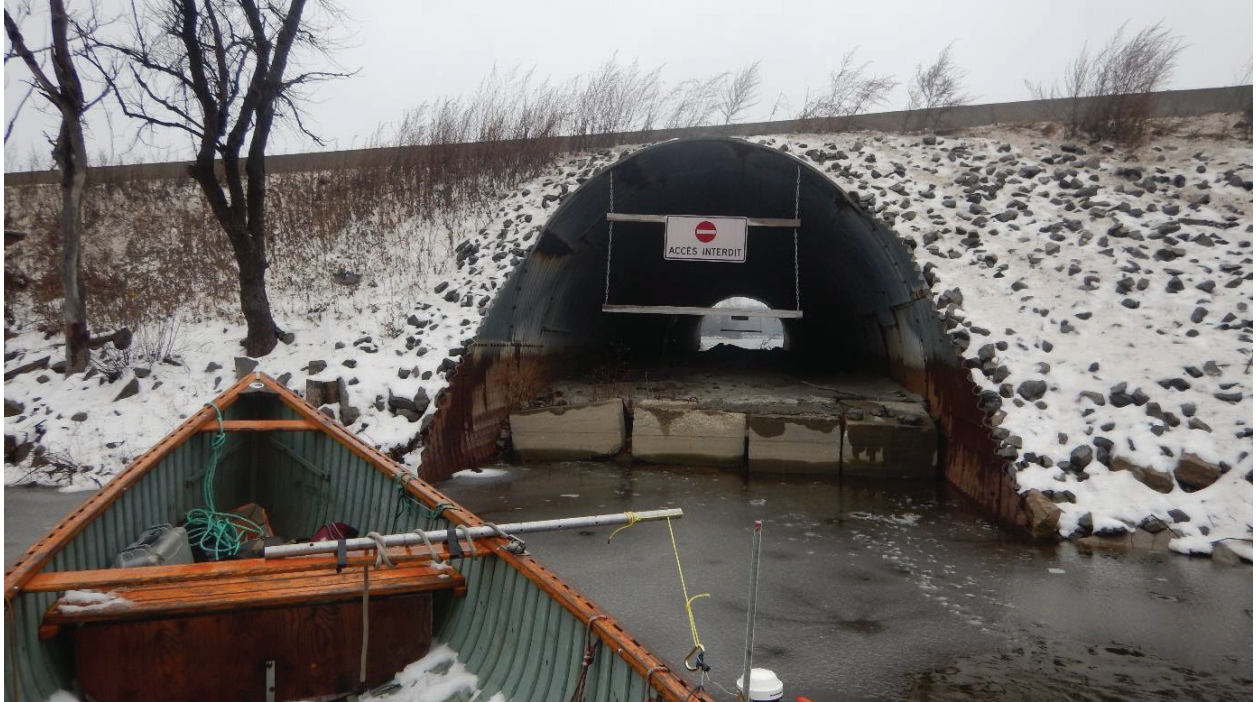
Figure 2.2 : Entrée du ponton P-09774. Photo prise le 26 novembre 2020
