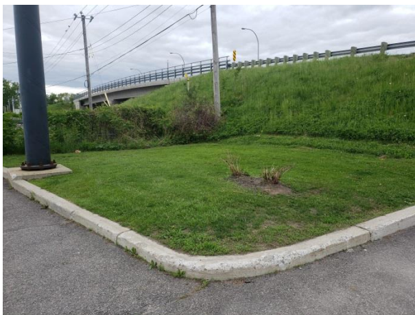
Figure 15: Zone A2, replat avec remblai de rehaussement en arrière-plan et poteaux de services publics, vers le sud-ouest
