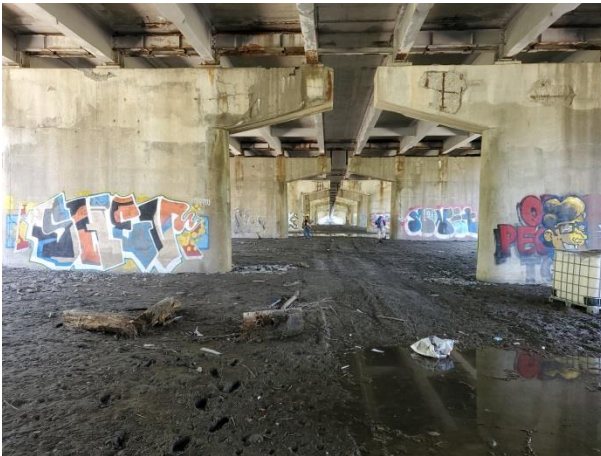
Figure 25: Zone A12, zone boueuse, plate et sans végétation avec assise de pont, vers le sud-est
