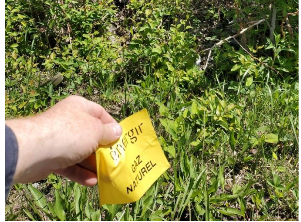
Figure 34: Zone A22, ligne de gaz, vers le nord-est
