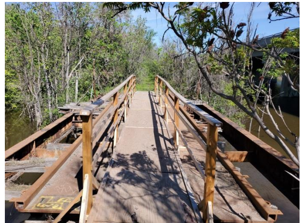
Figure 24: Zone A3, ponceau métallique, vers le nord-ouest
