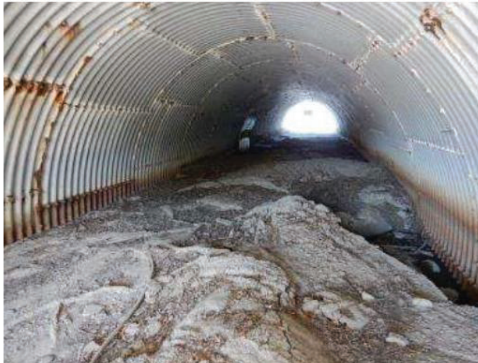
Figure 2.3 : Intérieur du ponton P-09774. Photo prise le 29 septembre 2022
