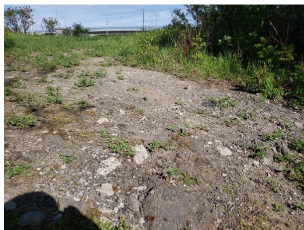
Figure 20: Zone 3B, remblai en surface, vers le nord-ouest
