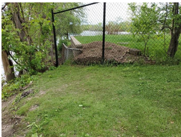
Figure 29: Zone A21/E18, relèvement artificiel des berges, vers le nord-ouest
