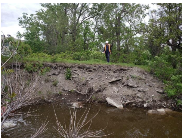
Figure 19: Zone 3B, remblai de plusieurs mètres, vers le nord-est
