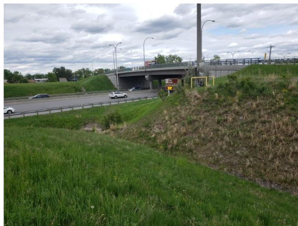
Figure 10: Zone E2, pente abrupte près de l'autoroute 15, vers l'est
