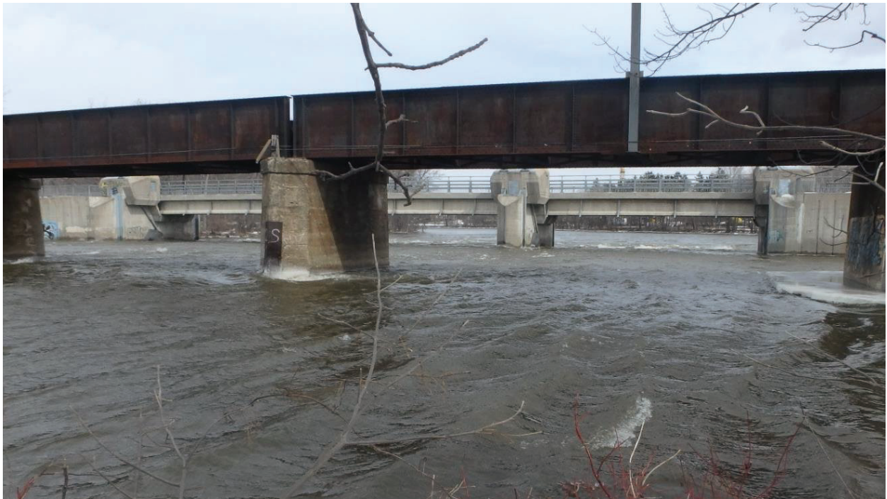
Figure 7.8 Conditions d'écoulement au droit du barrage du Grand-Moulin le 10 mars 2017 : Débit ~520 m 3 /s
