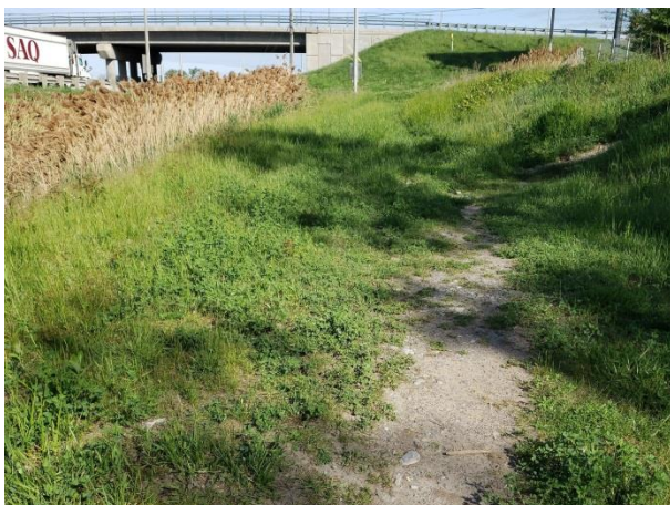
Figure 17: Zone 3B, bande gazonnée longeant un talus de drainage, vers le nord-ouest
