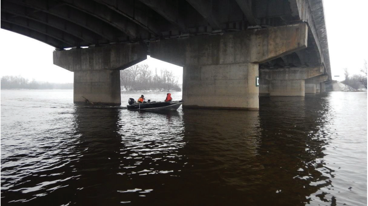
Figure 3.4 Piles existantes dans le chenal principal
