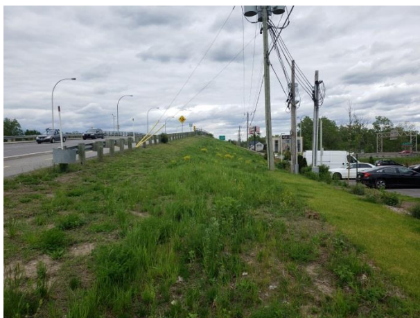
Figure 13: Zone A1, remblai de rehaussement avec poteaux de services publics, vers le nord-est
