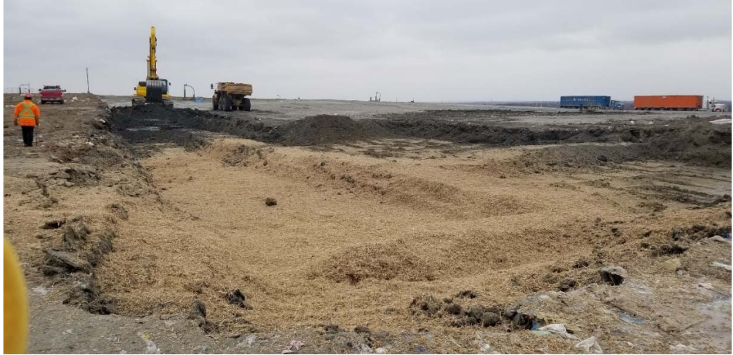
Photo 1 : Utilisation d'un paillis imbibé de neutralisant d'odeur lors du retrait du recouvrement final en place sur les cellules 5 à 8 de la phase 2.
