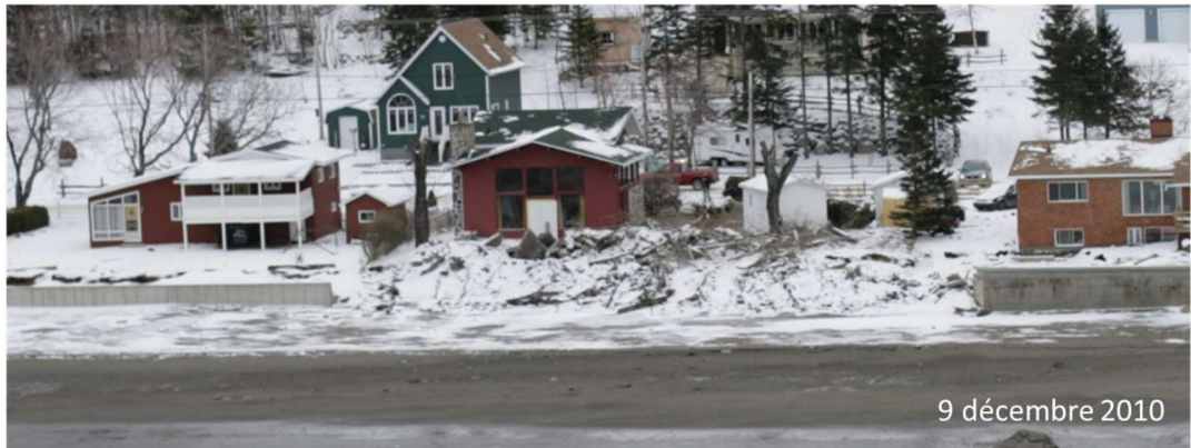
Figure 7. Photos prises avant et après la tempête du 6 décembre 2010, montrant les forts reculs derrière les ouvrages de protection
