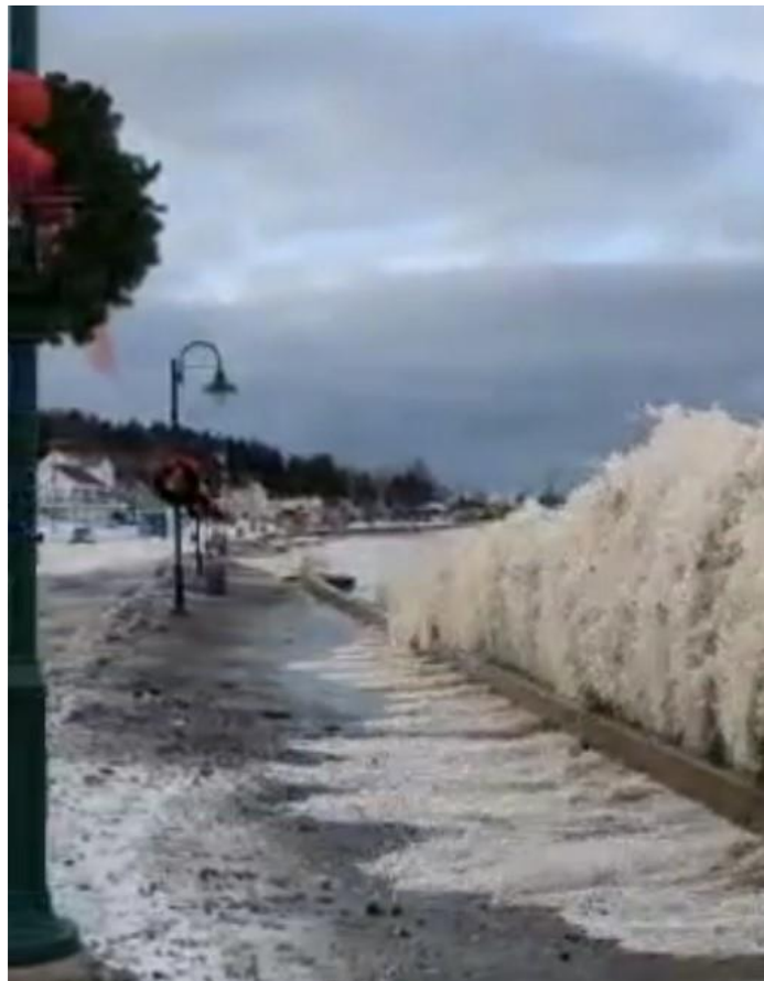
Figure 10. Franchissement par les vagues et projection de débris sur la promenade, au-dessus de la recharge de plage, lors de la tempête du 23 et 24 décembre 2022
