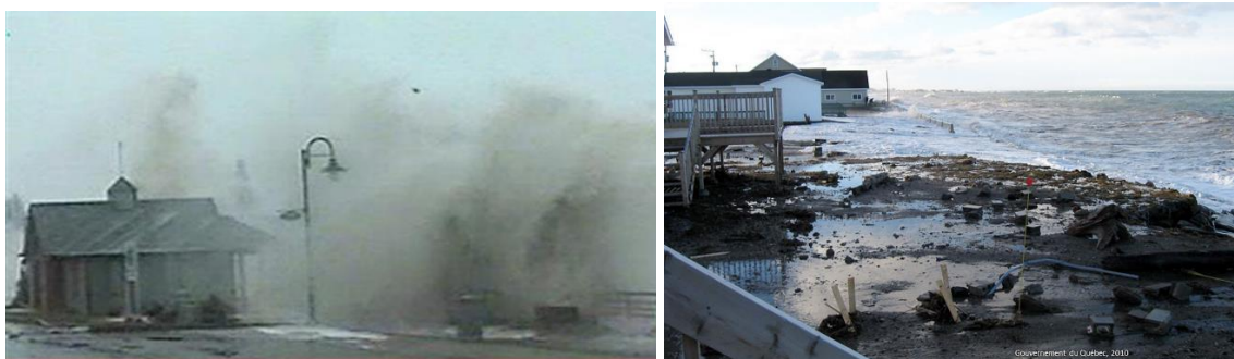
Figure 6. Franchissement par les vagues au-dessus des ouvrages de protection et projection de débris lors de la tempête du 6 décembre 2010
