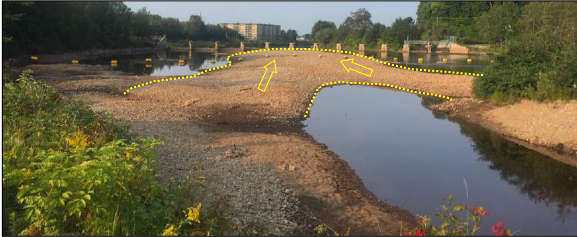
Figure 2: Remplissage récent du réservoir et prolongement de la presqu'île vers l'aval (photo du 20 août 2021). Les vannes étaient ouvertes.
