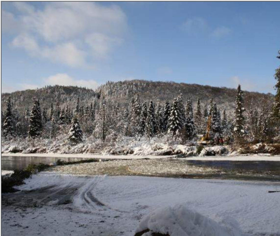
Figure 6. Photo lors de la pose de l'estacade flottante le 9 décembre 2016. Le frasil est rapidement capté à l'estacade, mais il transitera sous le couvert quelques heures plus tard démontrant la nécessité de construire un seuil.
