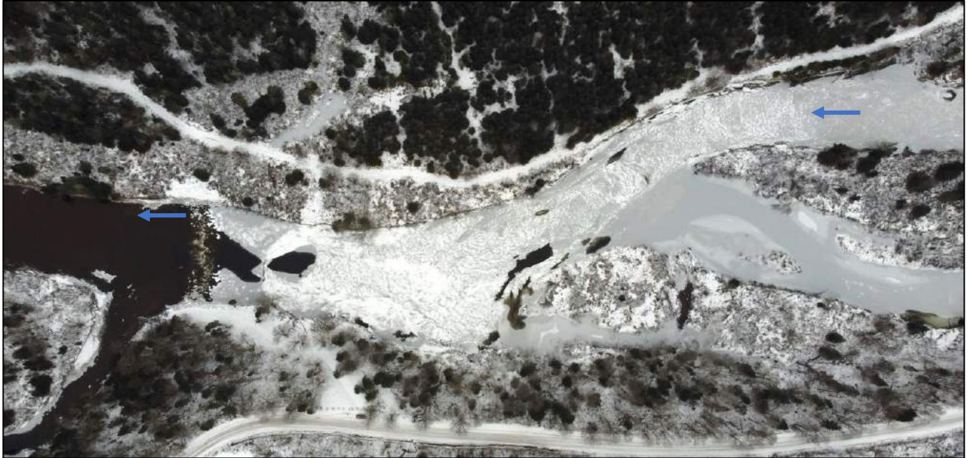
Figure 9. Vue aérienne de la prise des glaces en amont du seuil et en amont de l'estacade au km 24, le 24 novembre 2020, soit 12 jours après l'installation de l'estacade (Multimédias Région Portneuf, 2020). La flèche indique le sens de l'écoulement.
