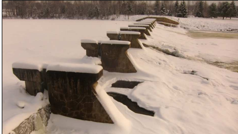
Figure 2. Barrage Estacade avec couvert de glace hâtif formé le 21 décembre 2016 à la suite à la gestion active des poutrelles des pertuis nos 1 et 2 par une grue (vue de la rive droite, le courant allant de gauche à droite)
