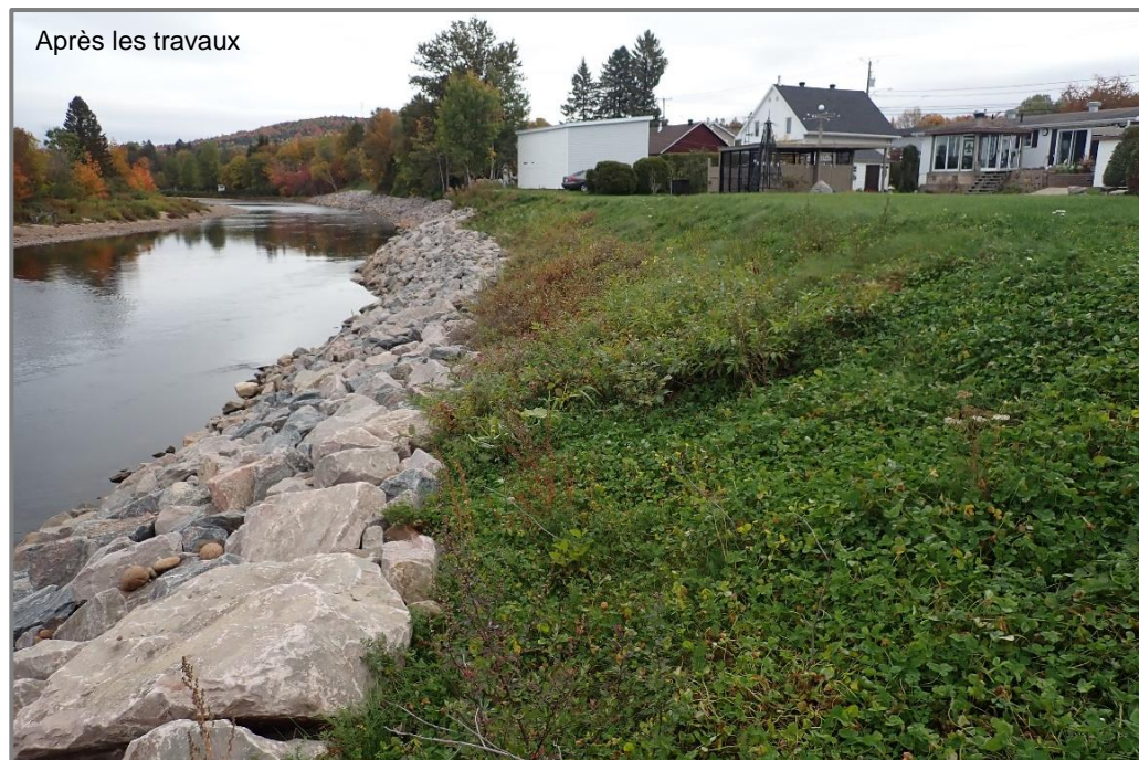
Figure 3 : Stabilisation de la rive gauche en amont du réservoir du barrage-estacade en 2018.
