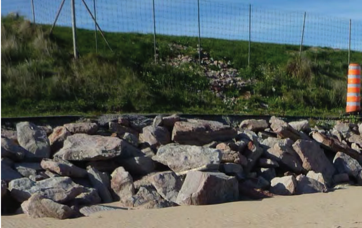
Figure 9.9 Dommage infligé par le franchissement des vagues sur le talus des étangs aérés
