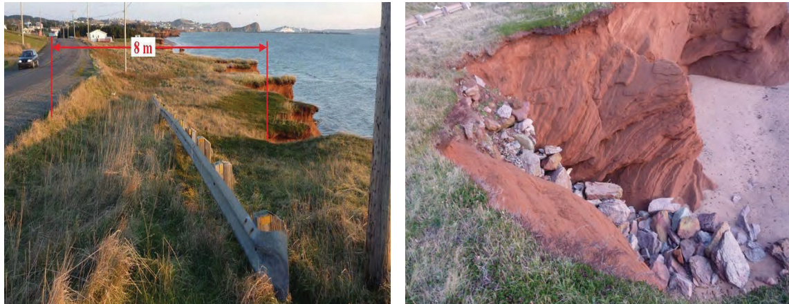
Figure 14.1 – Vues du chemin de Gros Cap à protéger, près de la garderie
