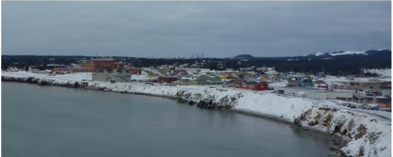
Figure 2.41 Secteur de l'hôpital – Falaises en érosion
