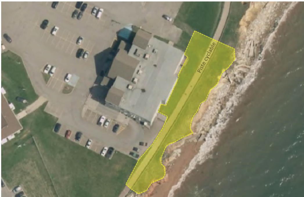
Figure 3. Périmètre de sécurité tel qu'il était aménagé lors de la visite du site.
