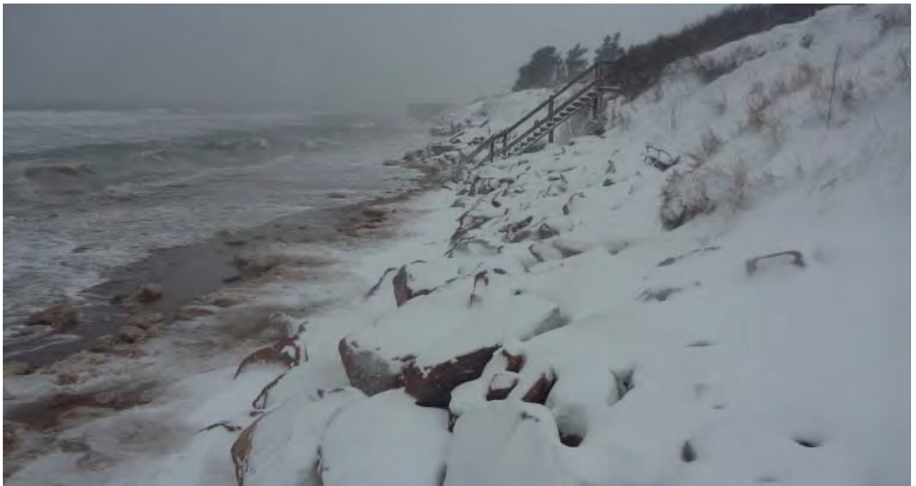
Figure 2.28 Pointe de la Martinique – Protection en enrochement relativement efficace
