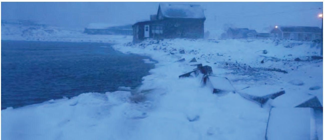
Figure 2.38 Protection de berge improvisée dans la partie orientale de la plage
