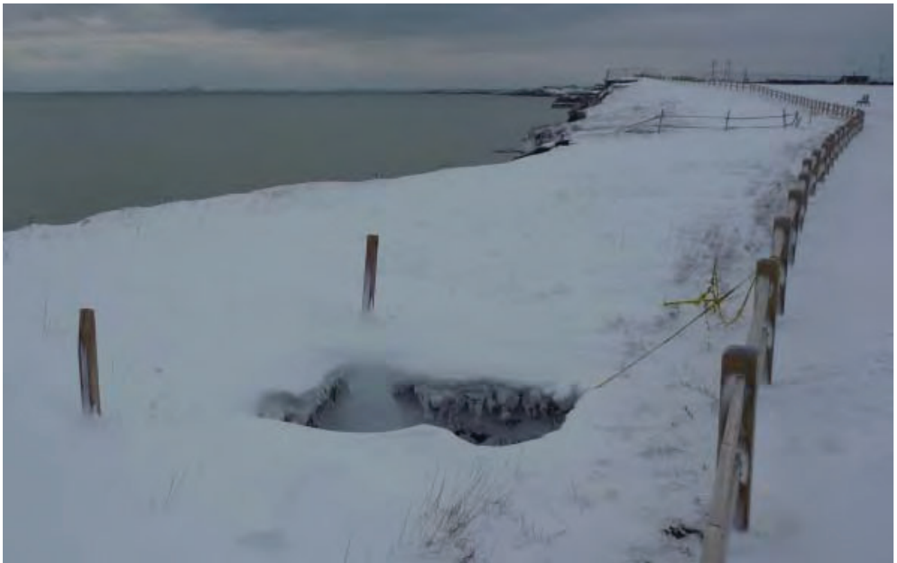
Figure 2.42 Secteur de l'hôpital – Érosion par effondrement vertical (cheminée)
