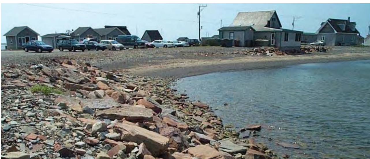
Figure 2.40 Protection de berge devant la maison la plus à l'est sur la plage de La Grave en 2002
