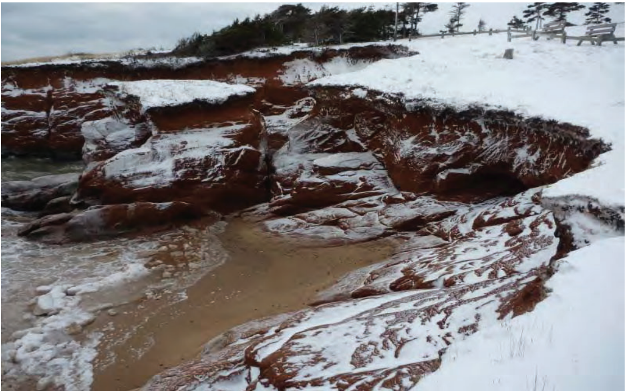
Figure 2.11 Secteur du Gros-Cap – Érosion des falaises
