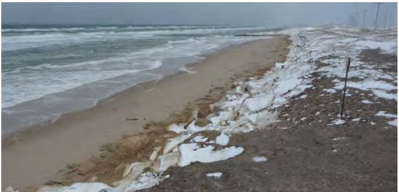
Figure 2.48 Épi et enrochement au nord de Pointe-aux-Loups
