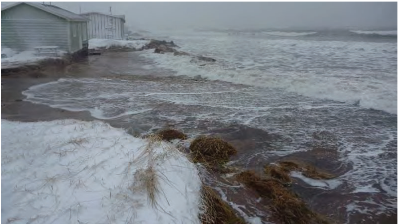
Figure 2.20 Secteur du chemin des Chalets– Tempête du 27 janvier 2011
