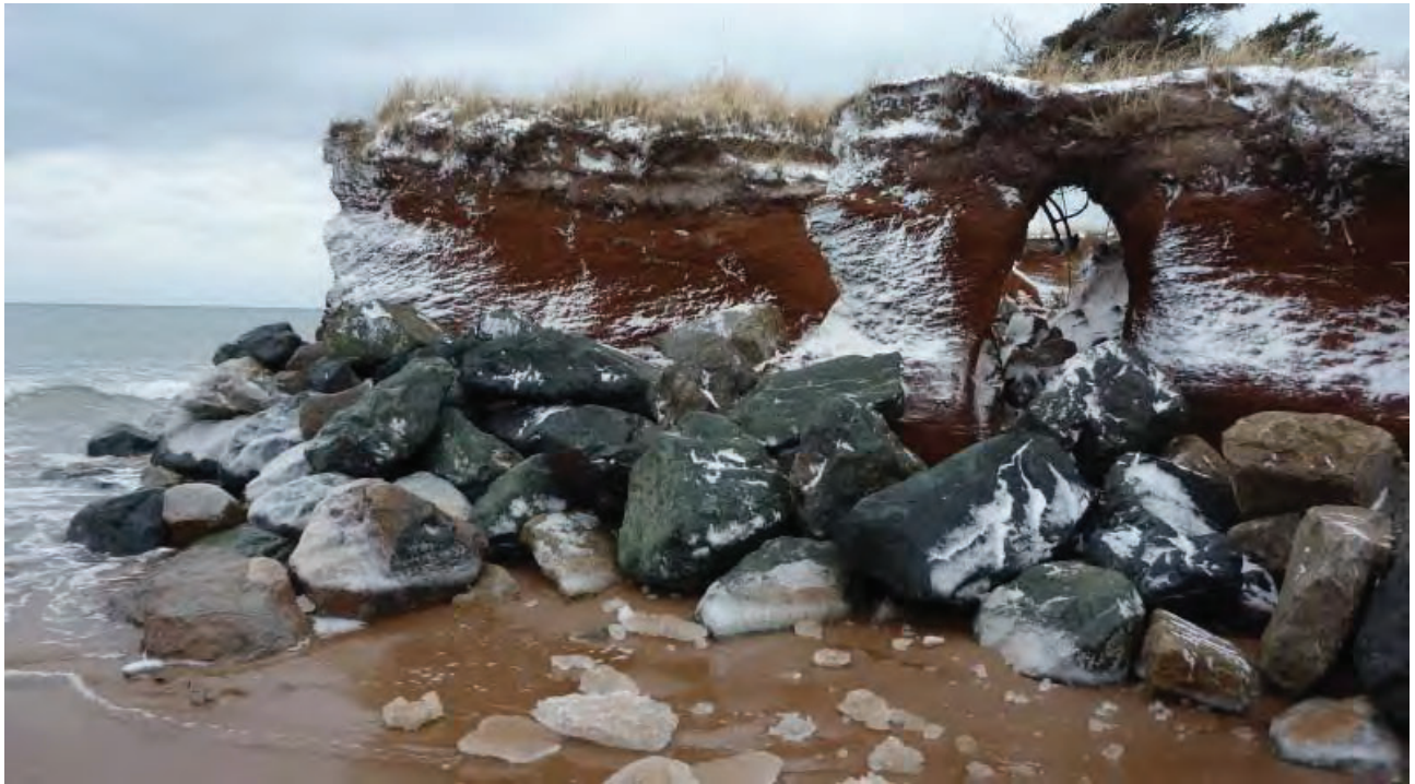
Figure 2.12 Secteur du Gros-Cap – Protection récente d'une falaise en érosion
