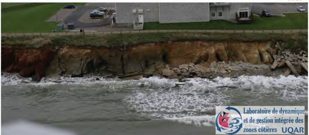
Figure 2. Vues obliques multitudes du site à l'étude
