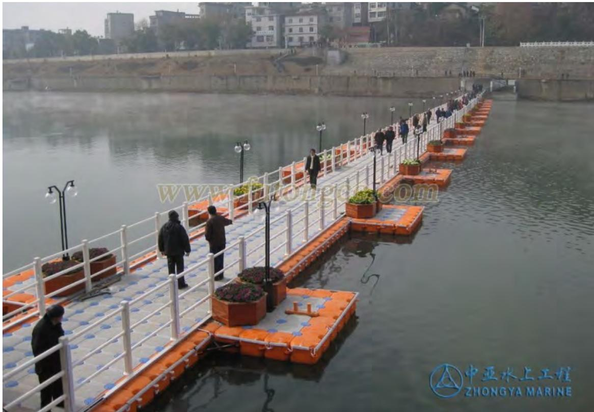
Figure 10 – Exemple d'un pont flottant en plastique
