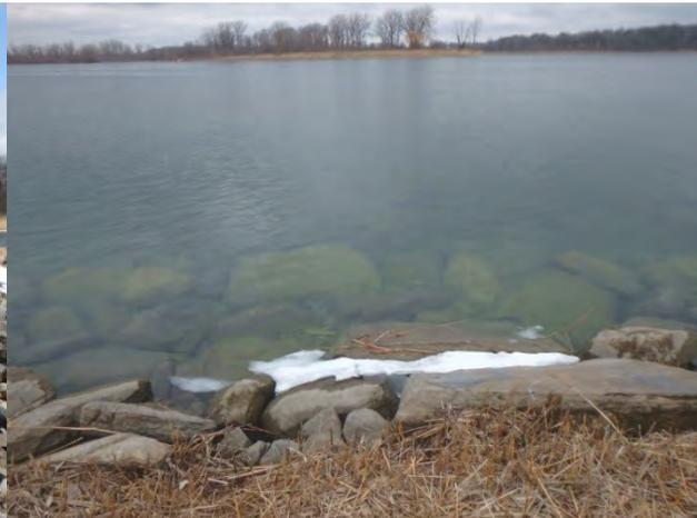
Photo 2 – STRCT 1 – Enrochement actuellement en place au pied aval de plus gros calibre (16 avril 2018)
