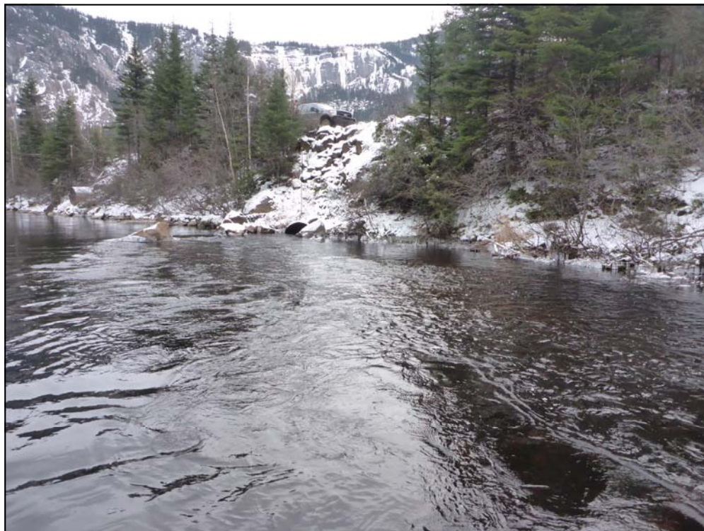
Photo 18. Ponceau n° 2 (franchissable) à l'extrémité aval de la zone des travaux, rivière Nipississ, PM 52, 16 novembre 2017
