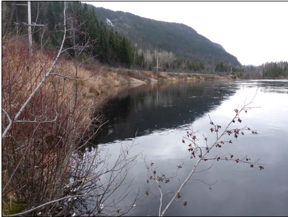
Photo 1. Vue vers l'aval de la berge à stabiliser, rivière Nipissis, PM 36, 9 novembre 2017
