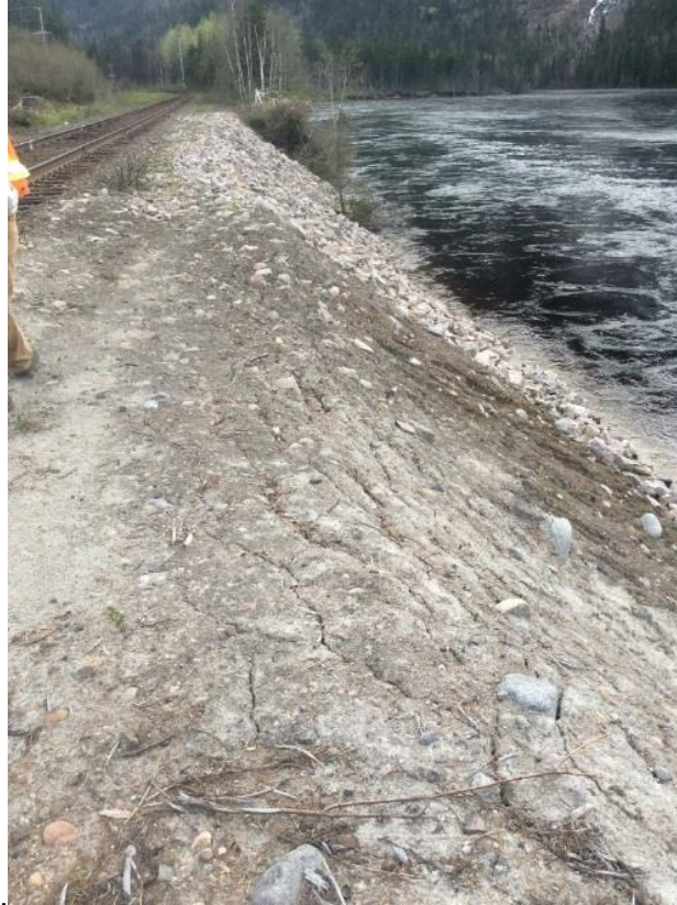
Figure 3.1 Fissures de tension en haut de talus le long de la section composée de sable fin (BGC, 22 mai 2017)
