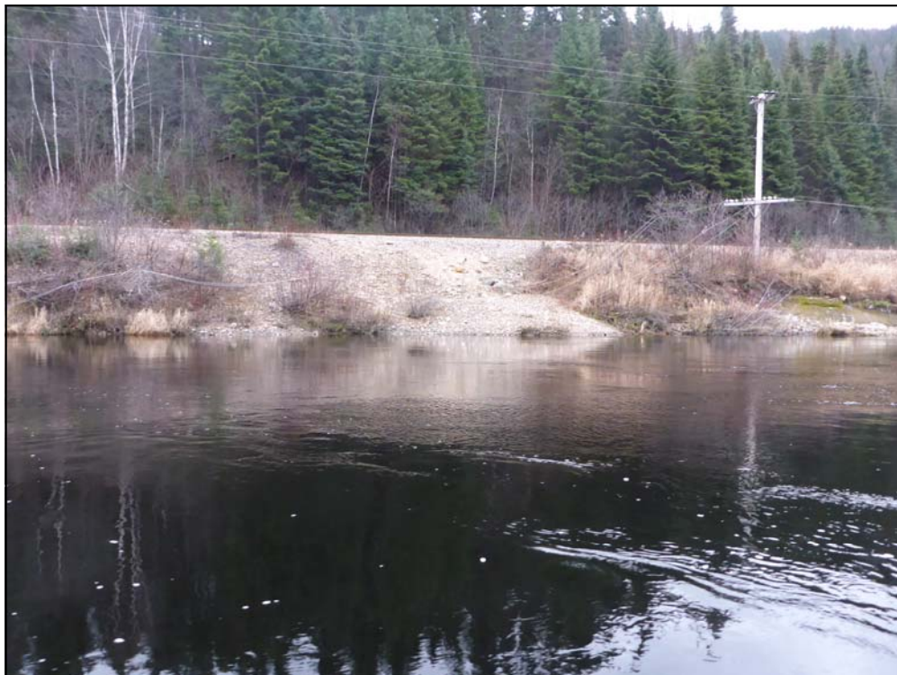
Photo 10. Fil électrique tombé sur le long de la berge, rivière Nipissis, PM 36, 9 novembre 2017
