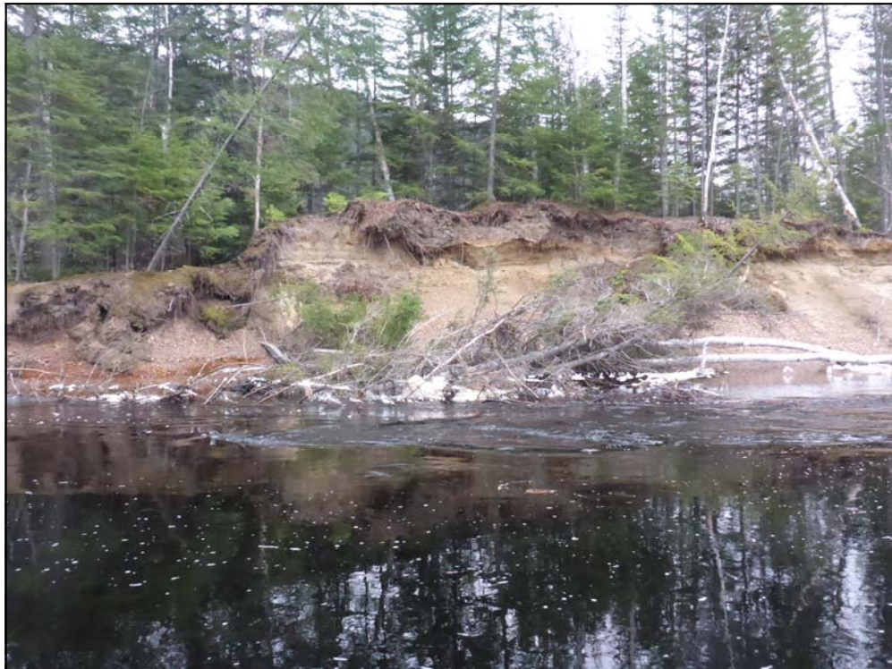
Photo 4. Foyer d'érosion n° 2 en aval de la zone des travaux, rive droite de la rivière Nipissis, PM 36, 9 novembre 2017
