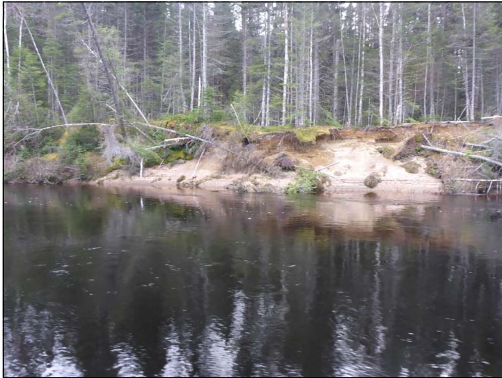
Photo 5. Foyer d'érosion n° 3 en aval de la zone des travaux, rive gauche de la rivière Nipissis, PM 36, 9 novembre 2017
