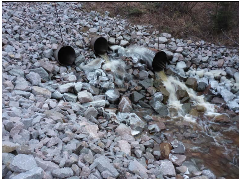
Photo 8. Ponceau triple (infranchissable) situé dans la partie amont de la zone des travaux, rivière Nipississ, PM 36, 9 novembre 2017
