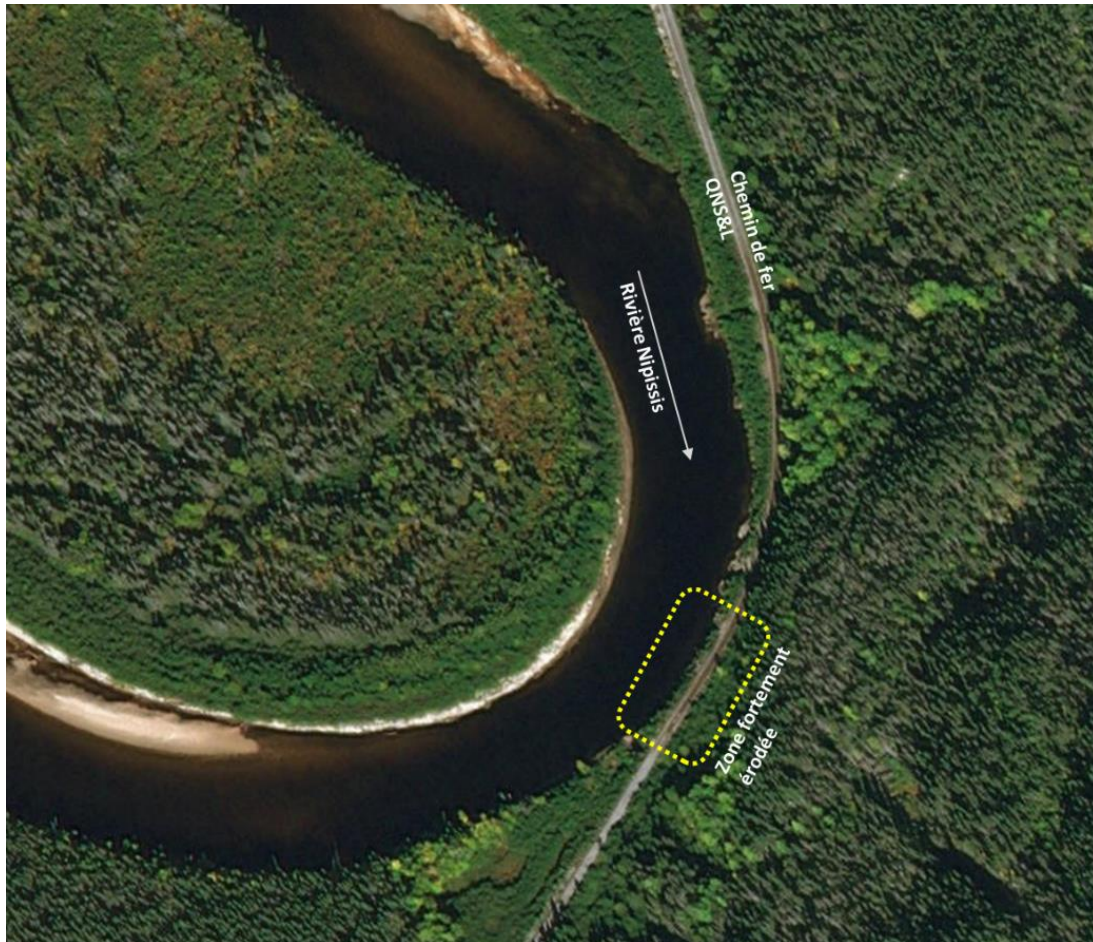
Figure 2.1 Localisation de la portion du chemin de fer au PM36 présentant des signes importants d'érosion
