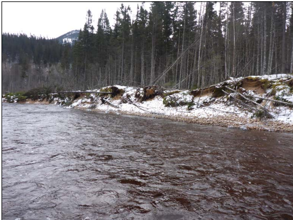
Photo 16. Foyer d'érosion n° 2 en aval de la zone des travaux, rive gauche de la rivière Nipissis, PM 52, 16 novembre 2017
