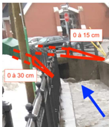
Figure 2 : Croquis des hauteurs requises à l'amont du pont de l'allée des Marchands
