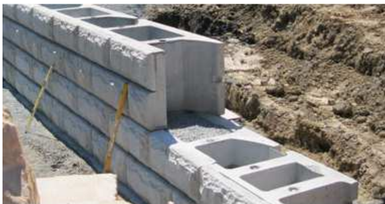
Figure 17. Façade du mur StoneStrong
