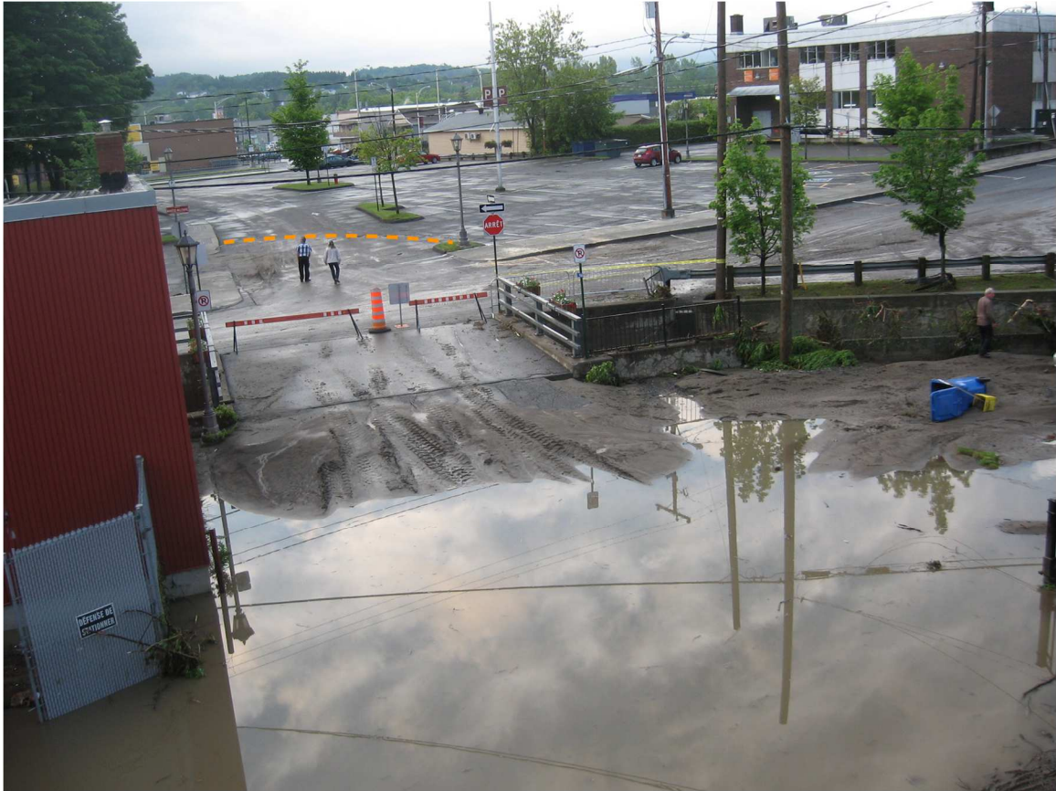
Figure 10 : Est du pont de l'allée des Marchands au lendemain de la crue de juin 2015
